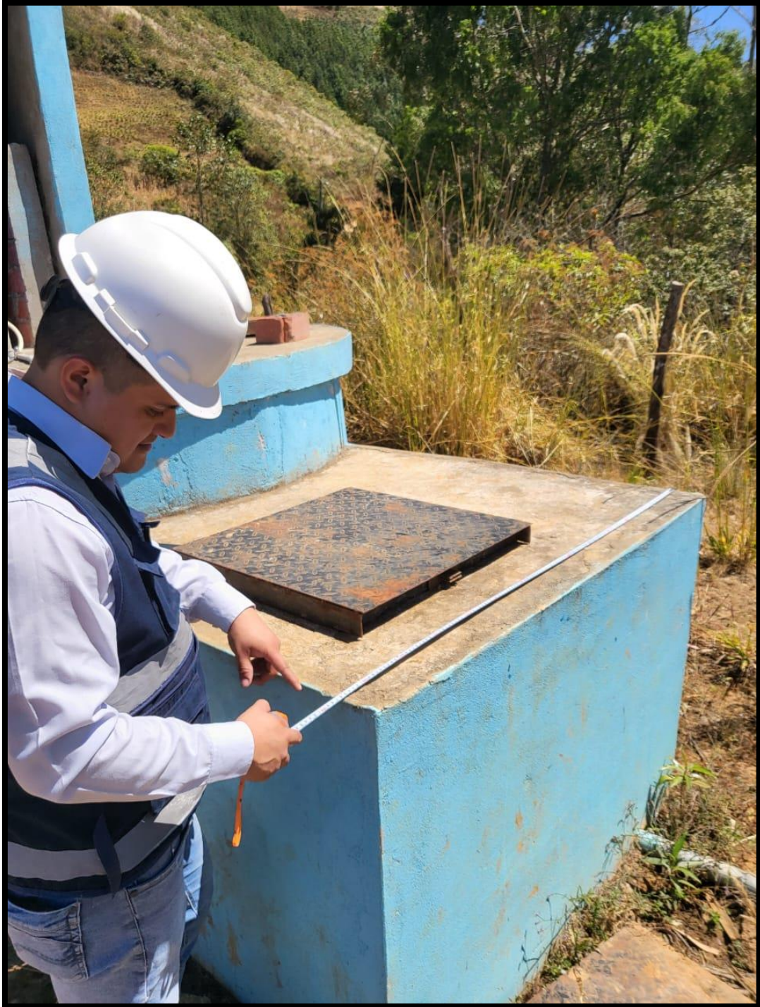
Figura 23: Alumno Avila –Evaluando la caseta de valvulas del reservorio
