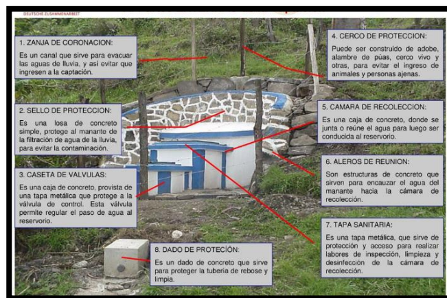
Figura 9: Cámara de captacion
