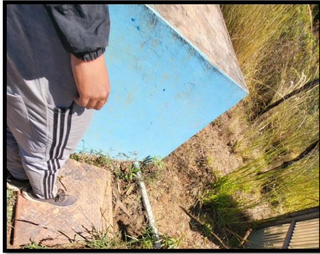
Figura 24: Alumno Avila evaluando la tubería de aducción
