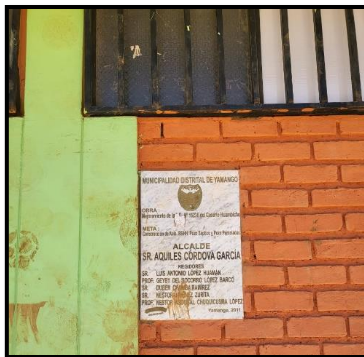
Figura 27: Colegio de huambiche que se abastece del sistema de agua potable
