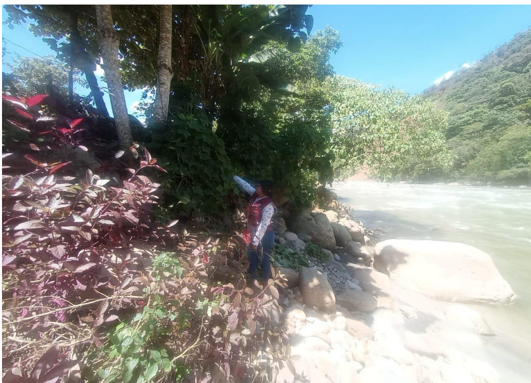
Figura 26: Verificando vegetación en el talud
