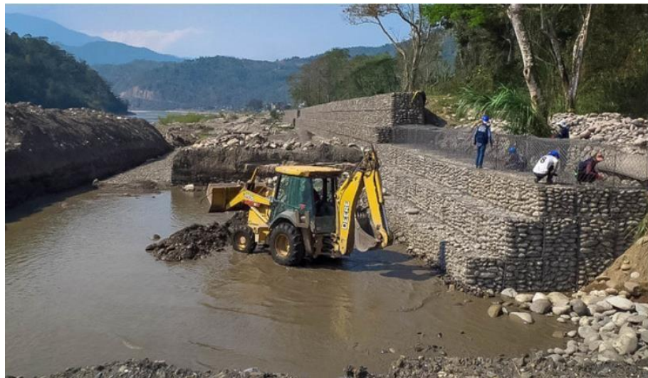
Figura 11: Defensa ribereña con el uso de gaviones
