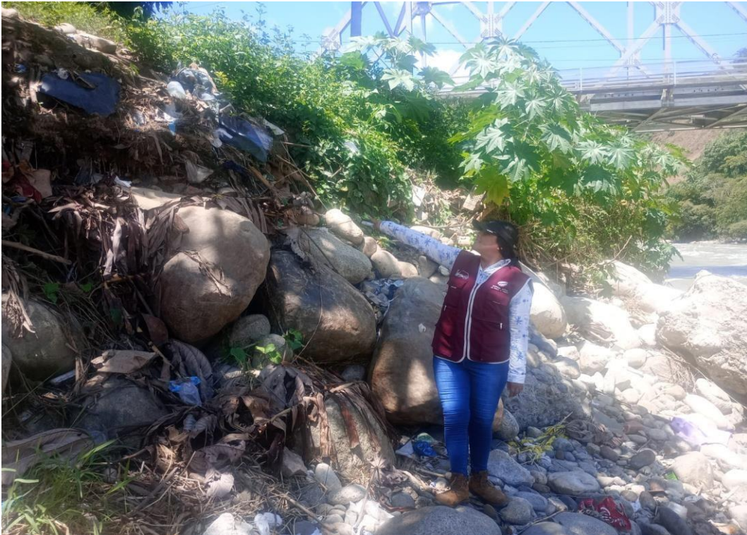
Figura 27: Presencia de residuos sólidos en el tramo 0+150
