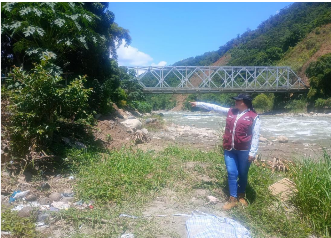
Figura 28: Verificando tramo 0+170, presencia de maleza
