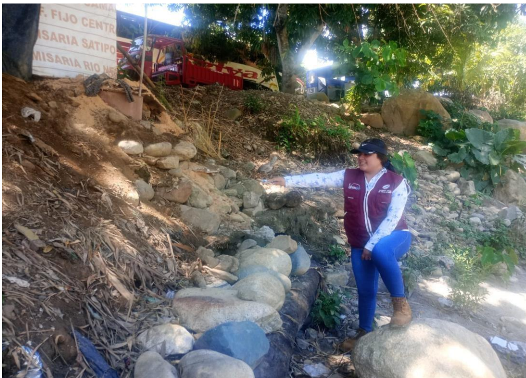
Figura 25: Verificando desmonte en talud
