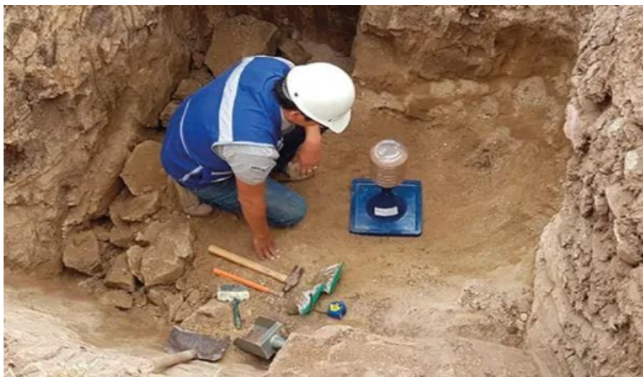
Figura 15:Realizando la densidad de campo
