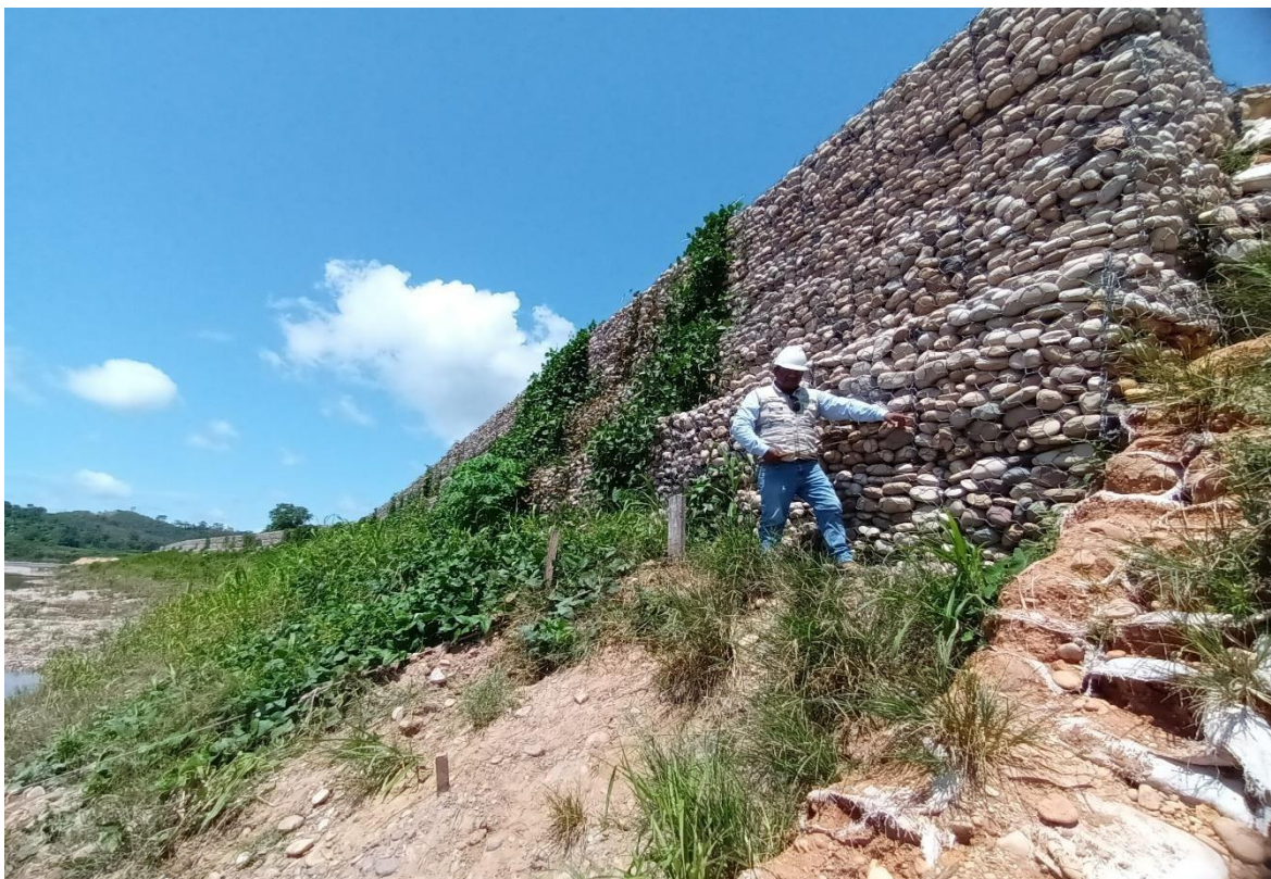
Ilustración 6: Muro de Gaviones
