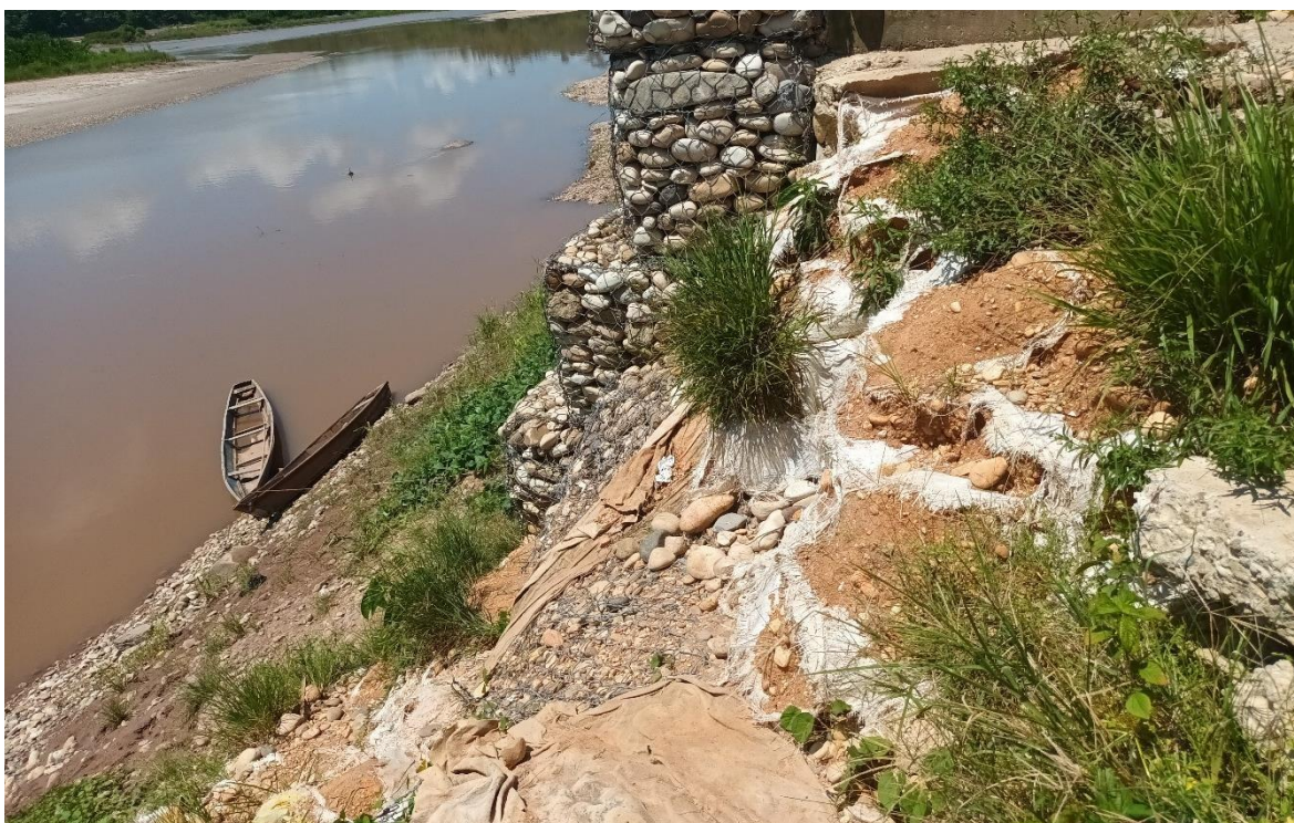
Ilustración 7: Empuje del muro de gaviones
