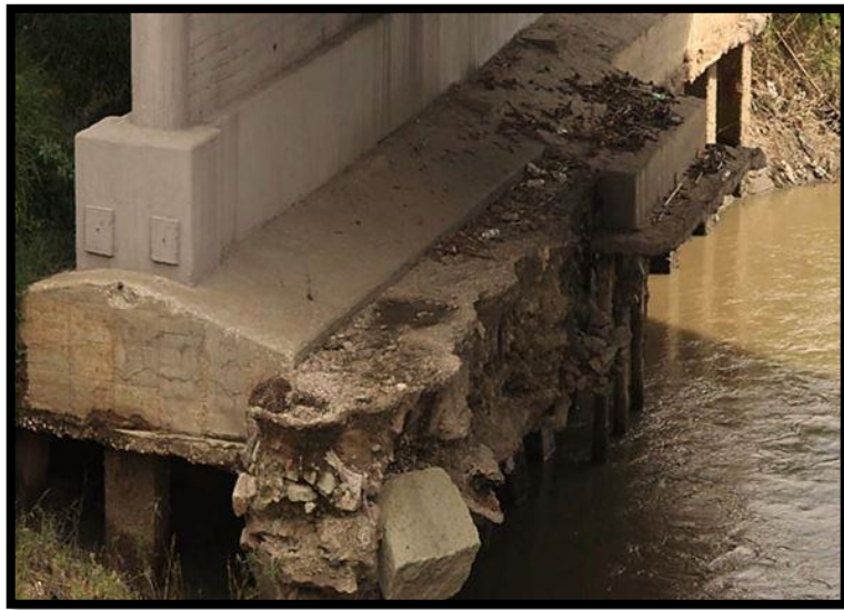
Figura 11: Socavación
