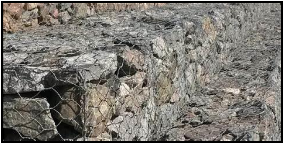
Figura 1: Evaluación del muro de gavión
