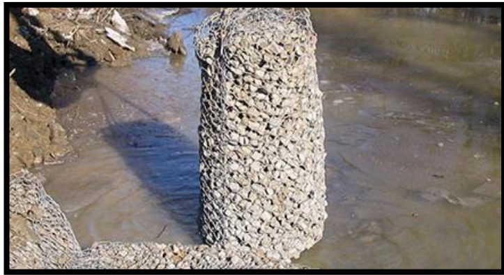
Figura 10: Gavión tipo saco
