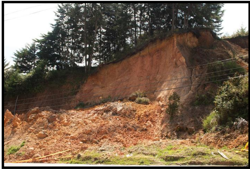
Figura 12: Erosión del suelo
