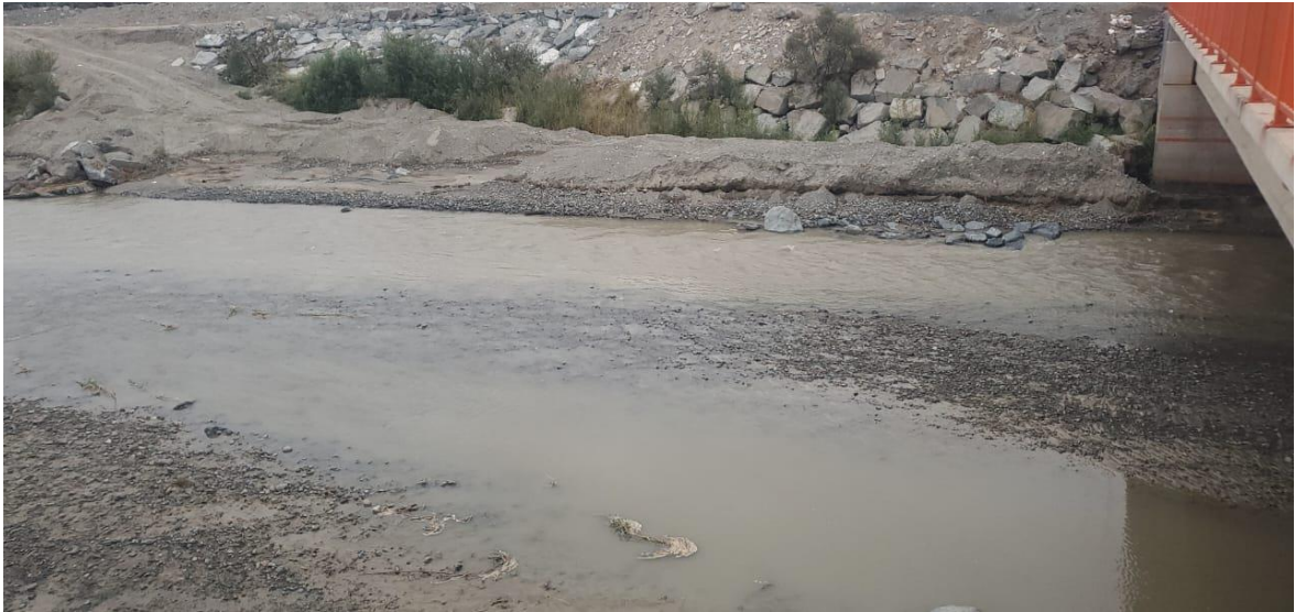
Figura 15: Vista panorámica de la defensa ribereña tipo enrocado
