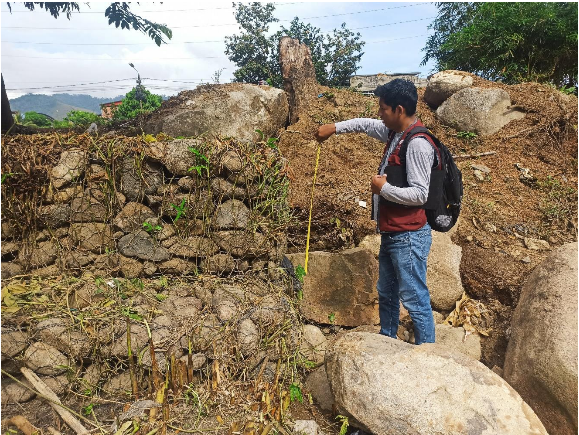
Figura 15: Tomando altura del muro de gavión del segundo nivel
