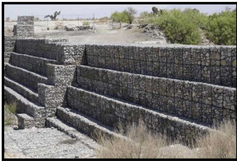
Figura 1: Evaluación de muros de gaviones
