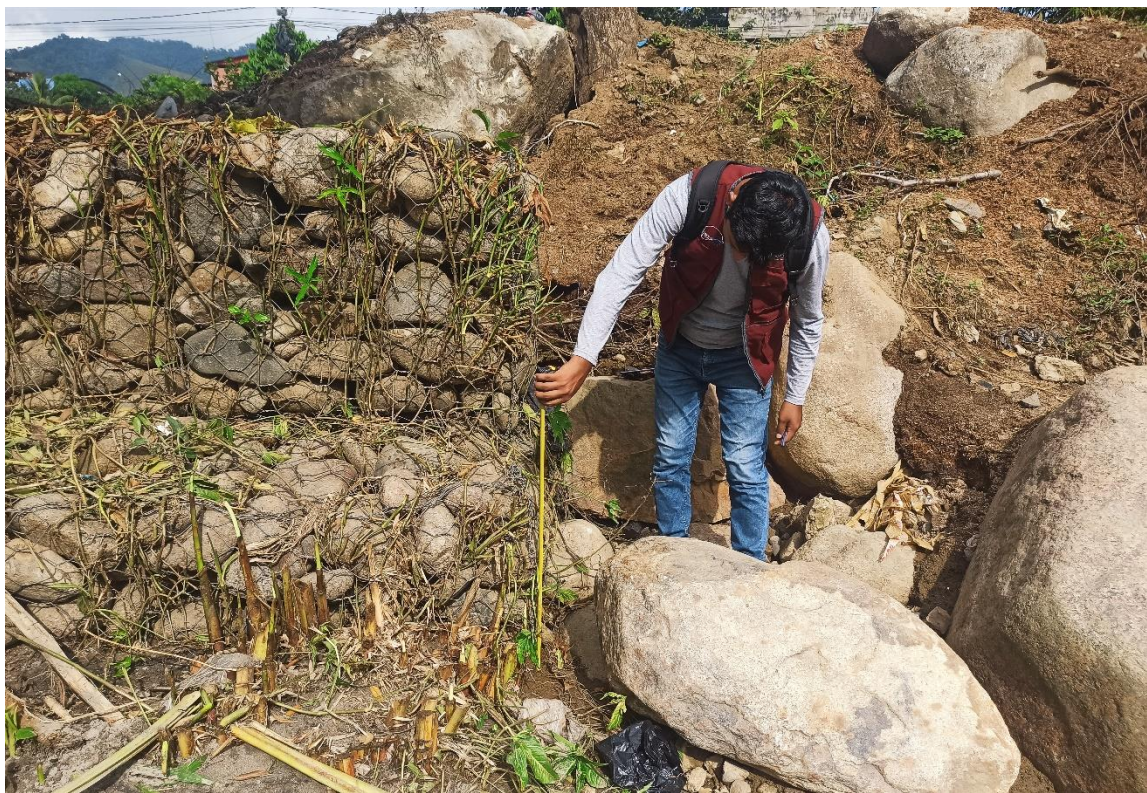
Figura 17: Tomando altura del muro de gavi3n del primer nivel
