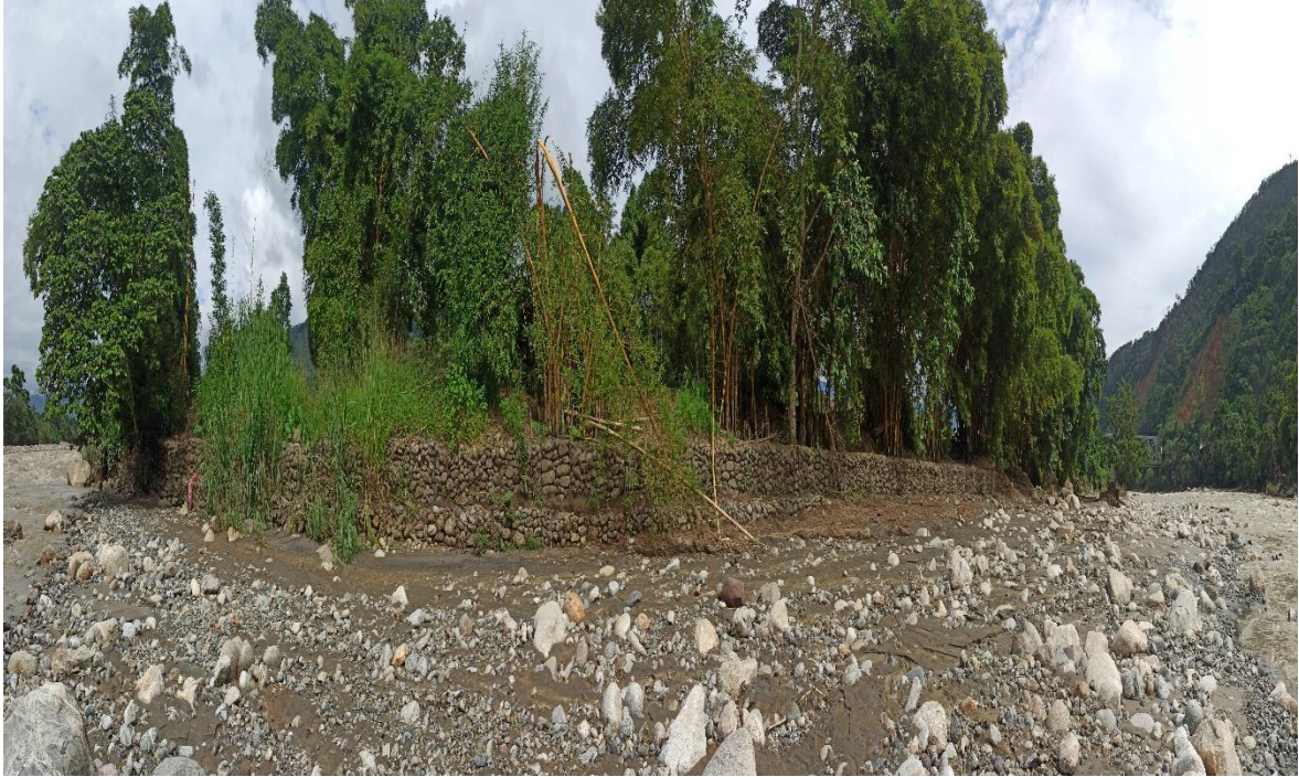
Figura 14: Vista panorámica del muro de gavión margen izquierdo del rio Satipo
