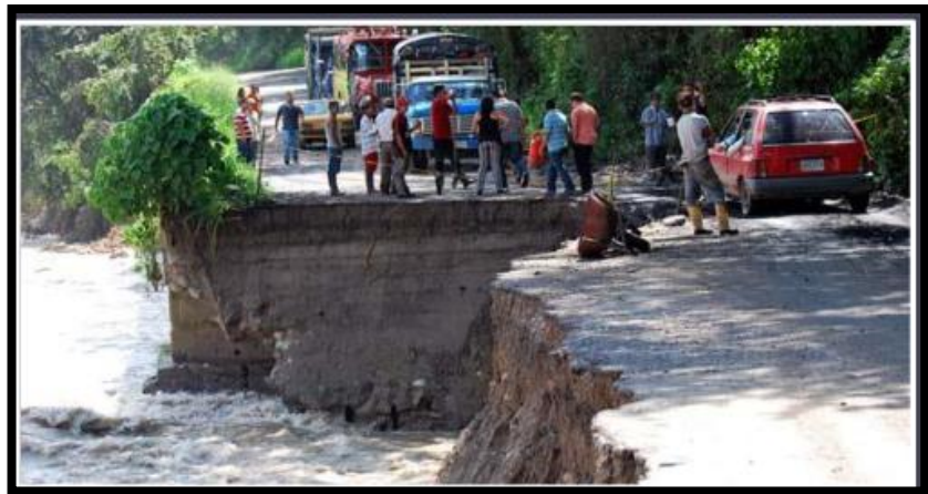
Figura 13: Socavación
