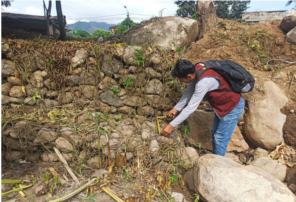
Figura 16: Tomando la anchura del muro de gavi3n del primer nivel
