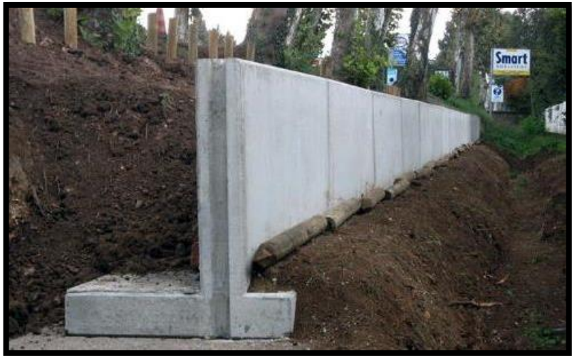
Figura 11: Muro de contención
