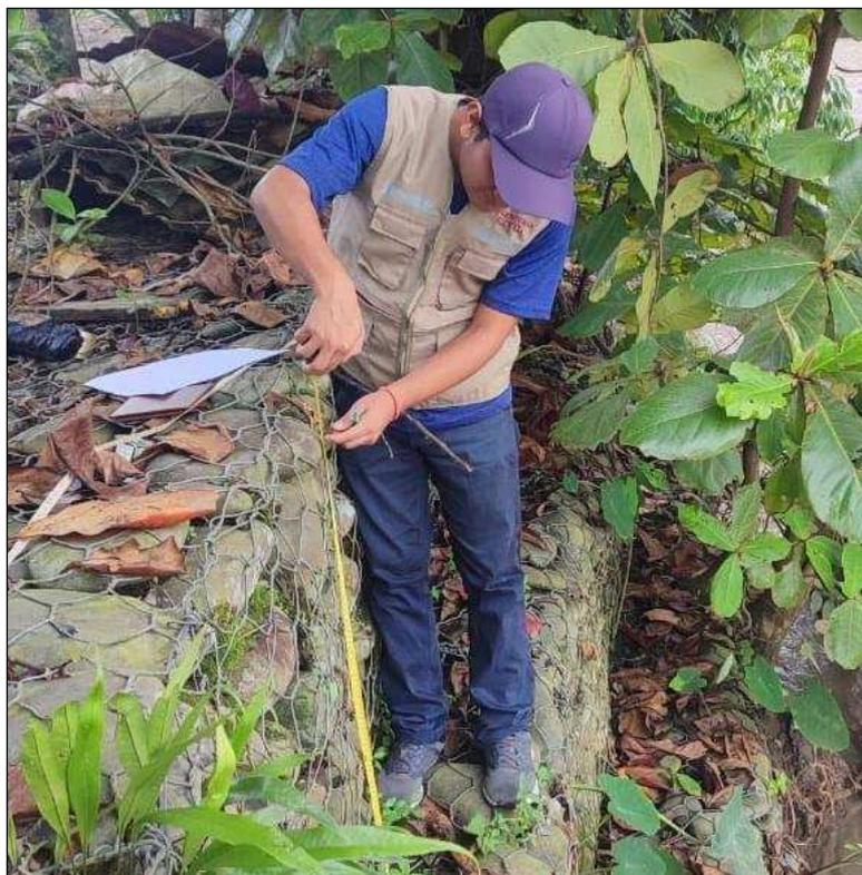
Figura 26 Prog. 0+010 se muestra la altura de la caja del muro de gavión que es 1m.
