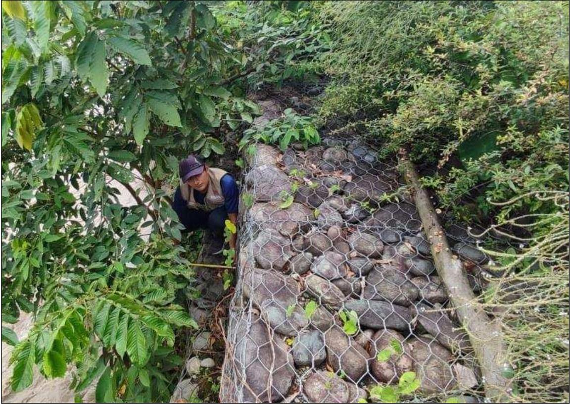
**Figura 31 Prog. 0+040 se muestra el ancho del segundo nivel de la caja del muro de gavión**
