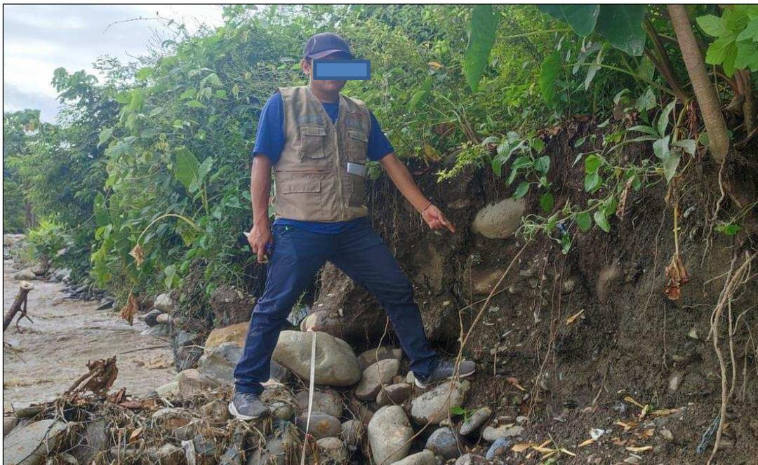
**Figura 28 Prog. 0+020 se muestra el muro de gavión que se desplomo 10m**
