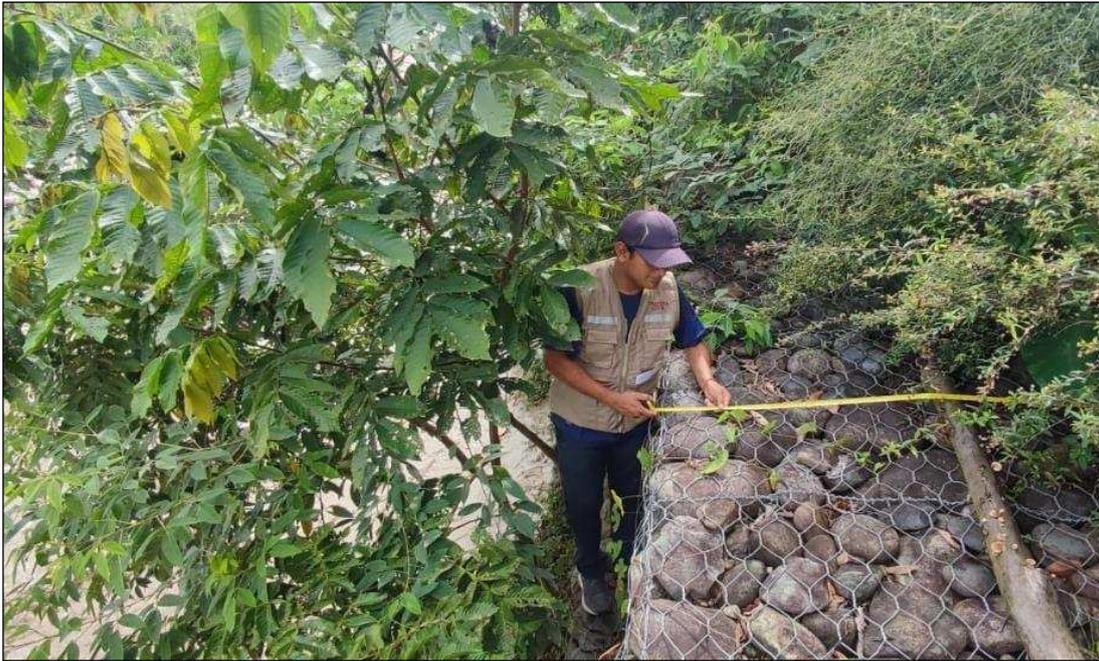
**Figura 29 Prog. 0+040 se muestra la tapa de la caja de gavi3n que mide 1.50m**
