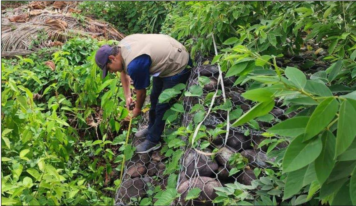
**Figura 33 Prog. 0+060 se muestra la altura del segundo nivel de la caja de gavi3n que mide 1.00m**
