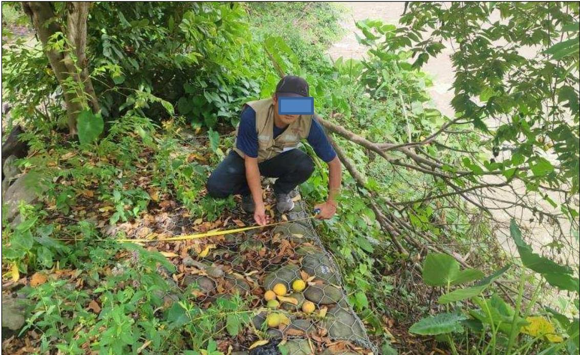
**Figura 32 Prog. 0+060 se muestra la tapa de la caja de gavión que mide 1.50m**
