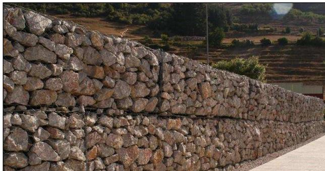
**Figura 01 Muro de gaviones**
