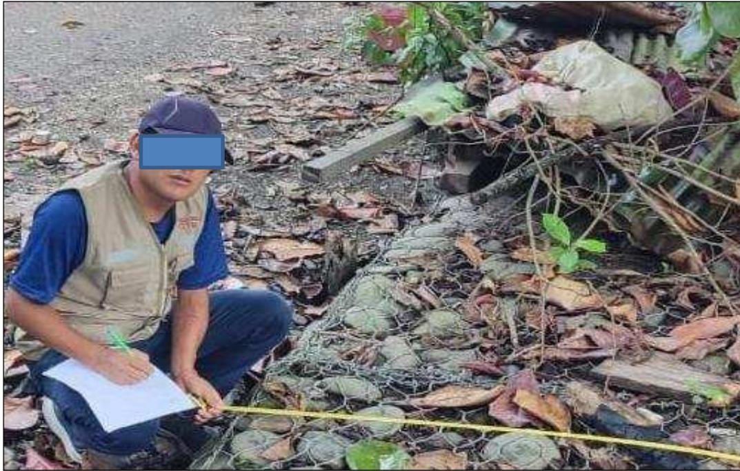
**Figura 27 Prog. 0+014 se muestra la tapa de la caja de gavión que mide 1.50m**
