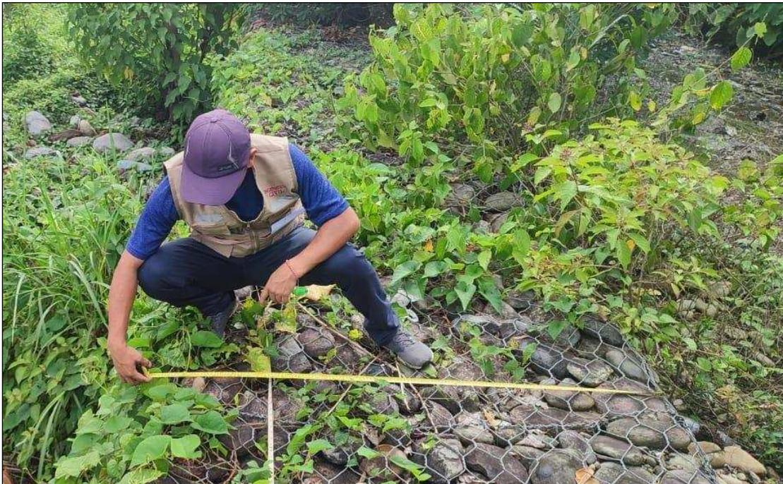
**Figura 34 Prog. 0+080 se muestra la tapa de la caja de gavi3n que mide 1.50m**
