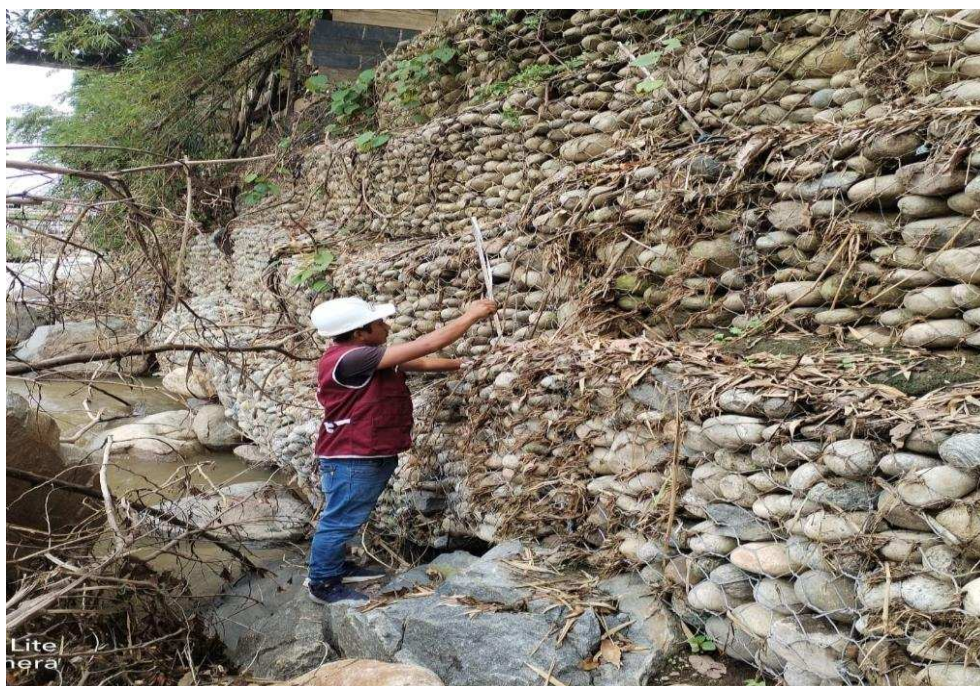
Figura 16:Realizando la medición de los gaviones
