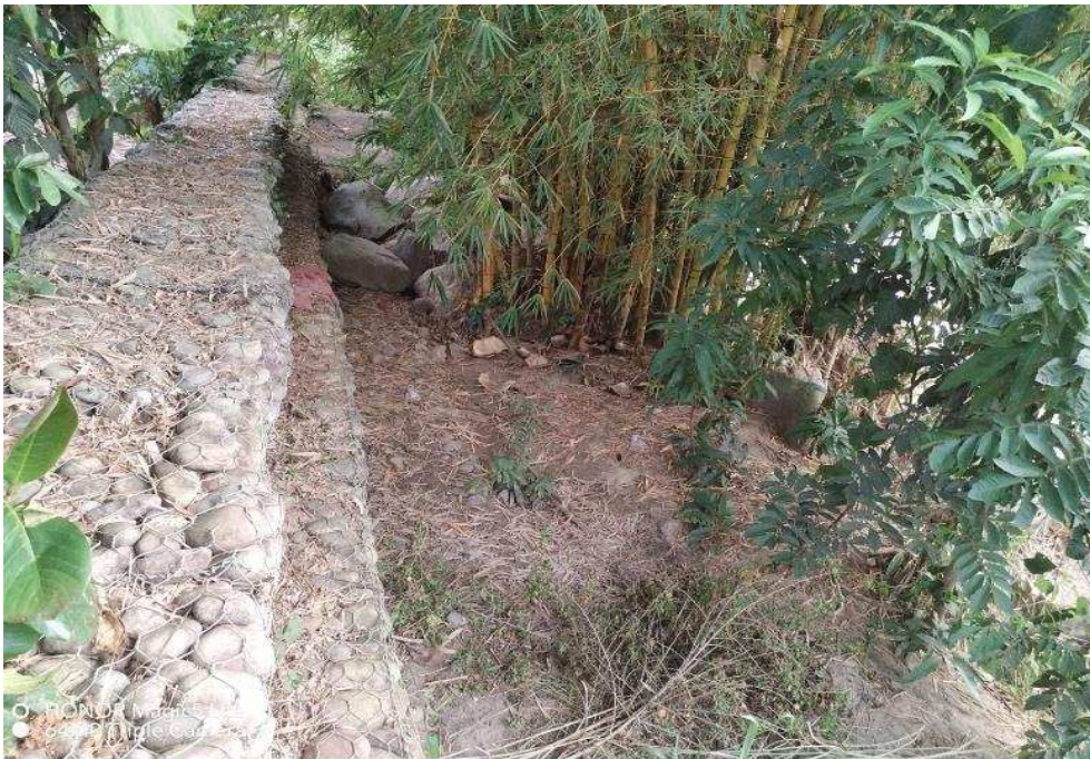
Figura 23: Verificando los gaviones en el tramo 0+080 a 0+0170
