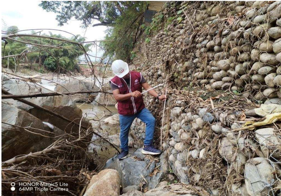
Figura 18: Verificando el espesor del Gavion
