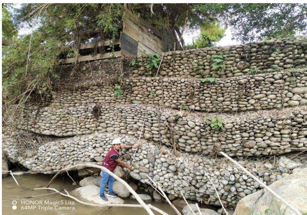
Figura 17:Realizando la medición de la altura de la estructura
