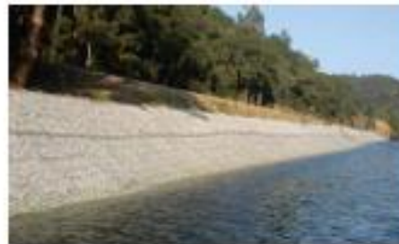
Figura 2. Gaviones para contención fluvial. Fuente: (A Bianchini, 2017).
