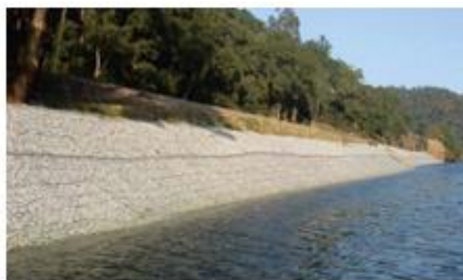
Figura 05: “Gaviones en uso para contención.”
