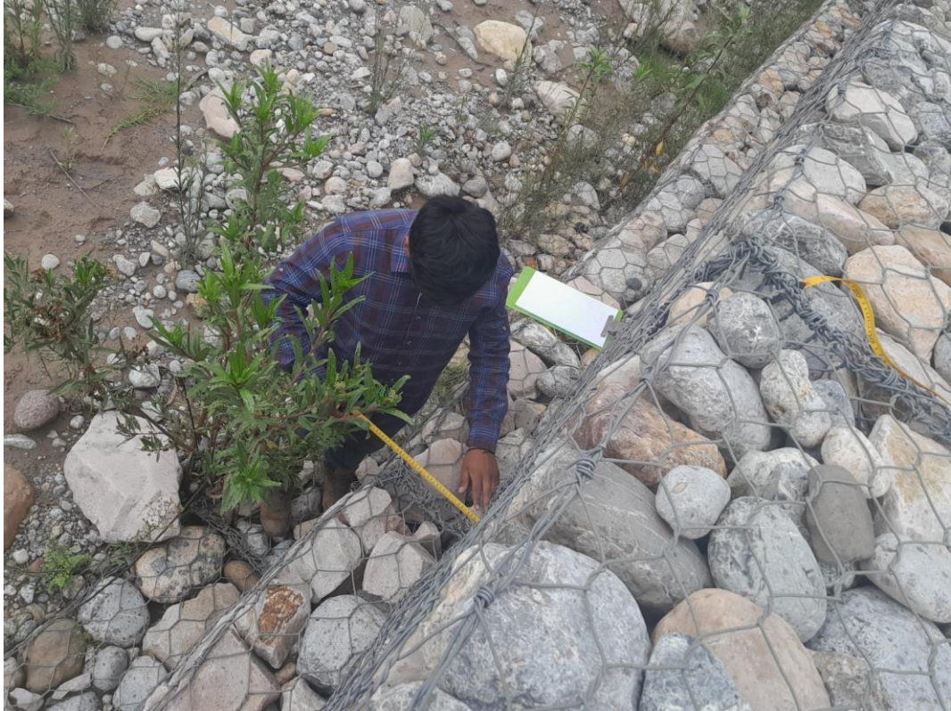
fotografía 09: Realizando medidas del muro de gaviones
