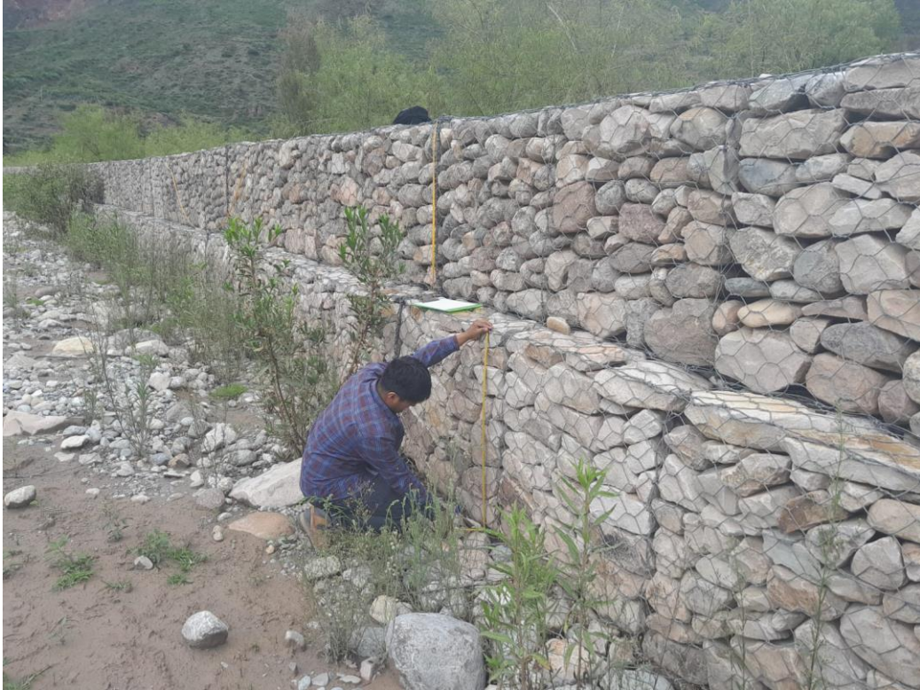
Fotografía 07: Realizando medidas de altura en el muro de gaviones
