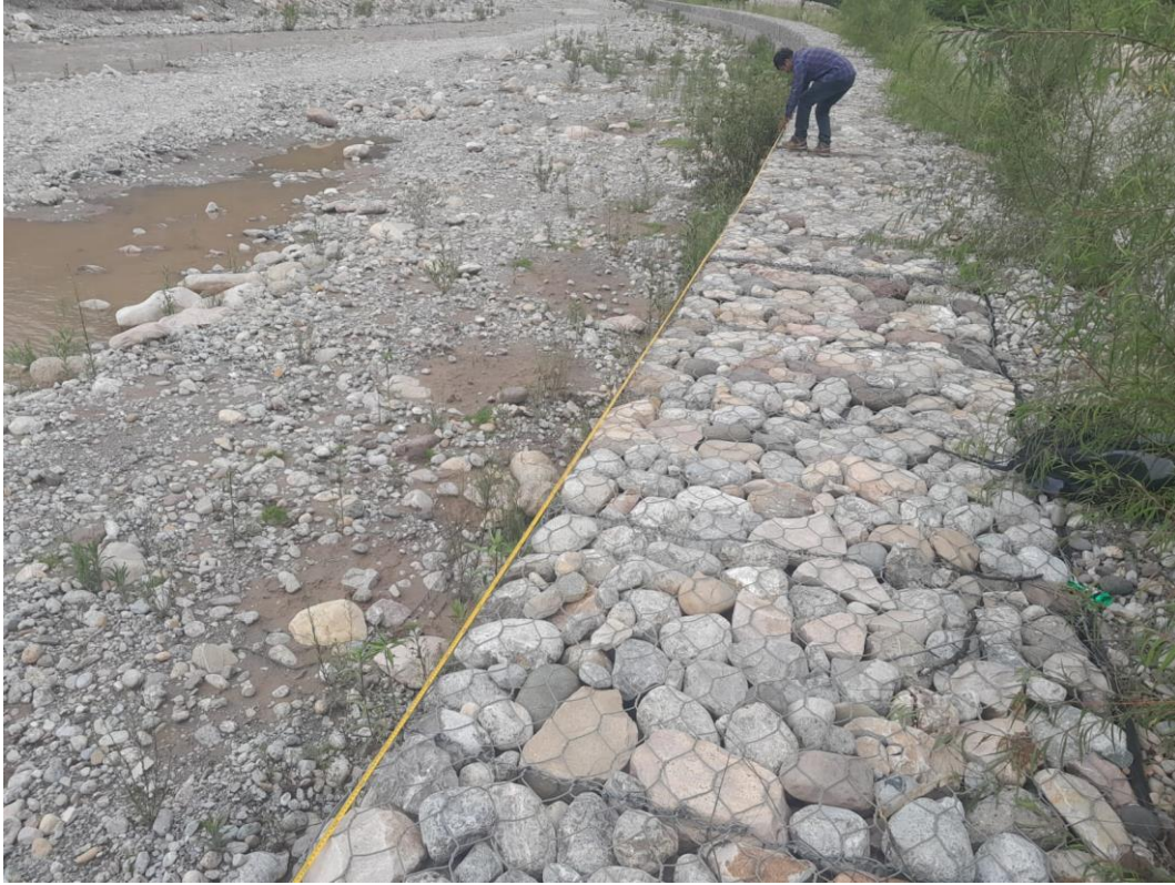
Fotografía 05: Tomando medidas del muro de gavión de largo cada 20 metros
