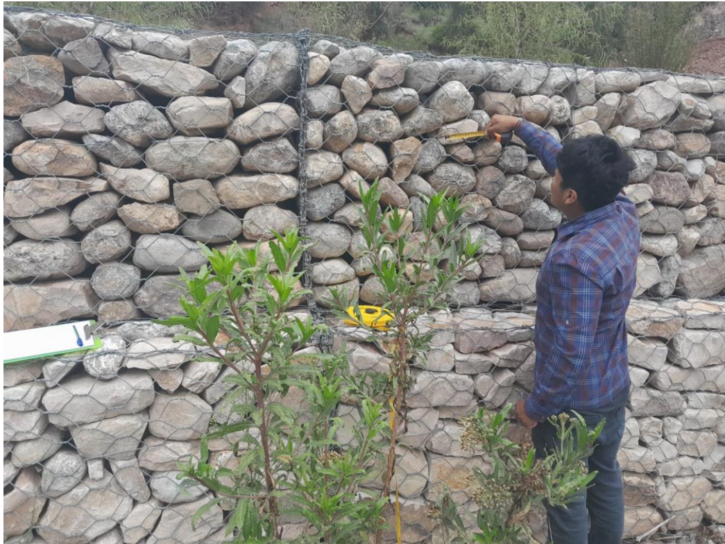
Fotografía 11: Realizando medidas de roca en el muro de gaviones.
