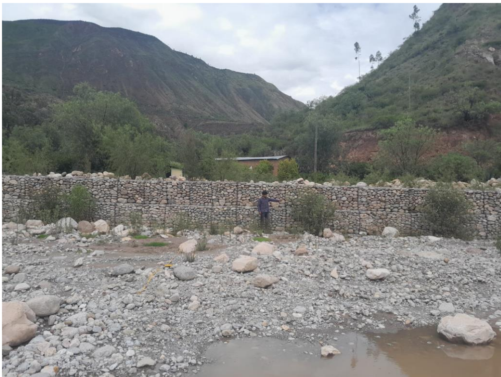
Fotografía 02: Se observa vegetación alrededor del muro de gaviones.
