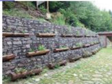
Figura 1. Estructura con gaviones. Fuente: http://www.solucionesespeciales.net/MedioAmbiente/Gaviones/Gaviones.aspx
