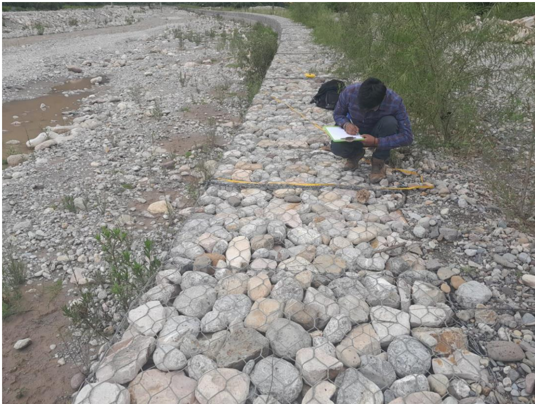
Fotografía 06: Tomando medidas del muro de gavión de ancho
