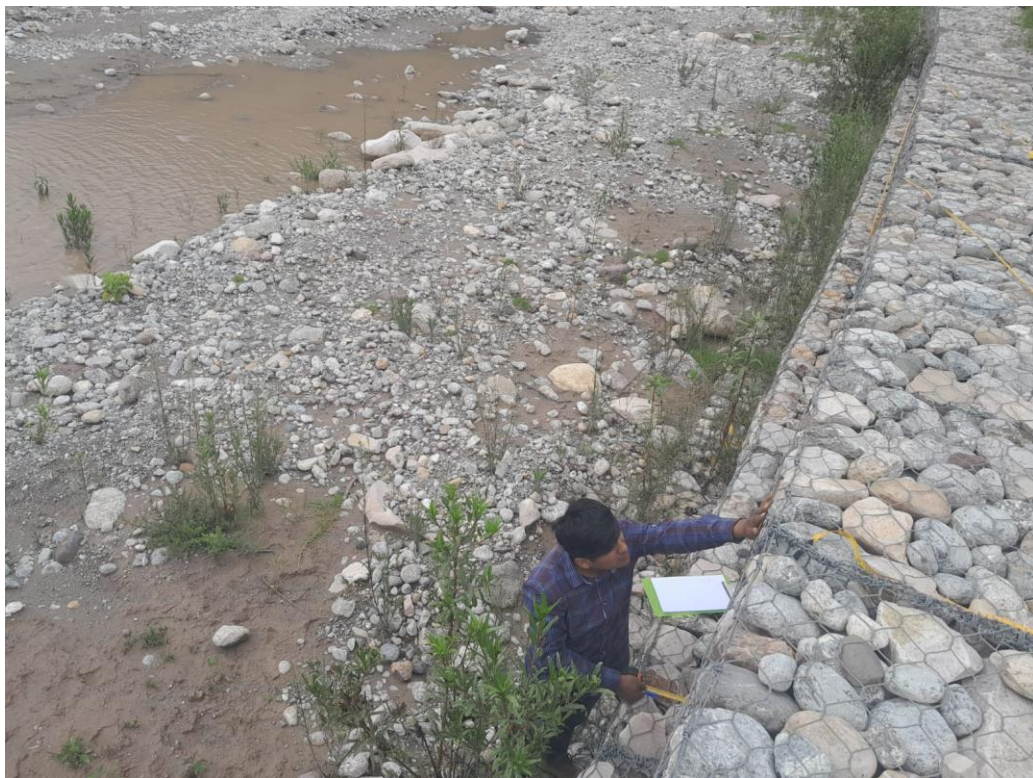
Fotografía 08: Realizando las medidas del muro de gaviones
