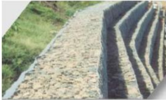
Figura 11: “Estructura gruesa en gaviones”
