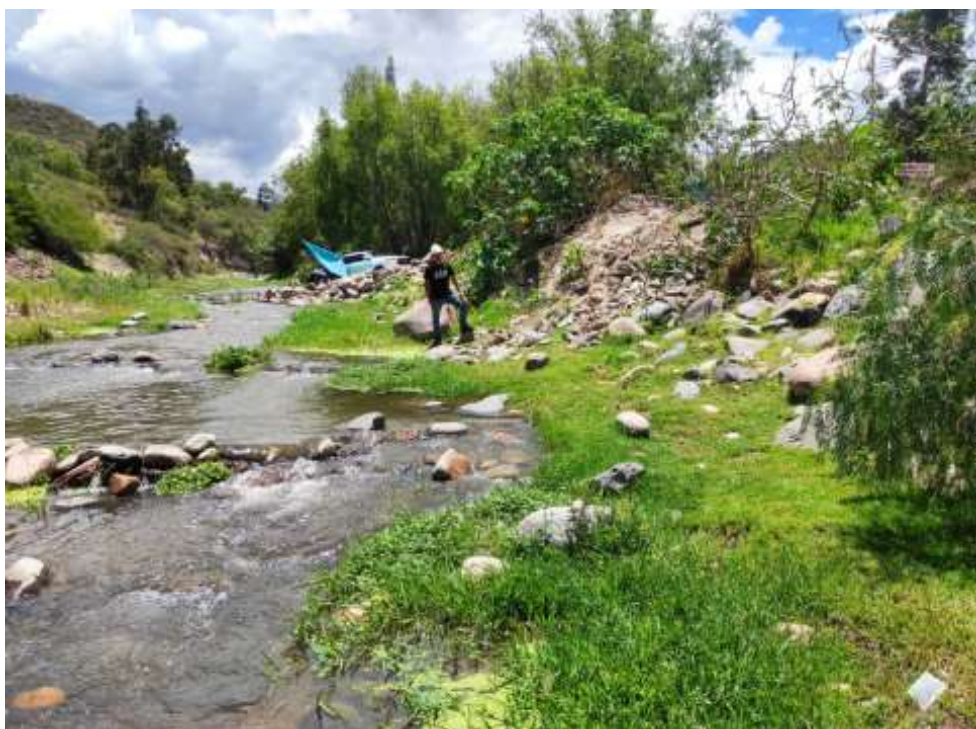
Figura 26: Inicio del evaluación de los muros de gaviones existentes. Fuente: Elaboración Propia.
