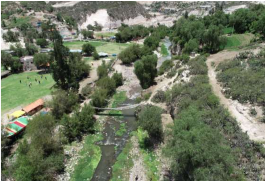
Figura 3: Inspección Aérea hecha con el Dron. Fuente: Elaboración Propia.
