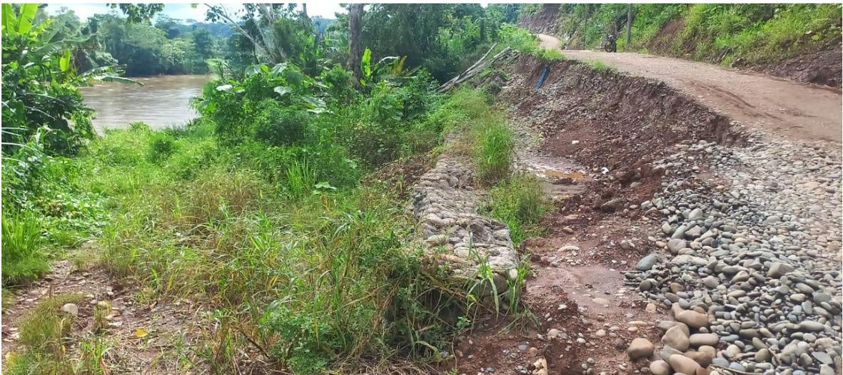
Figura 17: Se observa el muro de gavión repleto de vegetación en su alrededor
