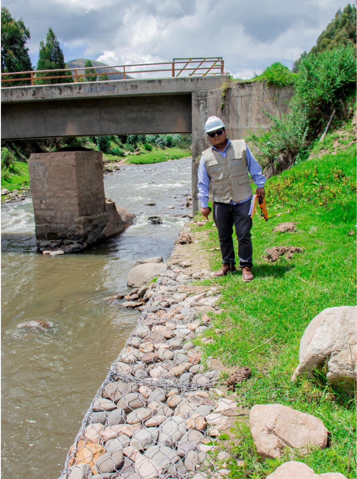
Figura 15: Vista panorámica del puente del centro poblado Anchaqwasi
