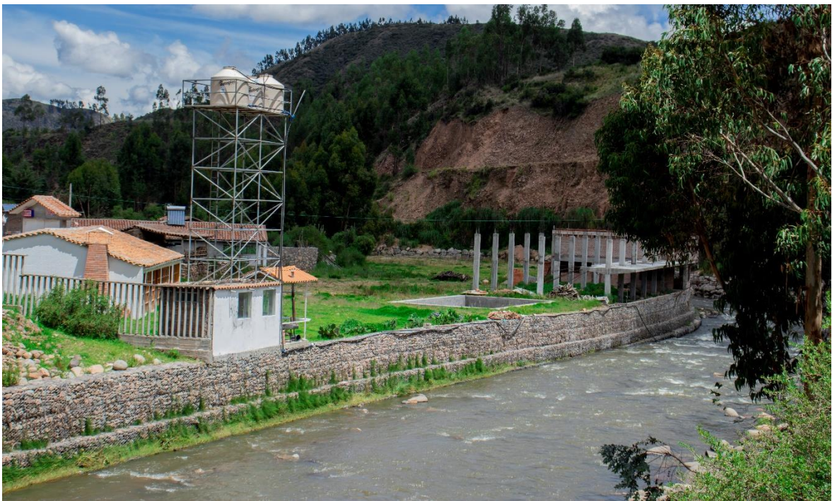
Figura 14: Se observa una defensa ribereña de 3 niveles
