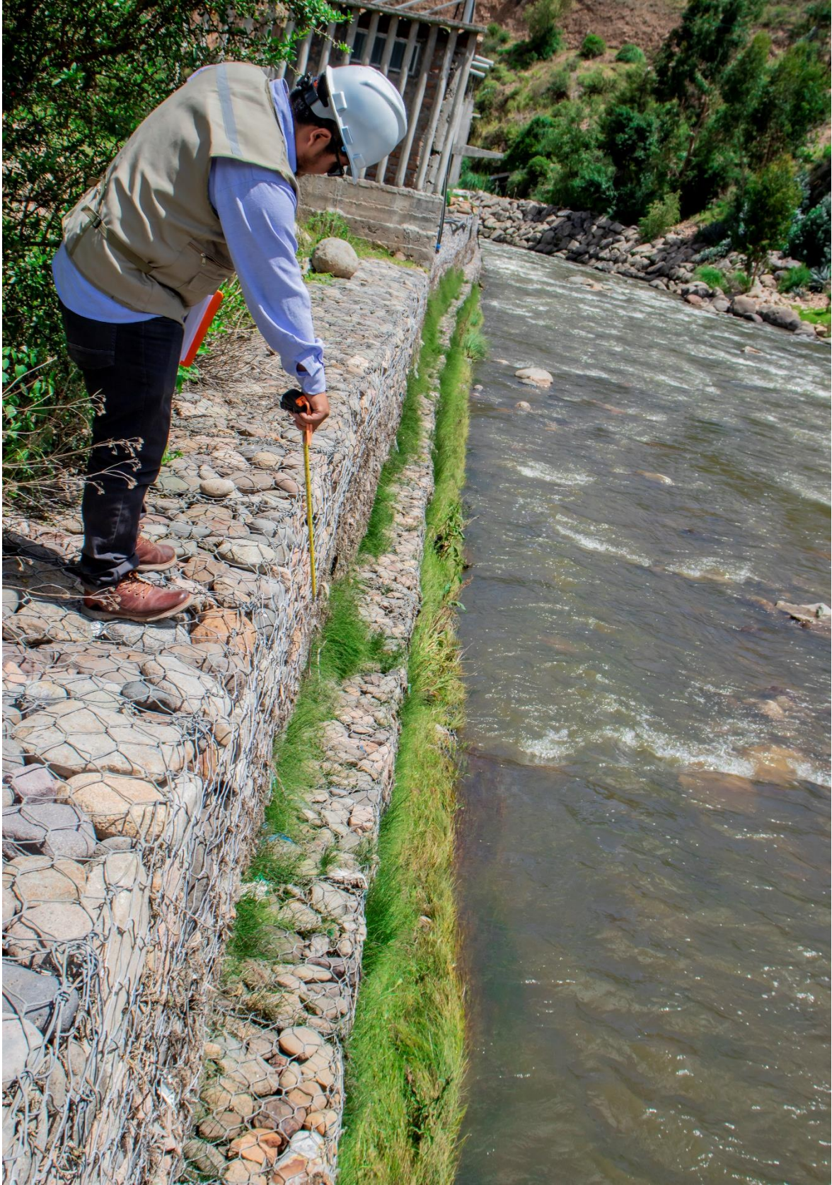
Figura 17: Tomando altura del 3 nivel del muro de gavion
