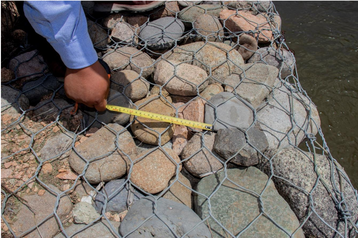
Figura 19: Tomando medida de la abertura de la malla de alambre galvanizado
