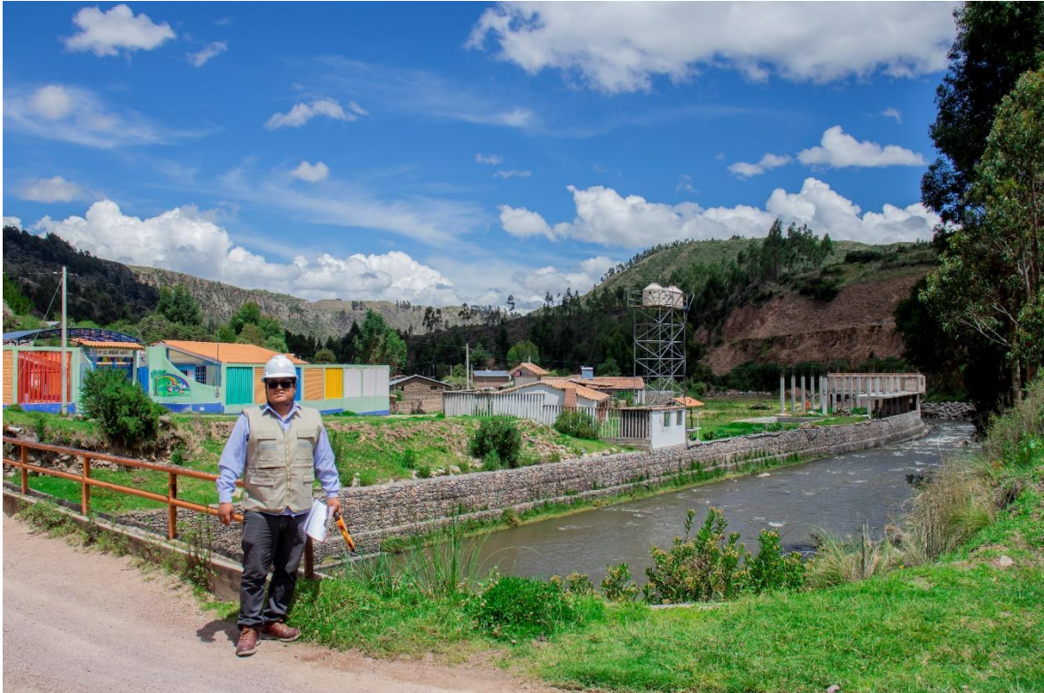
Figura 12: vista panorámica de la defensa ribereña tipo caja
