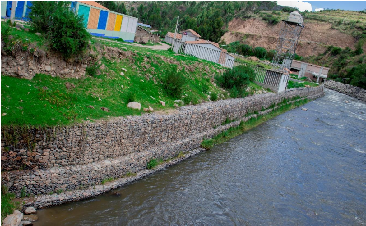
Figura 13: La defensa ribereña a evaluar tiene un largo de 100 metros lineales
