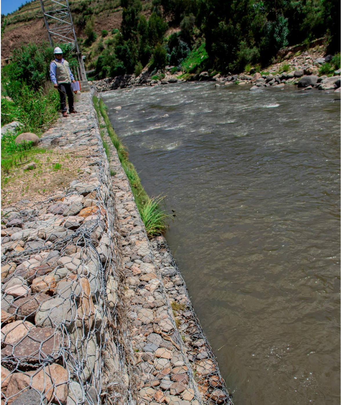
Figura 16: Podemos observar una defensa ribereñas de 3 niveles con diferente medidas
