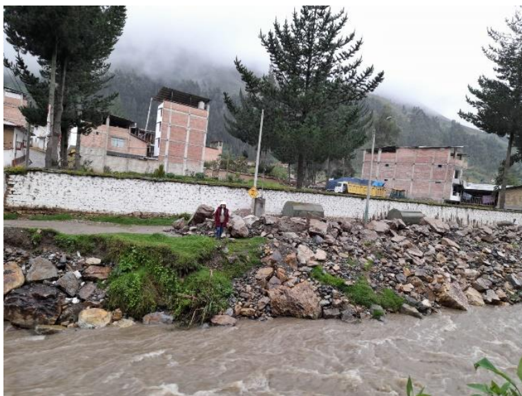
Figura N° 2: Enrocado simple con roca colocada en la progresiva 0+020
