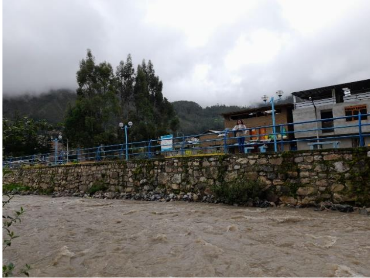
Figura N° 9: Enrocado consolidado con roca colocada en la progresiva 0+160
