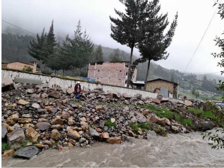
Figura N° 3: Enrocado simple con roca colocada en la progresiva 0+040
