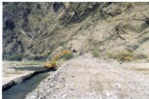
Foto N°4. Tractor iniciando armado de terraplén
