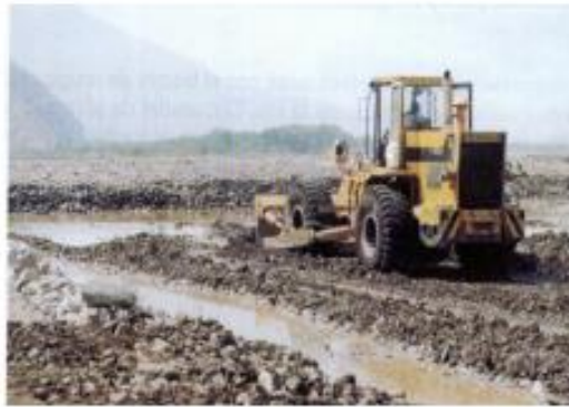
Foto N°3- Preparación de vía de acceso
