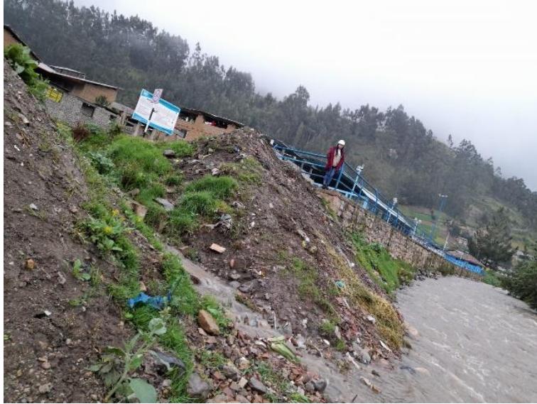
Figura N° 7: Enrocado simple con roca al volteo en la progresiva 0+120
