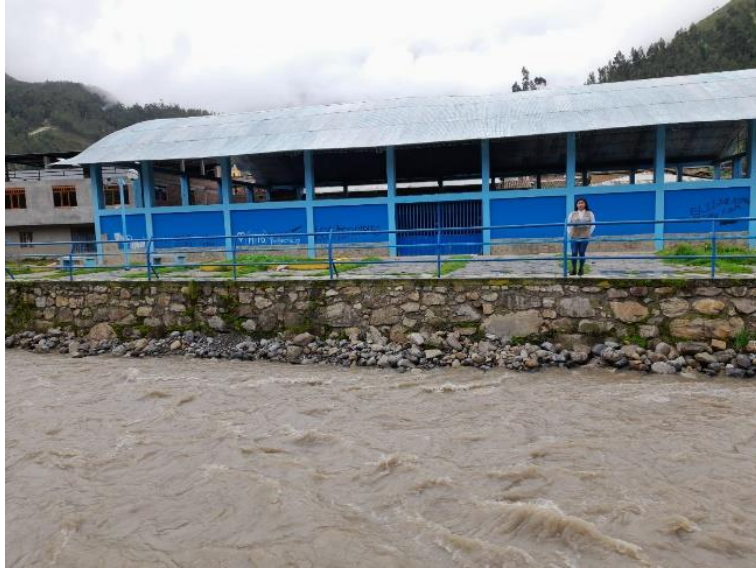
Figura N° 11: Enrocado consolidado con roca colocada en la progresiva 0+200 Fuente: Elaboración propia -2023.
