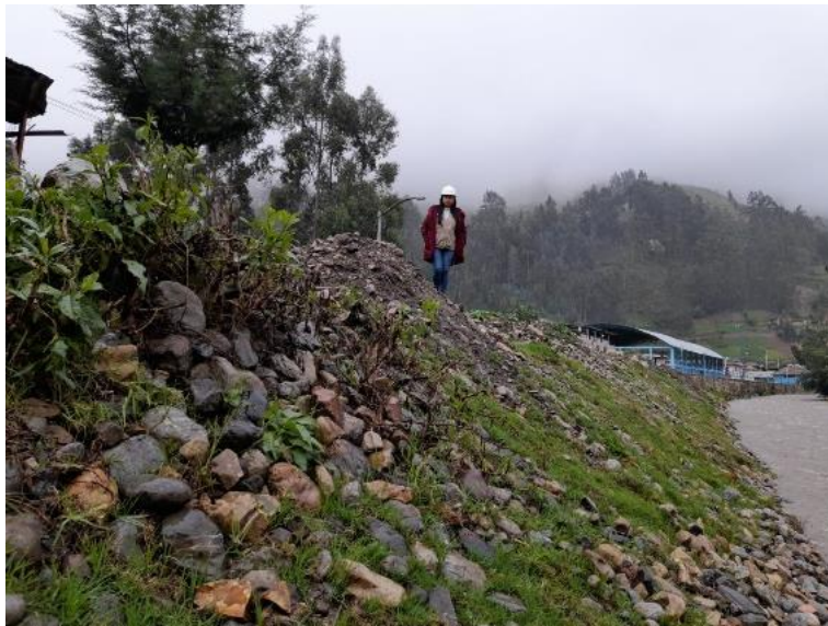
Figura N° 6: Enrocado simple con roca al volteo en la progresiva 0+100
