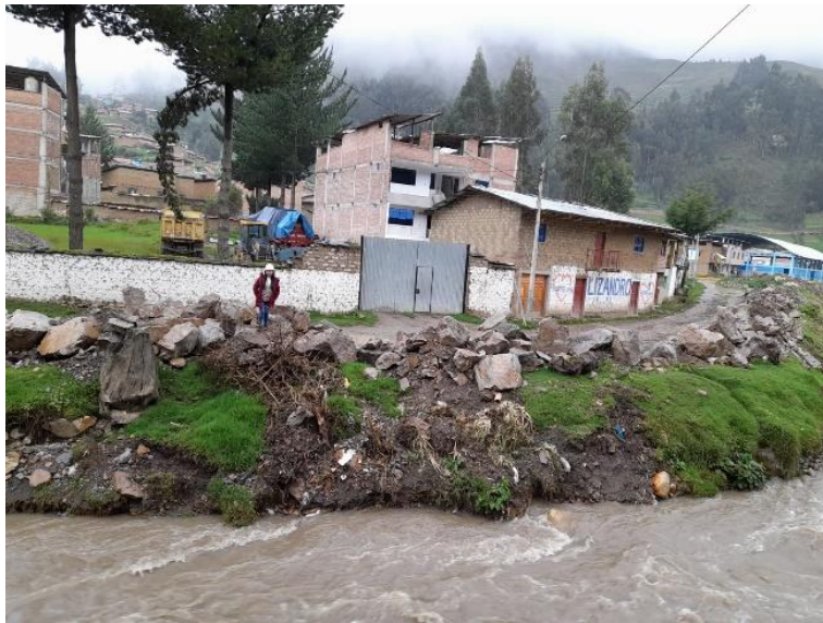
Figura N° 4: Enrocado simple con roca al volteo en la progresiva 0+060
