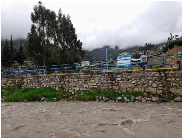
Figura N° 8: Enrocado consolidado con roca colocada en la progresiva 0+140
