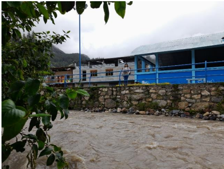
Figura N° 10: Enrocado consolidado con roca colocada en la progresiva 0+180
