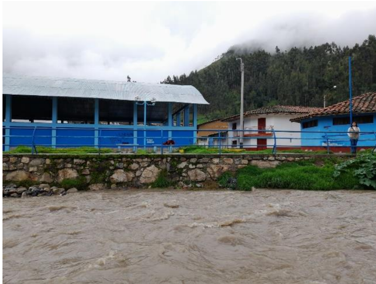
Figura N° 12: Enrocado consolidado con roca colocada en la progresiva 0+220 Fuente: Elaboración propia -2023.
