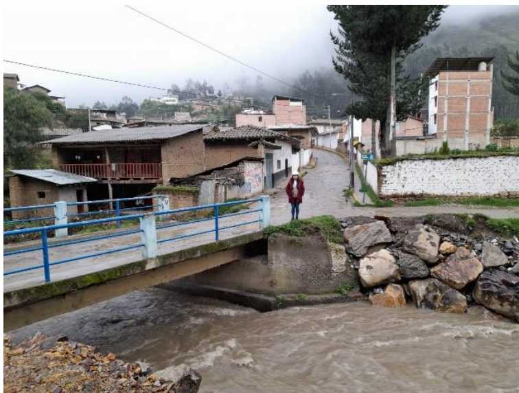
Figura N° 1: Enrocado simple con roca colocada en la progresiva 0+000
