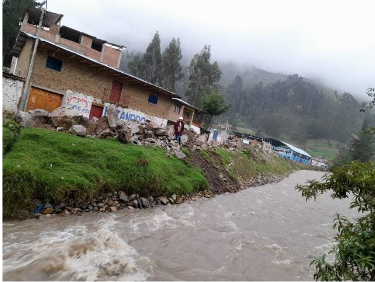
Figura N° 5: Enrocado simple con roca al volteo en la progresiva 0+080
