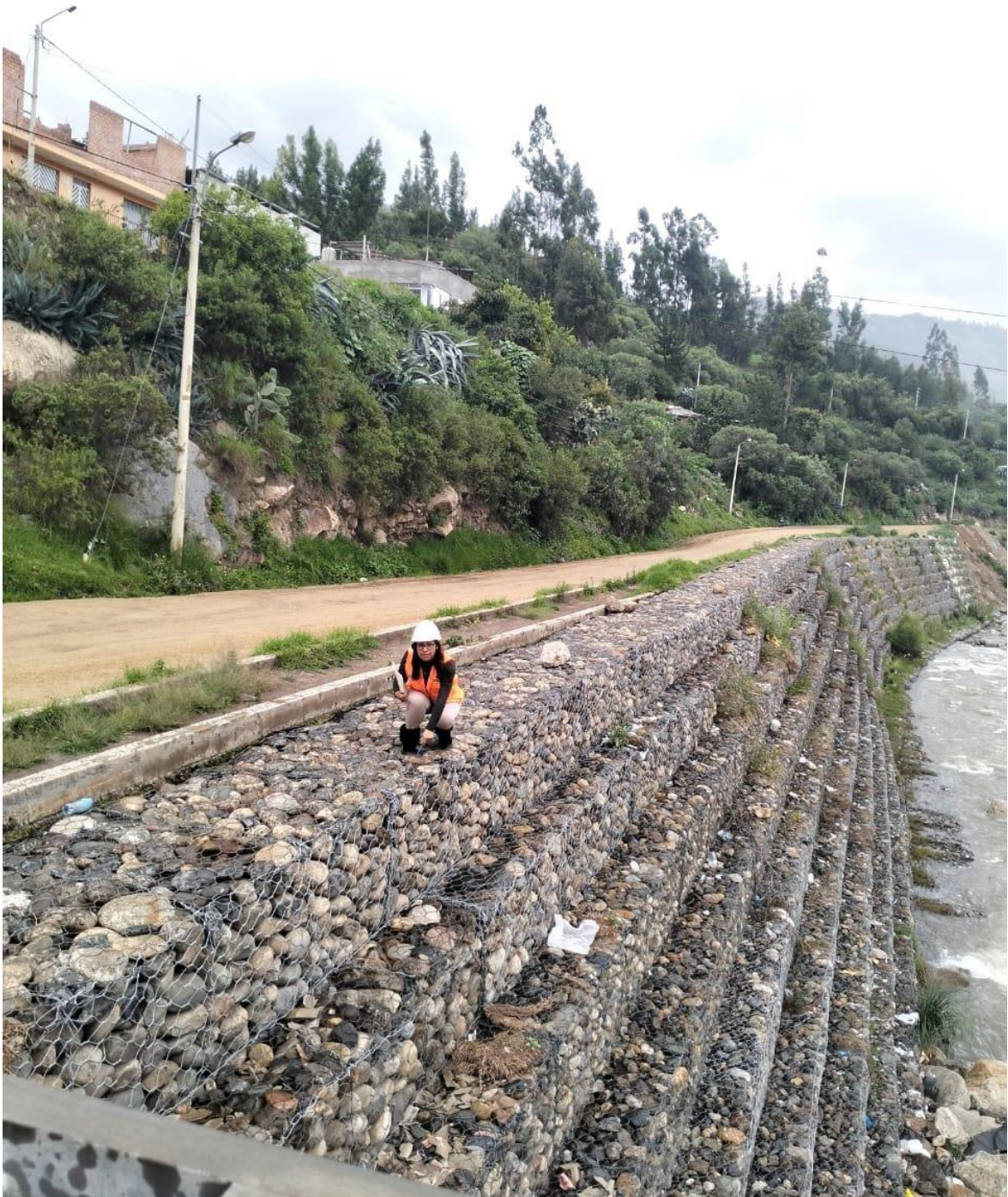
Figura 18: Recopilando datos de los diferentes niveles del muro de gavion
