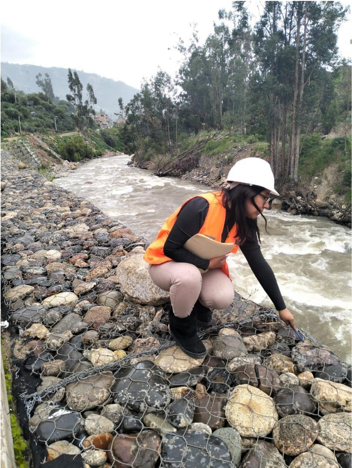
Figura 17: Inspeccionando estado la malla de alambre galvanizado
