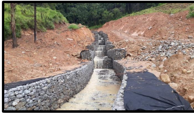
Figura 11: Diques de tierra
