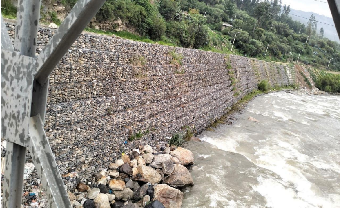
Figura 14: Vista de la defensa ribereña tipo caja 9 niveles
