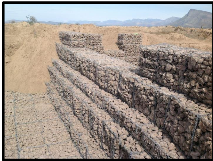
Figura 1: Estado actual del muro de gavión
