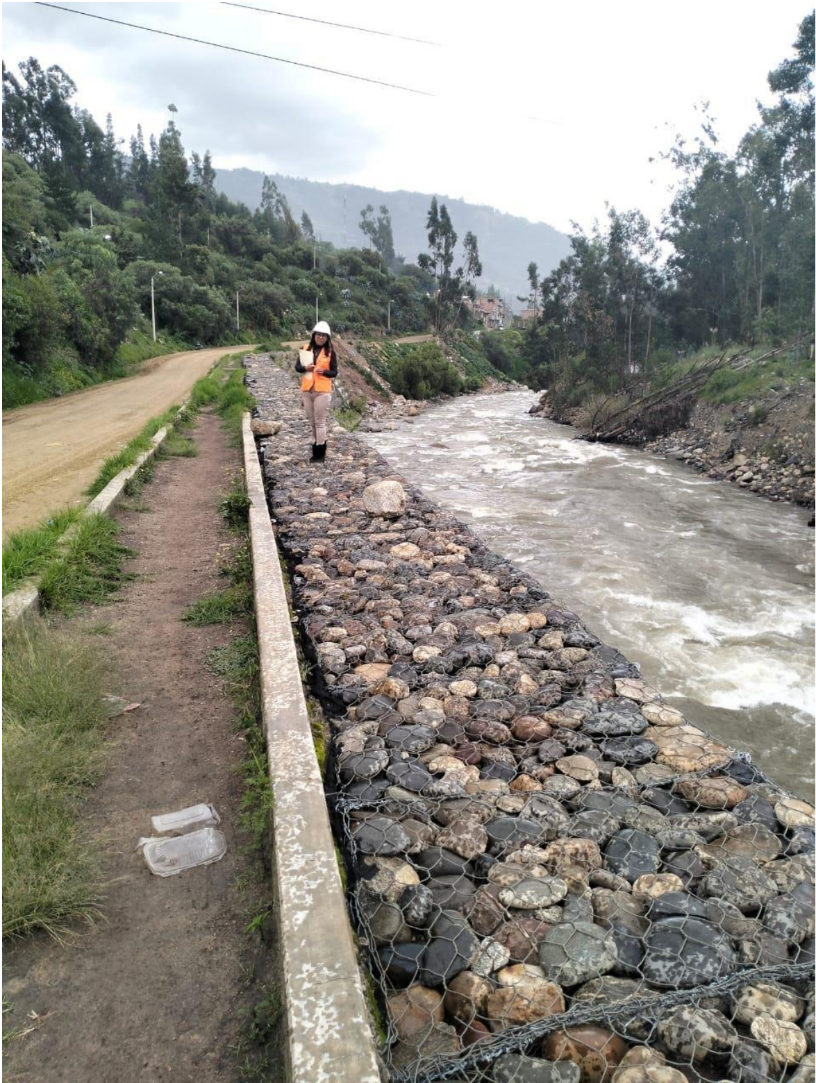
Figura 15: Vista panorámica del muro de gavión tipo caja
