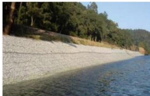
Figura 2. Gavión, para contención de taludes. Fuente: (A Bianchini, 2011)
