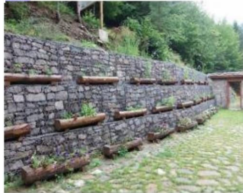
Figura 1. Estructura de gaviones. fuente.
