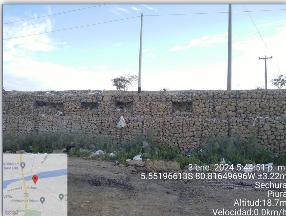
**Figura N° 09:** Se observa que, en el tercer bloque, uno de los encajonados no cuenta con material de relleno, esto debido a que la malla del panel frontal se encuentra rota.
