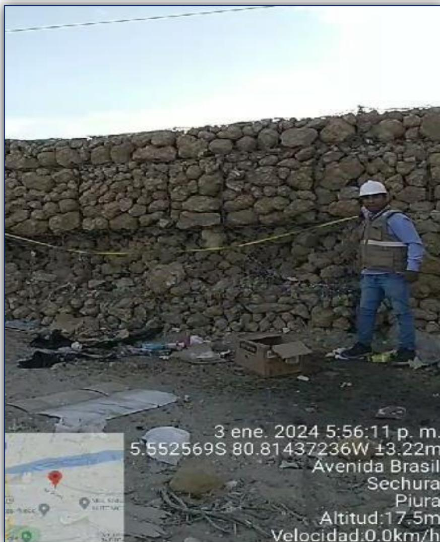
**Figura N° 05:** Se observo que en el encajonado del bloque base se encuentra rota la malla en el panel frontal, razón por la que el material de relleno se expone a desprenderse de su estructura.
