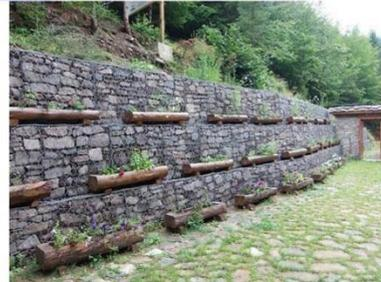
Figura 1. Estructura con gaviones. Fuente: <http://www.solucionesespeciales.net/MedioAmbiente/Gaviones/Gaviones.aspx>
