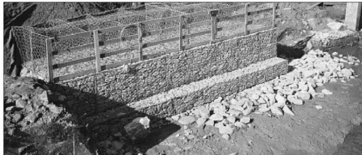
Figura 2.4.2 - Detalle constructivo de obra con gaviones caja
