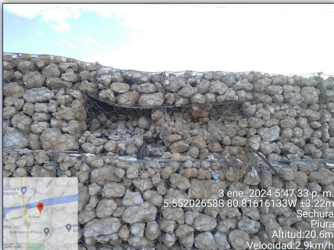
**Figura N° 08:** En la progresiva indicada, se observó que panel frontal del cubo se encuentra roto, afectando el muro y en consecuencia se está quedando sin material de relleno.
