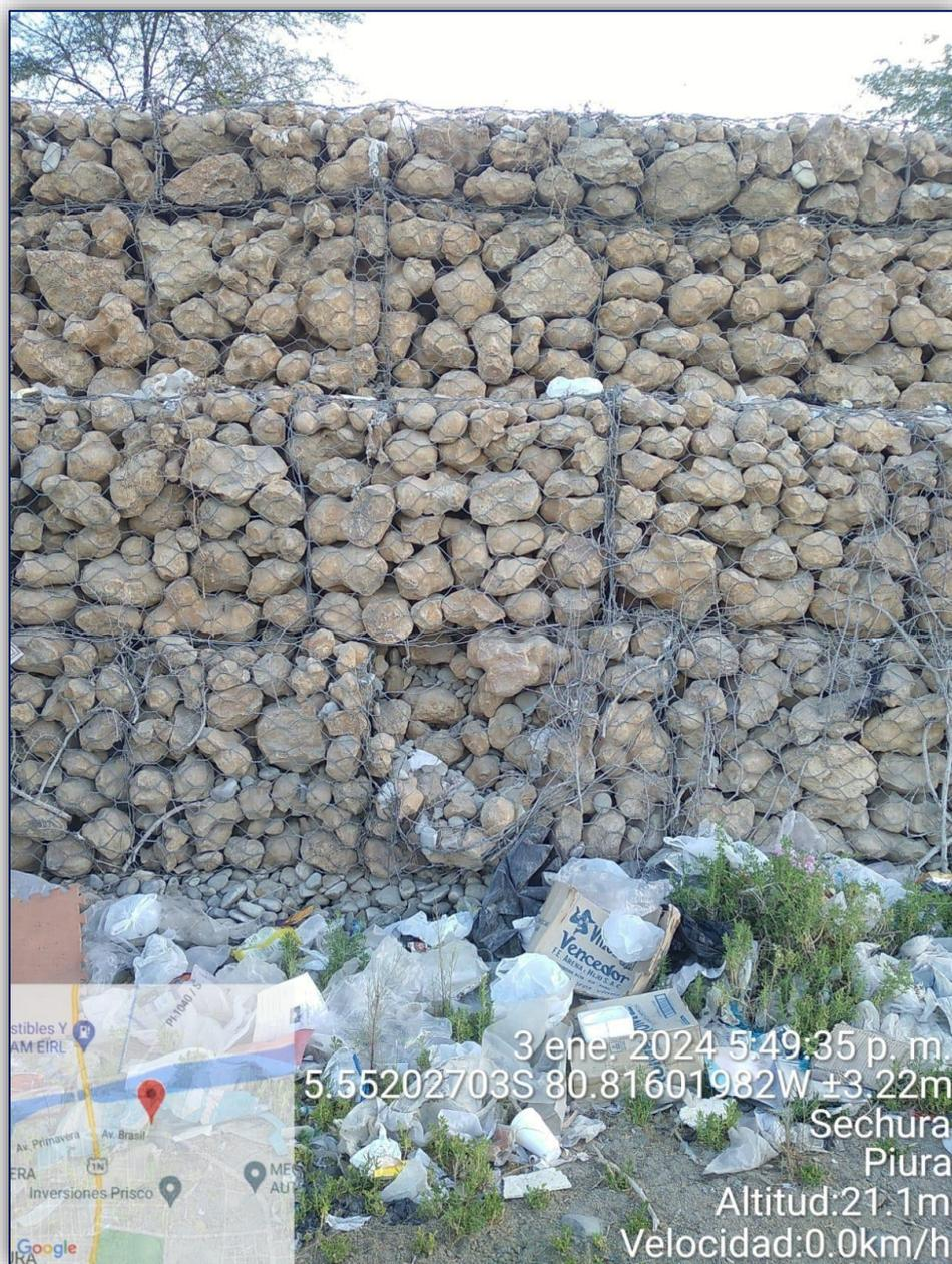
**Figura N° 06:** En el tercer bloque del muro se observó la malla rota, donde el material de relleno se ha desprendido de su estructura.
