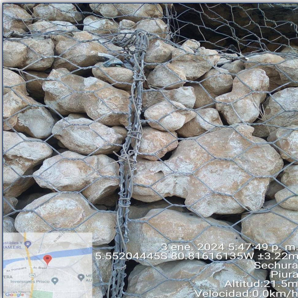
**Figura N° 09:** Dentro del tramo 0+210 a 0+232 encontramos distintos bloques que no cuentan con material de relleno.
