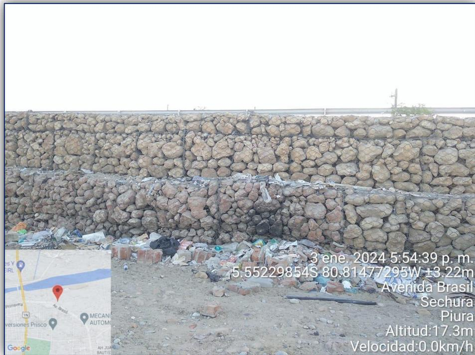
Figura N° 09: Se observa las medidas del material de relleno y es roca de cantera
