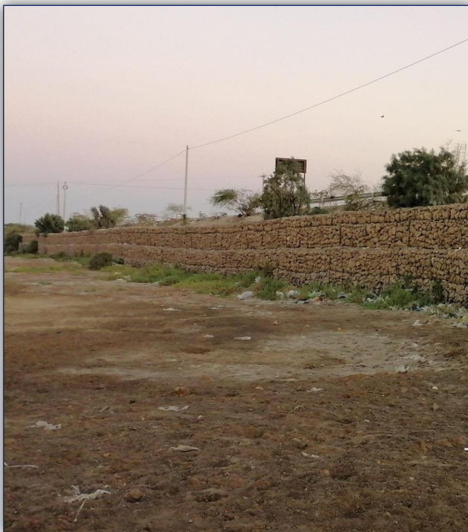
Se observa el muro de gaviones tipo caja, tiene una forma paralelepipedo, tiene malla metálica hexagonales, triple torsión, galvanizada recubierta con PVC. Con una abertura de 0.8 cm\* 0.10 cm, su material de relleno es de roca cantera, cuenta con diafragmas que unen al muro cada 1.00 \* 0.80 metros, esta esta escalonada a cada 1.80 metros y su ancho de su base es 1.40 metros, el bloque superior está dividido por diafragmas que están divididos uno en 0.80 metros y el otro a 0.50 metros.
