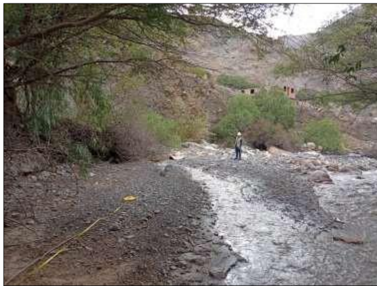
Fotografía 02: Tramo 1 en donde se observa las viviendas del caserío Sacaycacha en peligro de erosión por el Río Huandoval.
