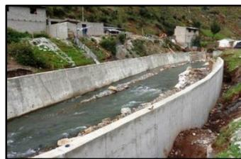
Figura 4. Sistema de defensa ribereña con muros de contención
