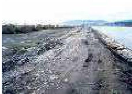
Figura 6.4. Talud peinado con maquinaria
