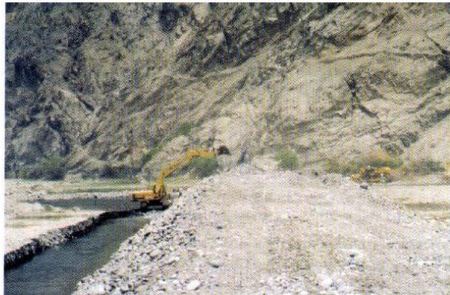
Foto N°4. Tractor iniciando armado de terraplén
