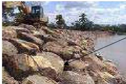
Enrocado con roca colocada
