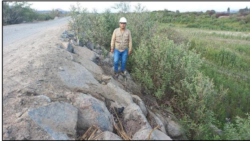
Figura 11. Vegetación en el medio de la cara húmeda del enrocado
