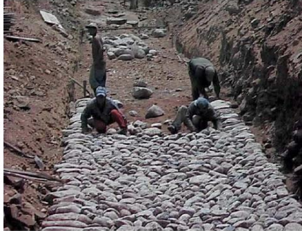
Figura 6.6. Forma de colocar las piedras para un enrocado colocado a mano
