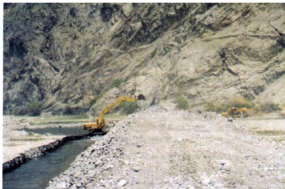
Foto N°4. Tractor iniciando armado de terraplén
