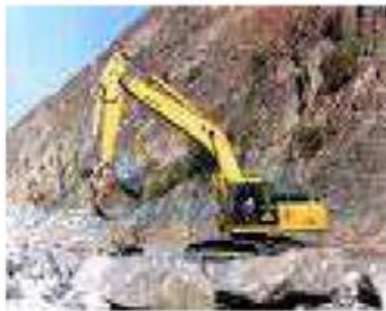
Figura 6.7. Volcado del enrocado con maquinaria
