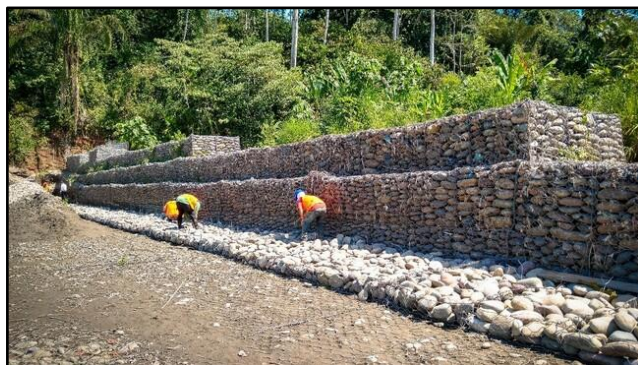
Figura 2. Gaviones para defensa ribereña
