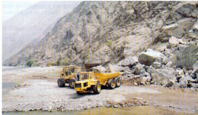
Foto N°6-Carguío de roca con equipo
