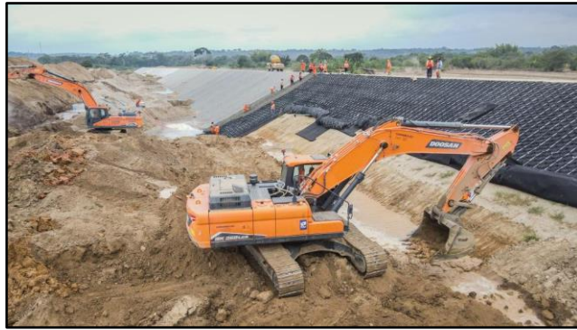
Figura 1. Geoceldas para defensa ribereña
