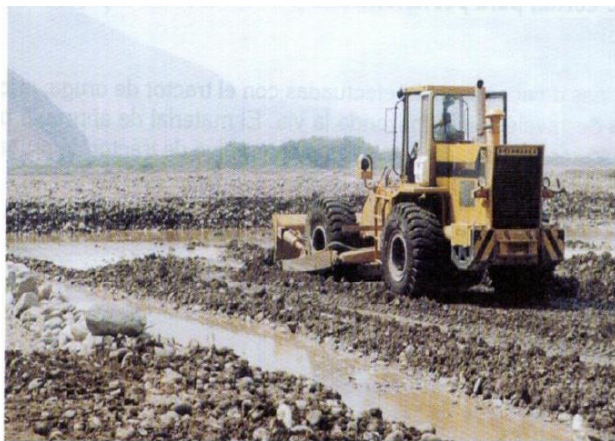
Foto N°3- Preparación de vía de acceso
