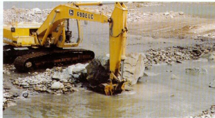
FOTO N°8. EXCAVADORA COLOCANDO ROCA EN LA UÑA NOTESE LA PROFUNDIDAD DE ESTAS
