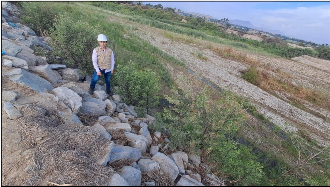
Figura 6. Sedimentación en enrocado
