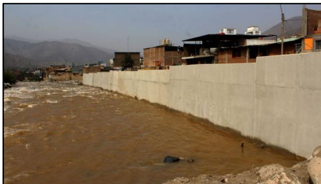
Figura 3. Muros de concreto armado en defensa ribereña
