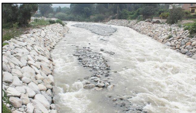
Figura 4. Enrocado para defensa ribereña
