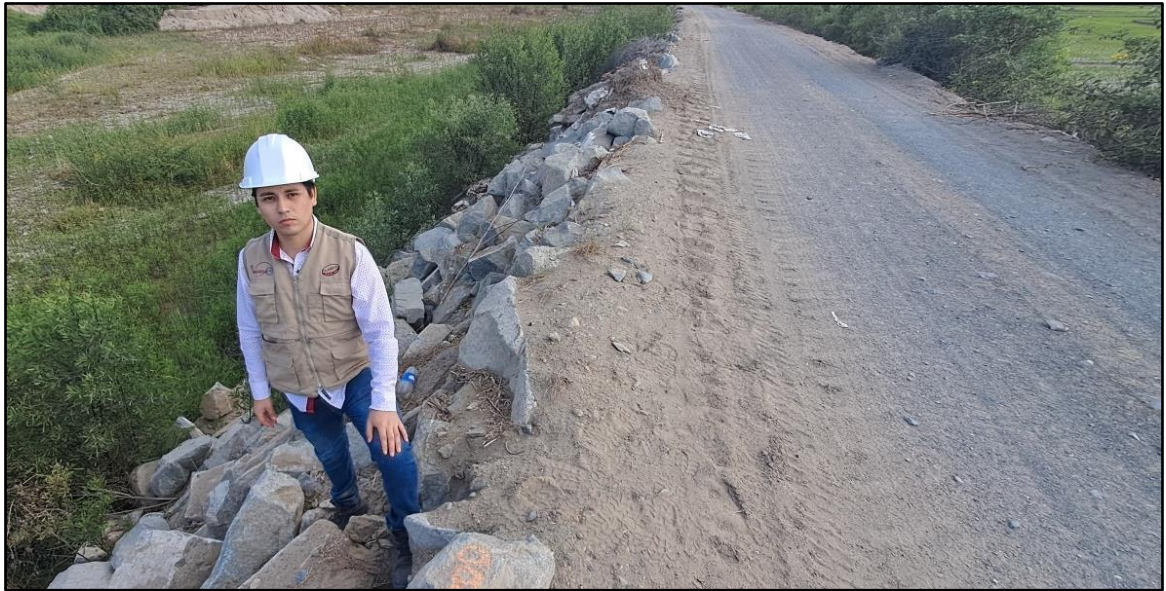
Figura 8. Verificación de consistencia de enrocado
