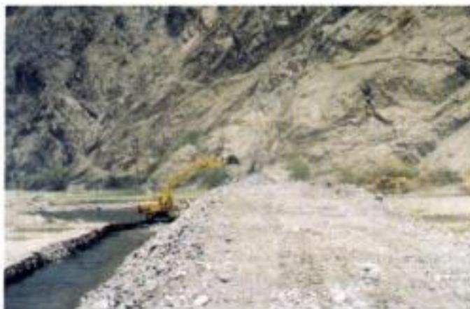
Foto N°4. Tractor iniciando armado de terraplén
