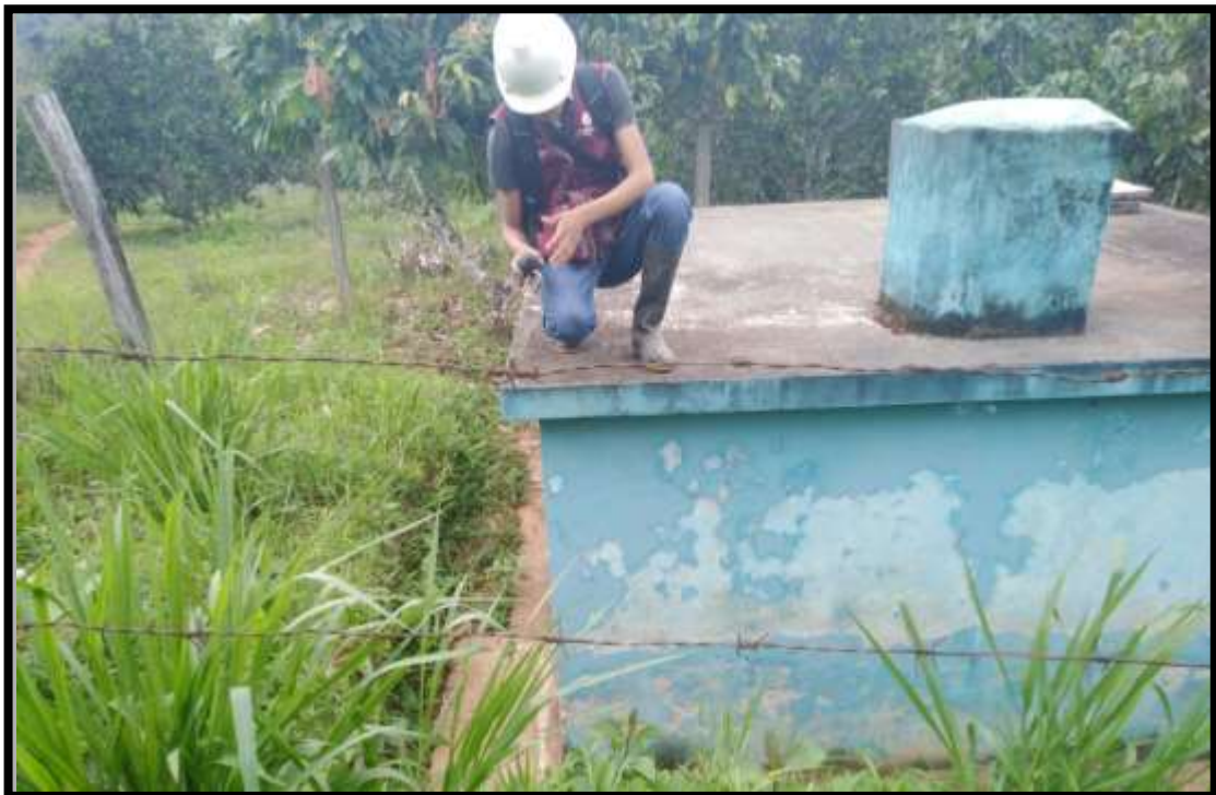
Figura 18: Reservorio ubicación y estado
