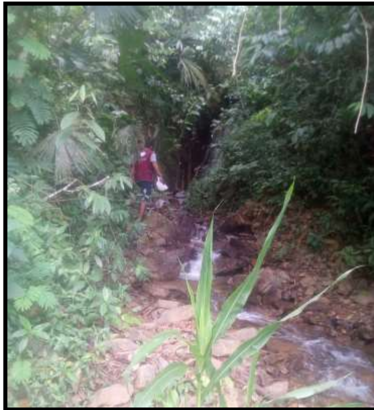
Figura 15: línea de conducción .
