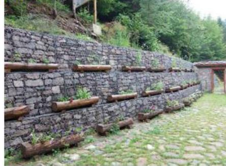
Figura 1. Estructura con gaviones. Fuente: <http://www.solucionesespeciales.net/MedioAmbiente/Gaviones/Gaviones.aspx>
