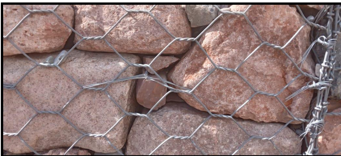
Figura 13: Se visualiza una roca con longitud inferior a los 10 cm. Fuente: Elaboración propia.
