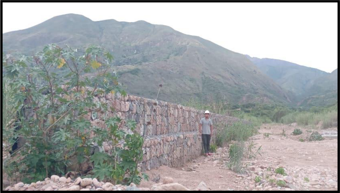
Figura 4: Vista panorámica del muro de gavión.
