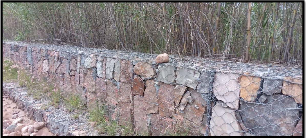
Figura 19: Se visualiza rocas con dimensiones desde 5cm hasta 60cm. Fuente: Elaboración propia.
