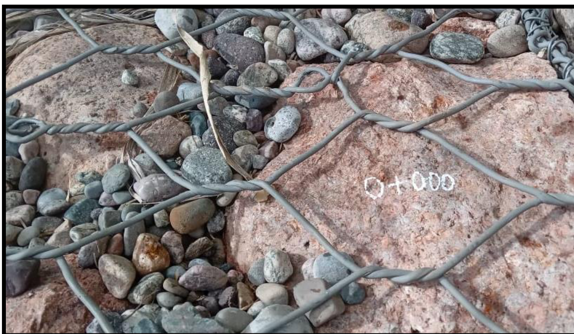
Figura 7: Inicio del muro de gavión.
