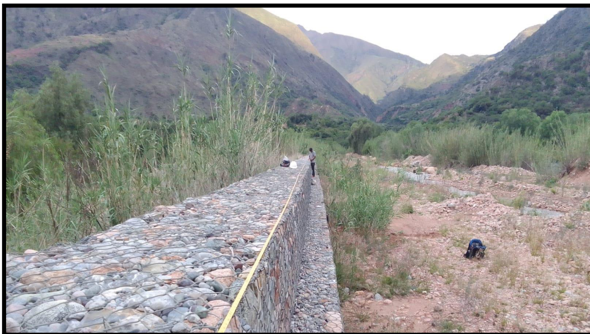
Figura 6: Se está realizando la medición del muro de gavión.
