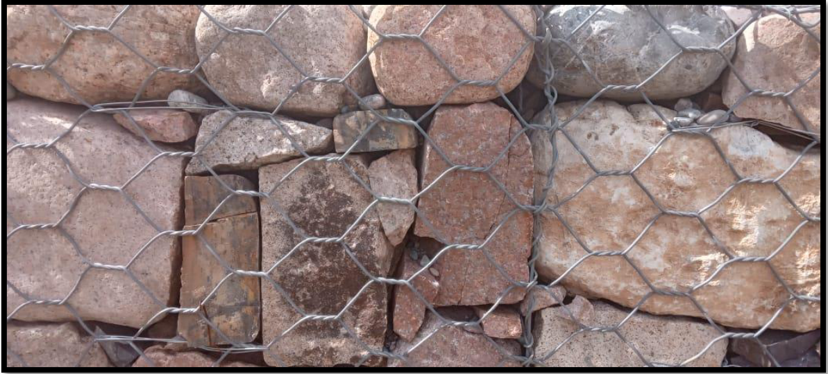
Figura 18: Se visualiza dos piedras fracturadas. Fuente: Elaboración propia.
