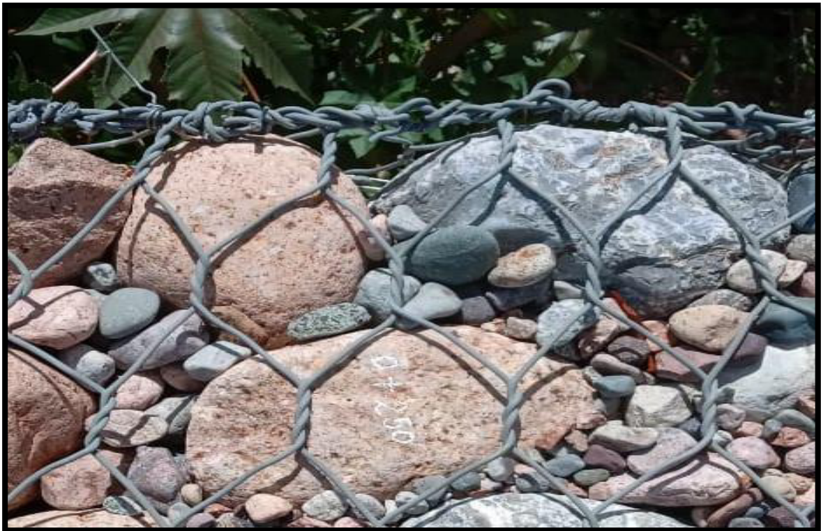
Figura 8: Final del muro de gavi3n, termina en la progresiva 0+250. Fuente: Elaboraci3n propia.
