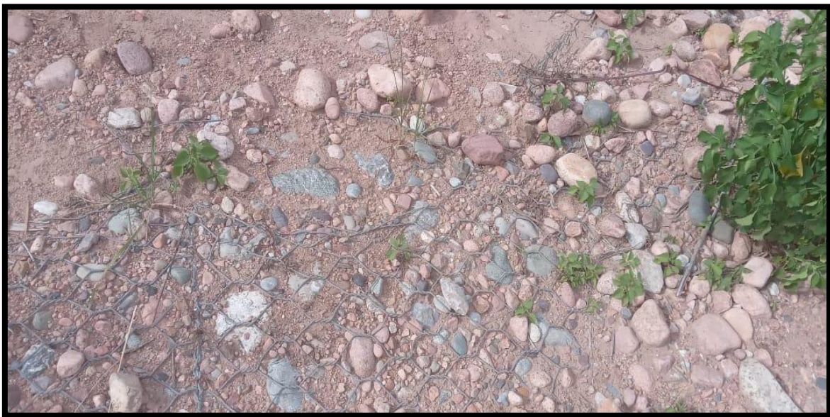
Figura 15: Rotura de malla en el colchón Reno.
