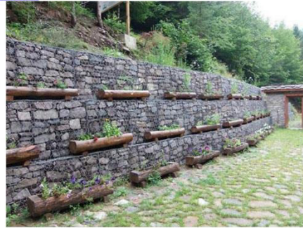
Figura 1. Estructura con gaviones. Fuente: http://www.solucionesespeciales.net/MedioAmbiente/Gaviones/Gaviones.aspx
