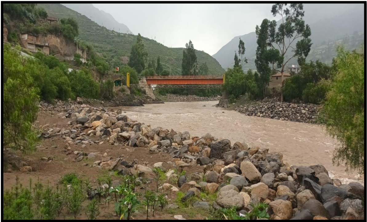
Figura 22: Vista panorámica del puente Vilcanchos, el enrocado sirve de protección para el muro del puente
