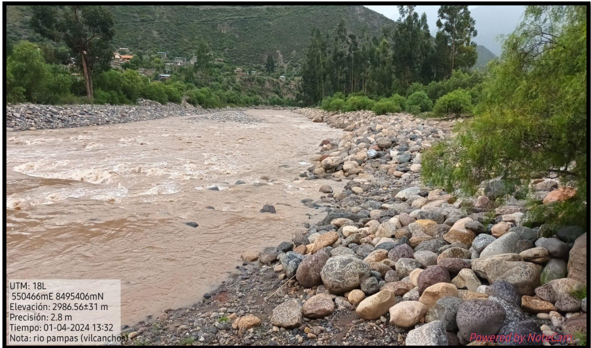
Figura 18: Inicio del enrocado, se observa derrumbe del enrocado
