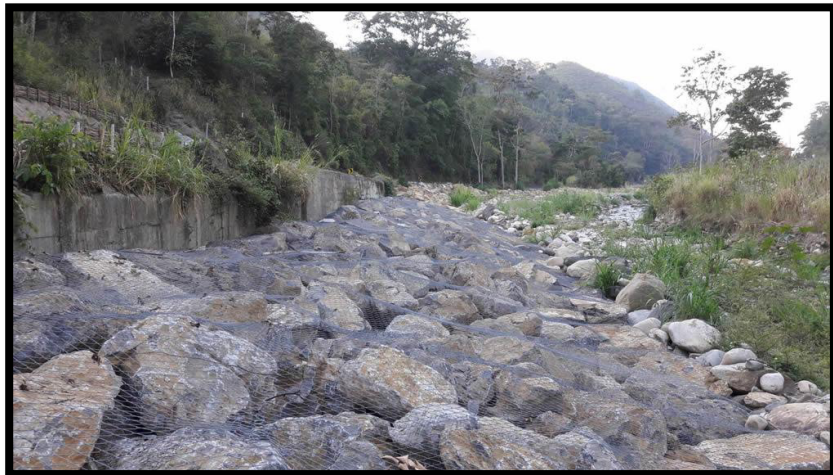
Figura 2: Inspección visual del enrocado
