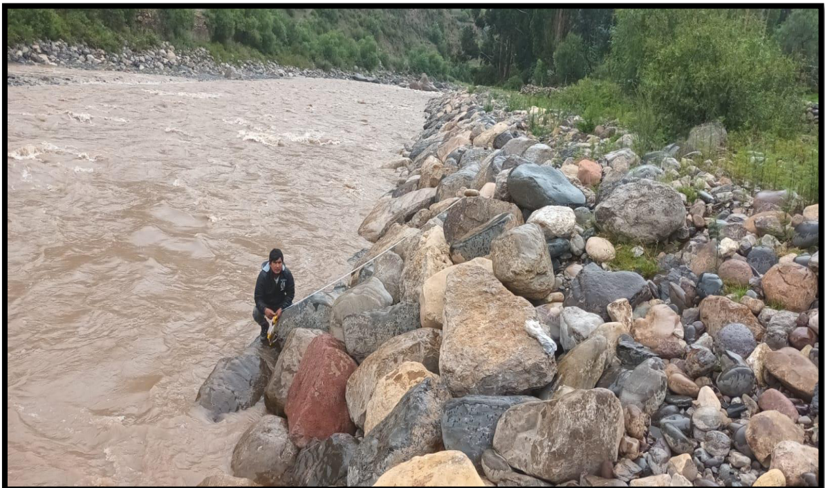
Figura 18: Inicio del enrocado, se observa derrumbe del enrocado
