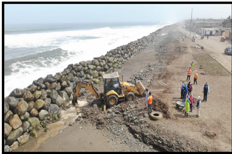
Figura 8: Mejoramiento de la defensa tipo enrocado
