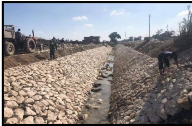
Figura 7: Mejoramiento del enrocado
