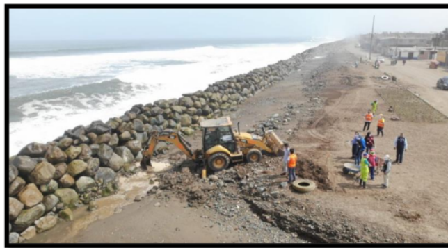
Figura 8: Mejoramiento de la defensa tipo enrocado
