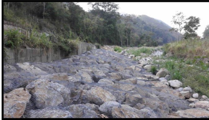
Figura 2: Inspección visual del enrocado
