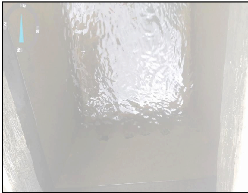
Figura 14: Interior de la cámara húmeda
