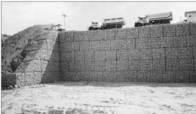
Figura 2.3.4 - Brasil - Contención para acceso a chancadora
