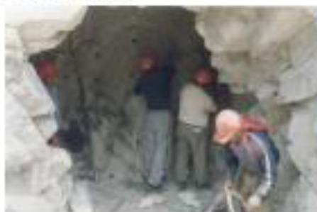
Fig. N° 05: Extracción de roca con explosivos
