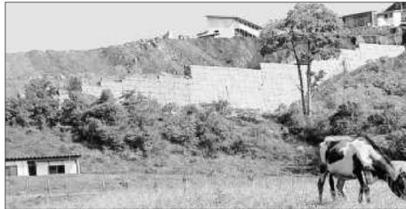
Figura 2.3.5 - Brasil - Contención ejecutada en 1986
