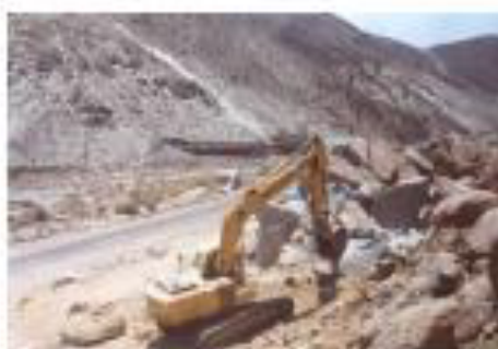
Fig. N° 04: Extracción de roca sin explosivo
