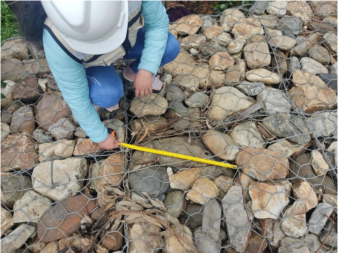
Ilustración 7: medición de las octogonales de la malla
