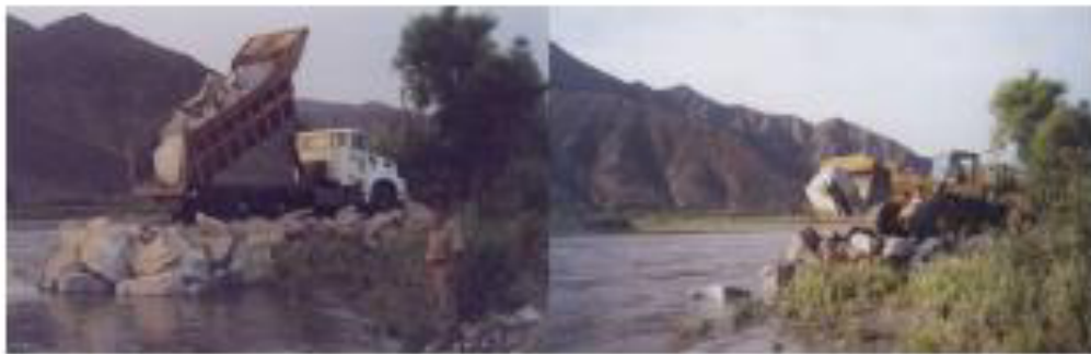
Fig. N° 03: Conformación de defensa ribereña
