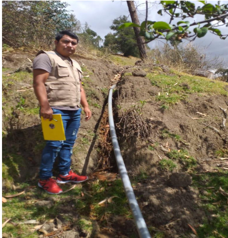
Figura 17: línea de aducción Fuente: elaboración propia
