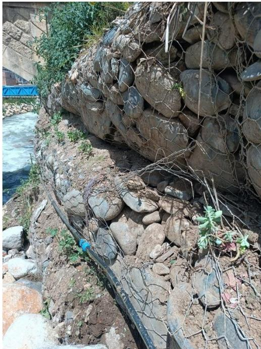
**Foto N° 05:** Progresiva 0+080 se observa el empuje y deflexión del muro; se visualiza que la malla se encuentra rota en el segundo nivel.
