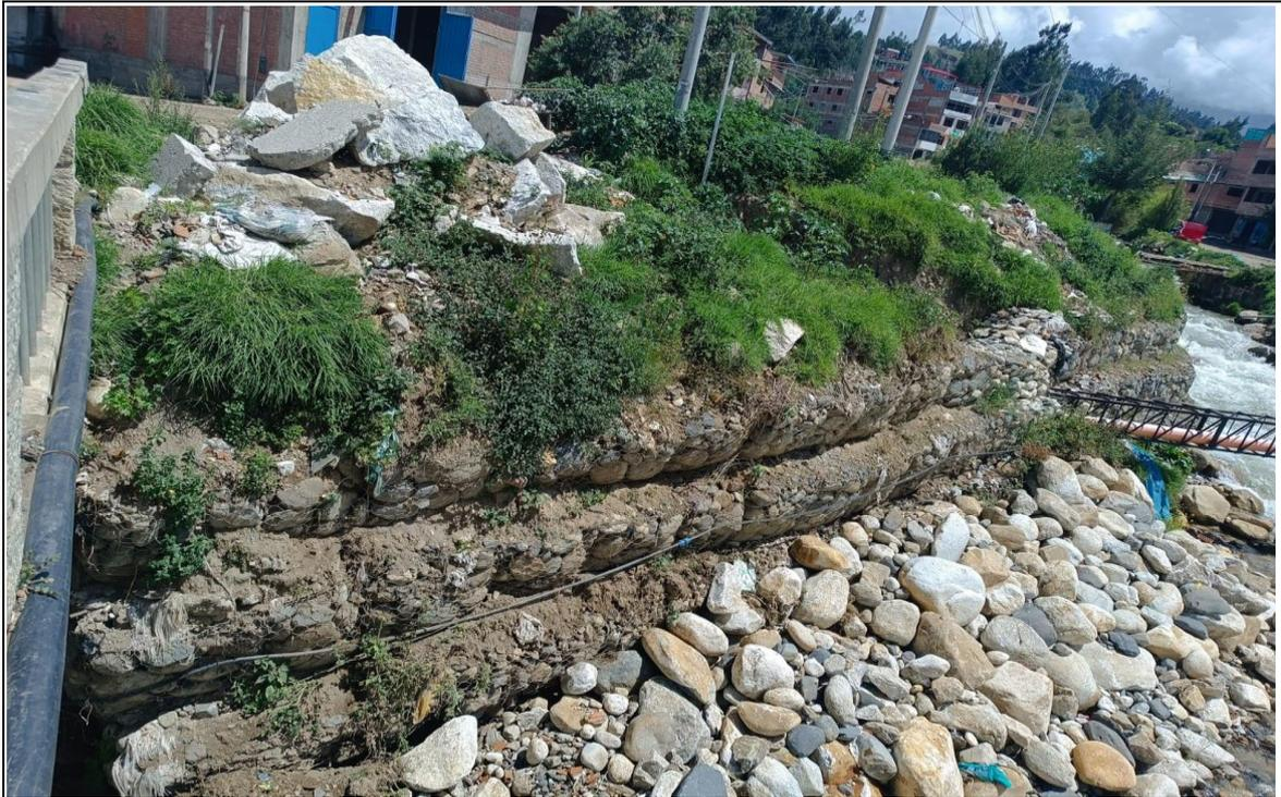
**Foto N° 01:** Progresiva 0+60 al 0+0+090 se observa rocas en el primer nivel por la descolmatación del río; en el tercer nivel se ve rocas, tierra y vegetación.
