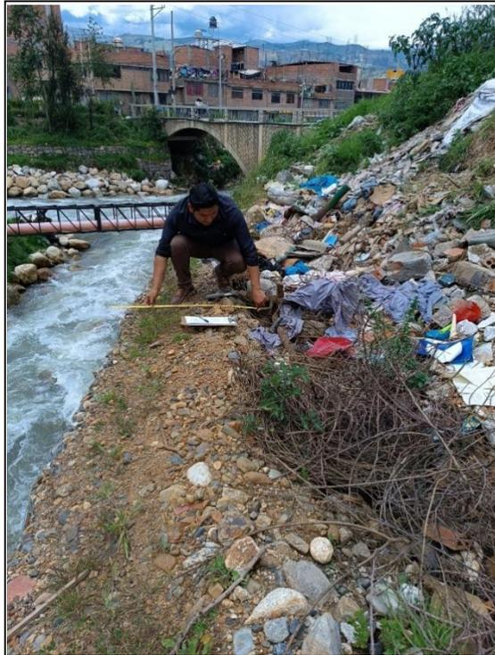
**Foto N° 17:** Dimensiones de 1 m ancho x 1 m de altura, parte superior desechos humanos en la progresiva 0+040.
