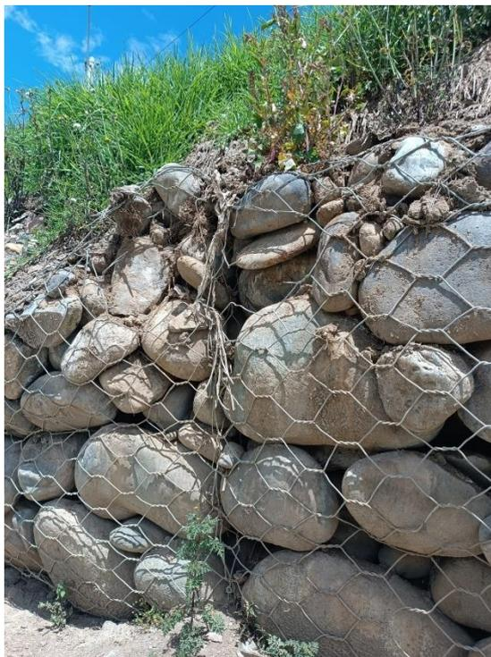
**Foto N° 04:** Progresiva 0+080 se observa vacíos en el relleno.
