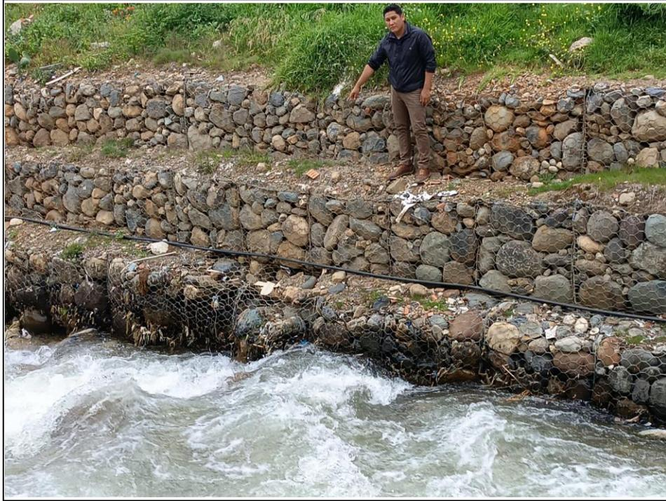
**Foto N° 21:** Socavación en la base en las progresiva 0+020 al 0+000.
