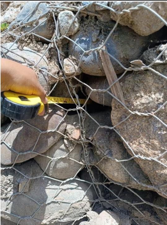
**Foto N° 08:** Progresiva 0+085 relleno con vacíos.
