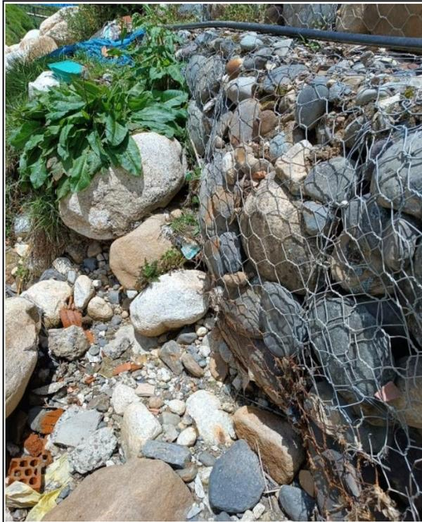
**Foto N° 13:** Progresiva 0+060 se observa en el segundo y tercer nivel desmorte y tercer nivel desmorte y vegetación creciente.
