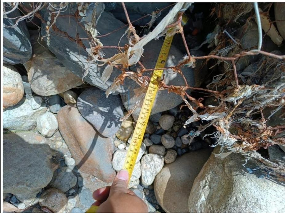
**Foto N° 11:** Progresiva 0+075 se observa socavación de la base a una profundidad hacia el muro de 20 cm, asimismo la oxidación de la malla.
