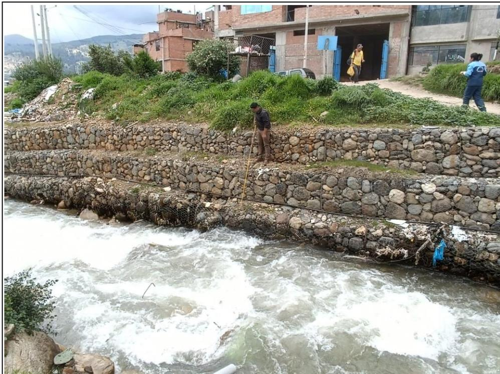
**Foto N° 22:** Socavación en la base en las progresiva 0+050 al 0+000, desprendimiento de relleno.
