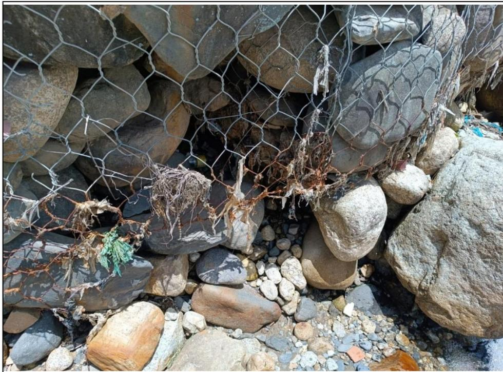
**Foto N° 10:** Progresiva 0+075 se observa socavación de la base del muro de gavión.
