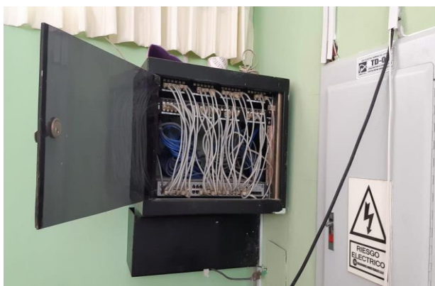
Figura 17 Conexiones de red actuales
