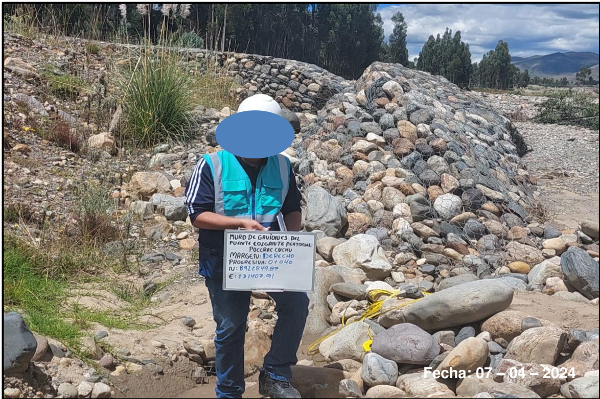
Foto 3: Se visualiza el punto 0+040 del muro de gaviones
