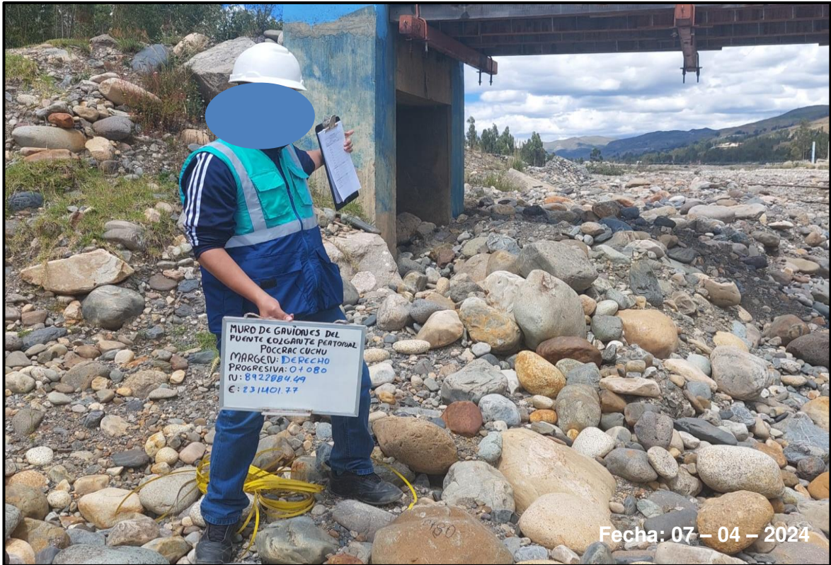
Foto 7: Se aprecia el punto 0+080 del muro de gaviones, vista hacia el puente colgante peatonal
