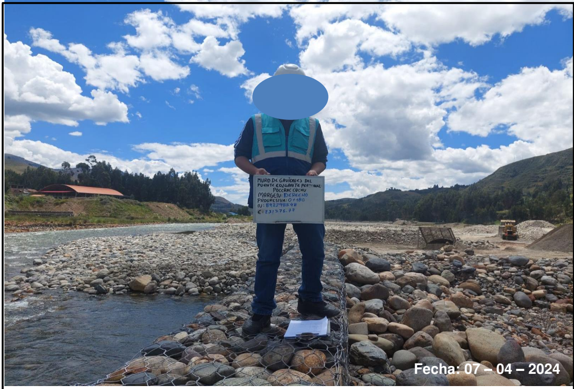
Foto 18: Se muestra el punto 0+180 del muro de gaviones
