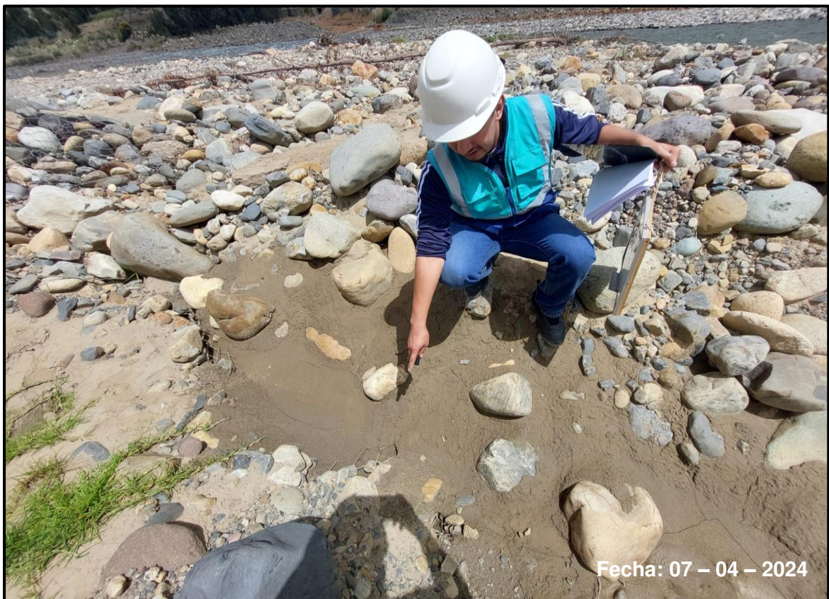
Foto 6: Progresiva 0+040 a la 0+080, se notan solo partes superficiales de la malla y el relleno
