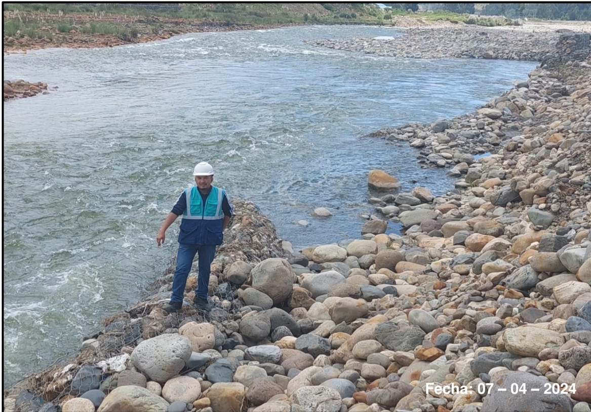
Foto 13: Se muestra el muro de gaviones sumergido en el río Santa
