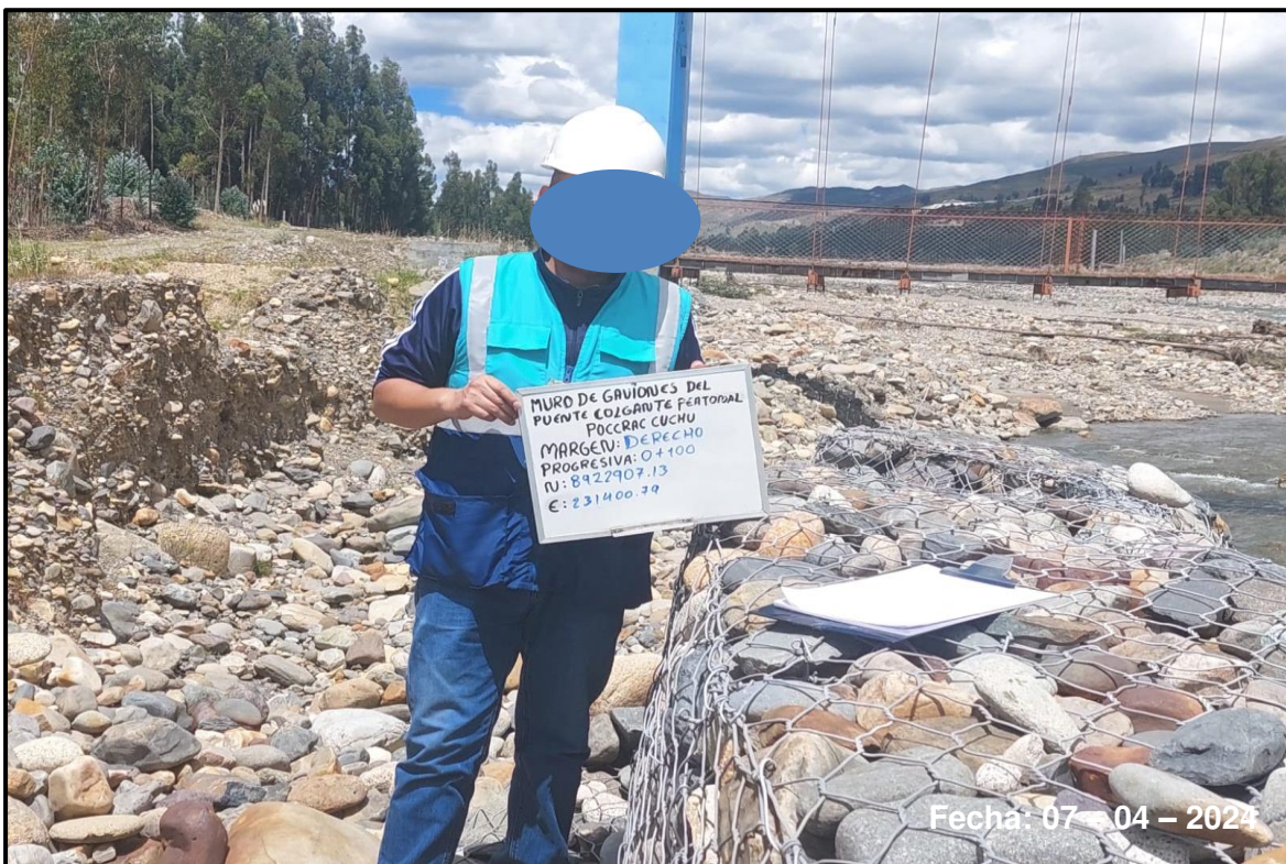
Foto 10: Se visualiza el punto 0+100 del muro de gaviones
