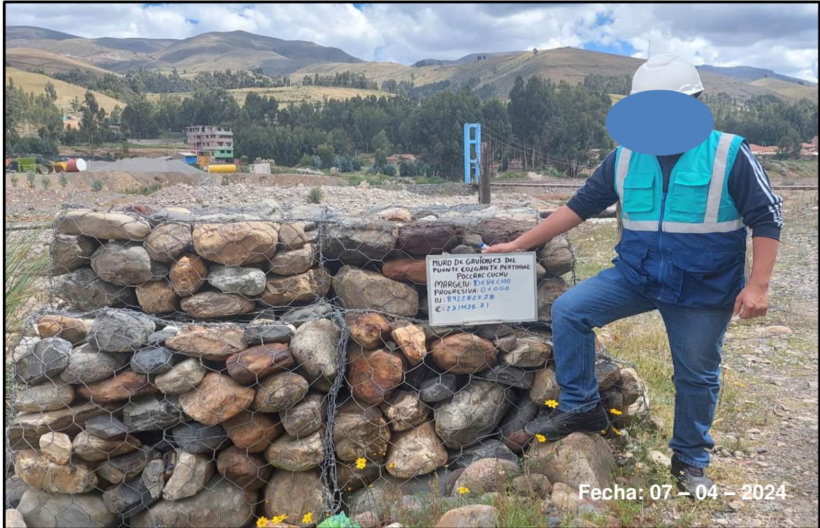
Foto 1: Se muestra el punto de inicio 0+000 del muro de gaviones
