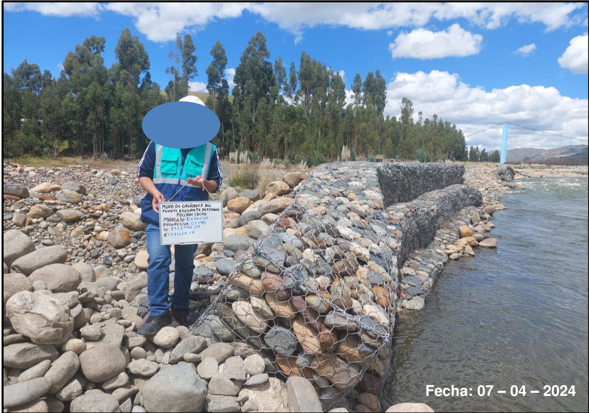
Foto 19: Se observa el punto 0+195 del muro de gaviones
