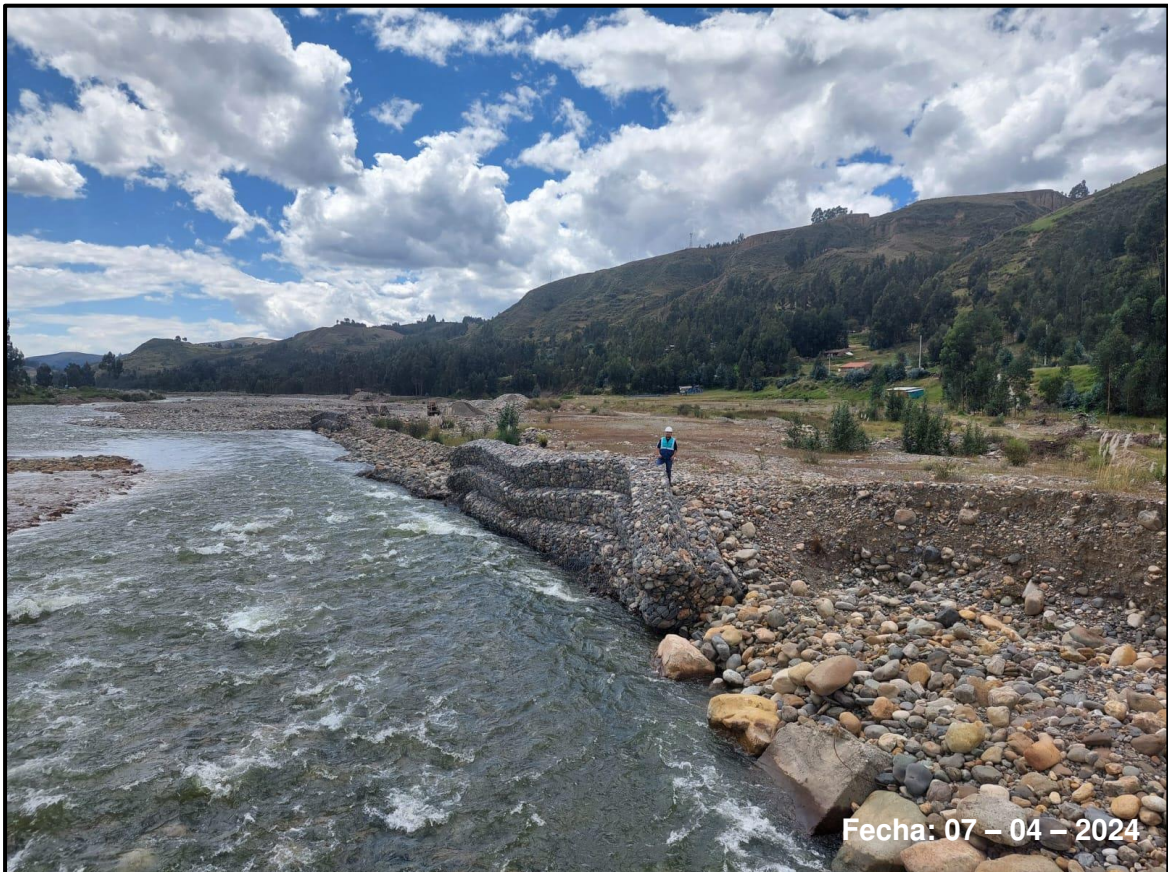
Foto 20: Se presenta la vista general del muro de gaviones
