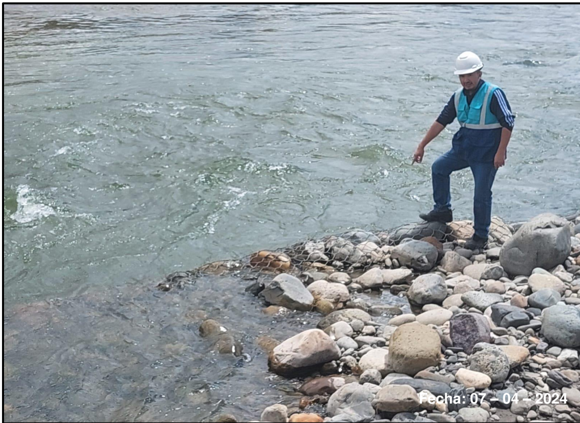
Foto 14: Se muestra una parte parcial del muro de gaviones
