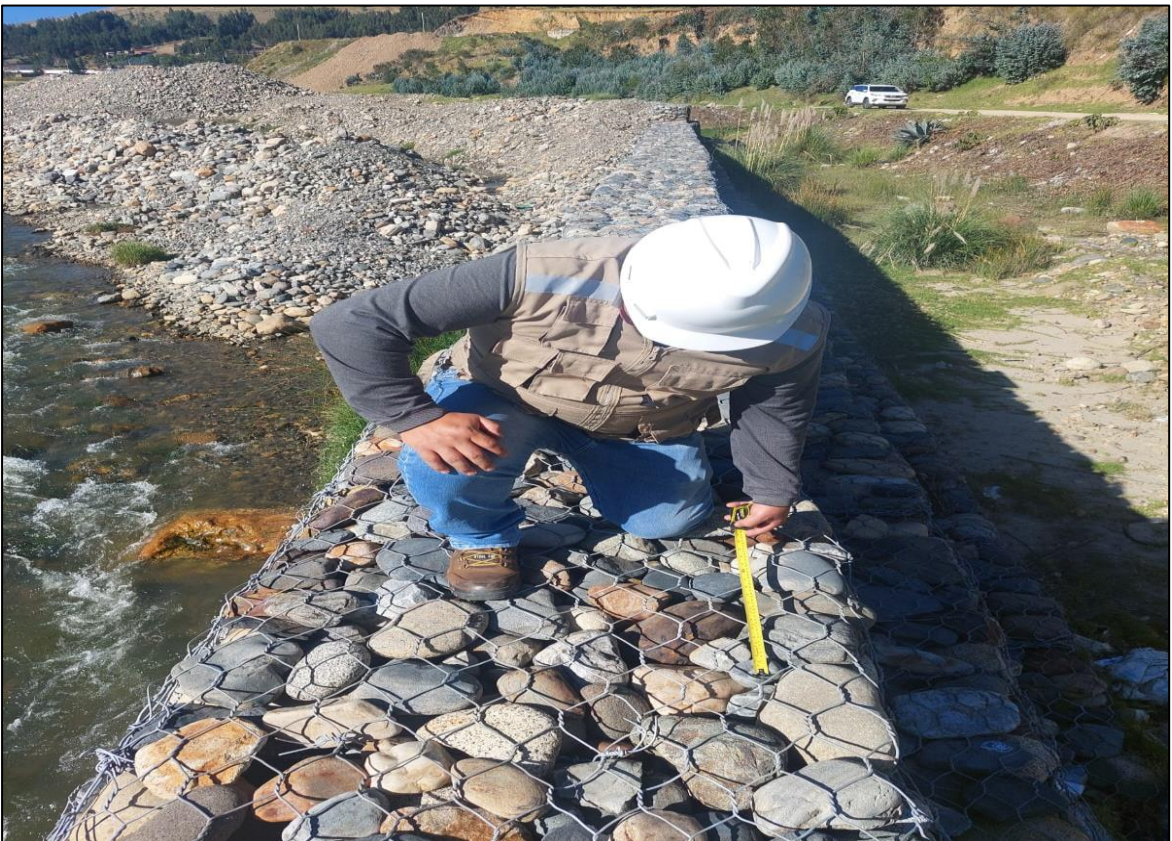
Descripción: Medición de la malla, entre las progresivas 0+060 y 0+080.
