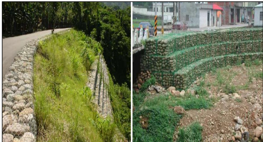
Figura 4: Muros de gaviones
