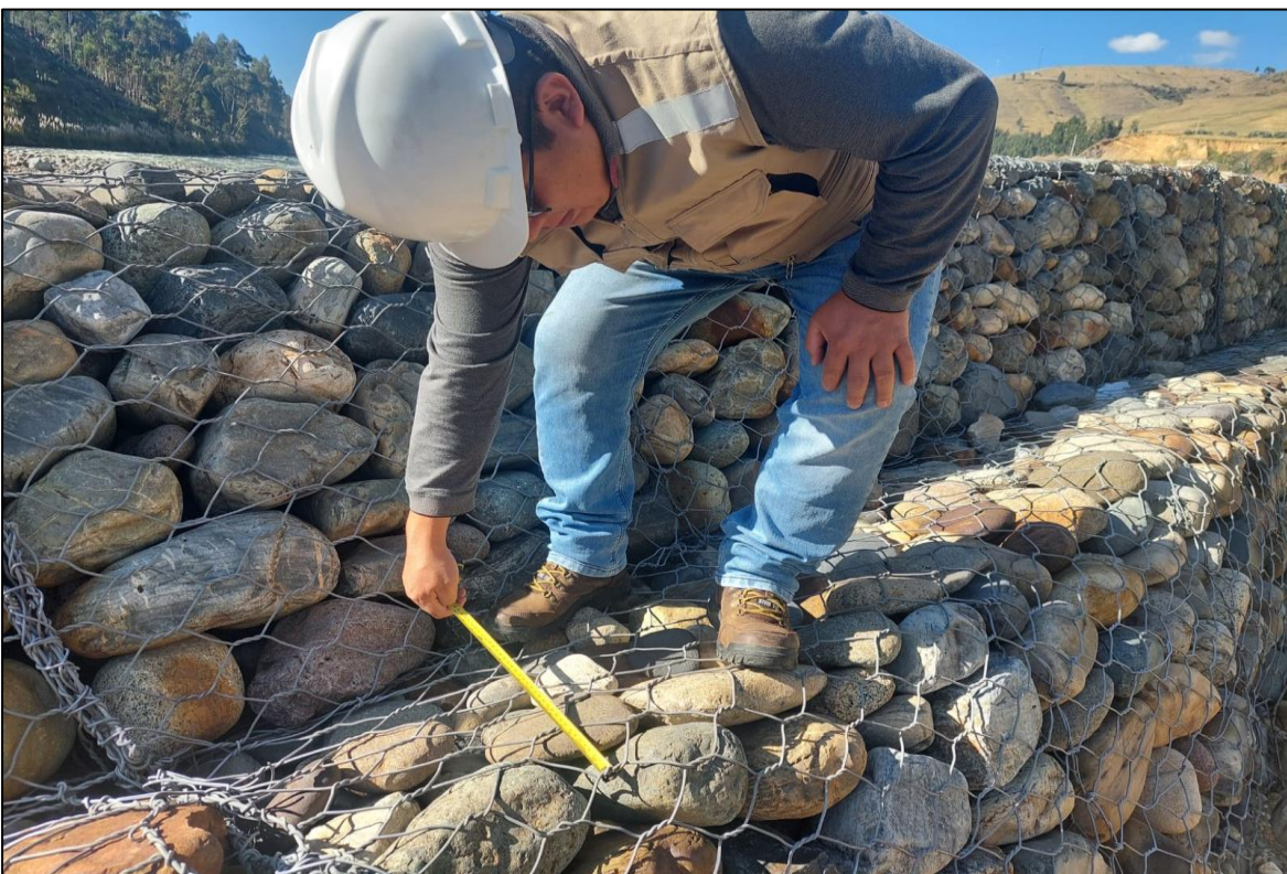
Descripción: Medición de abertura de la malla, entre las progresivas 0+040 y 0+060.
