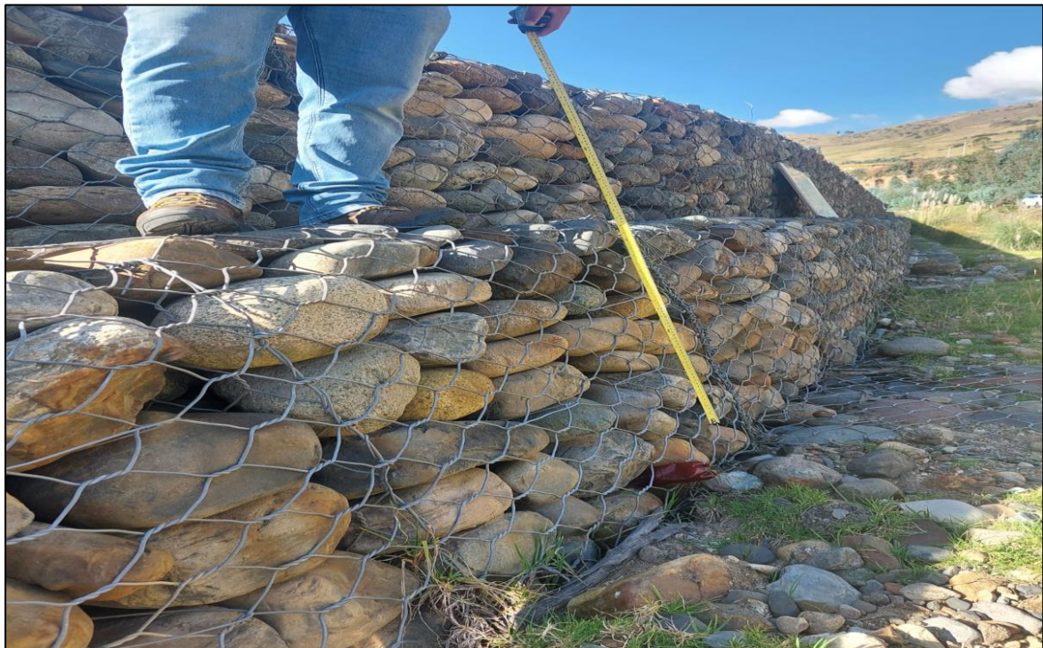
Descripción: Presencia de residuos sólidos entre las progresivas 0+060 y 0+080, vista 1.
