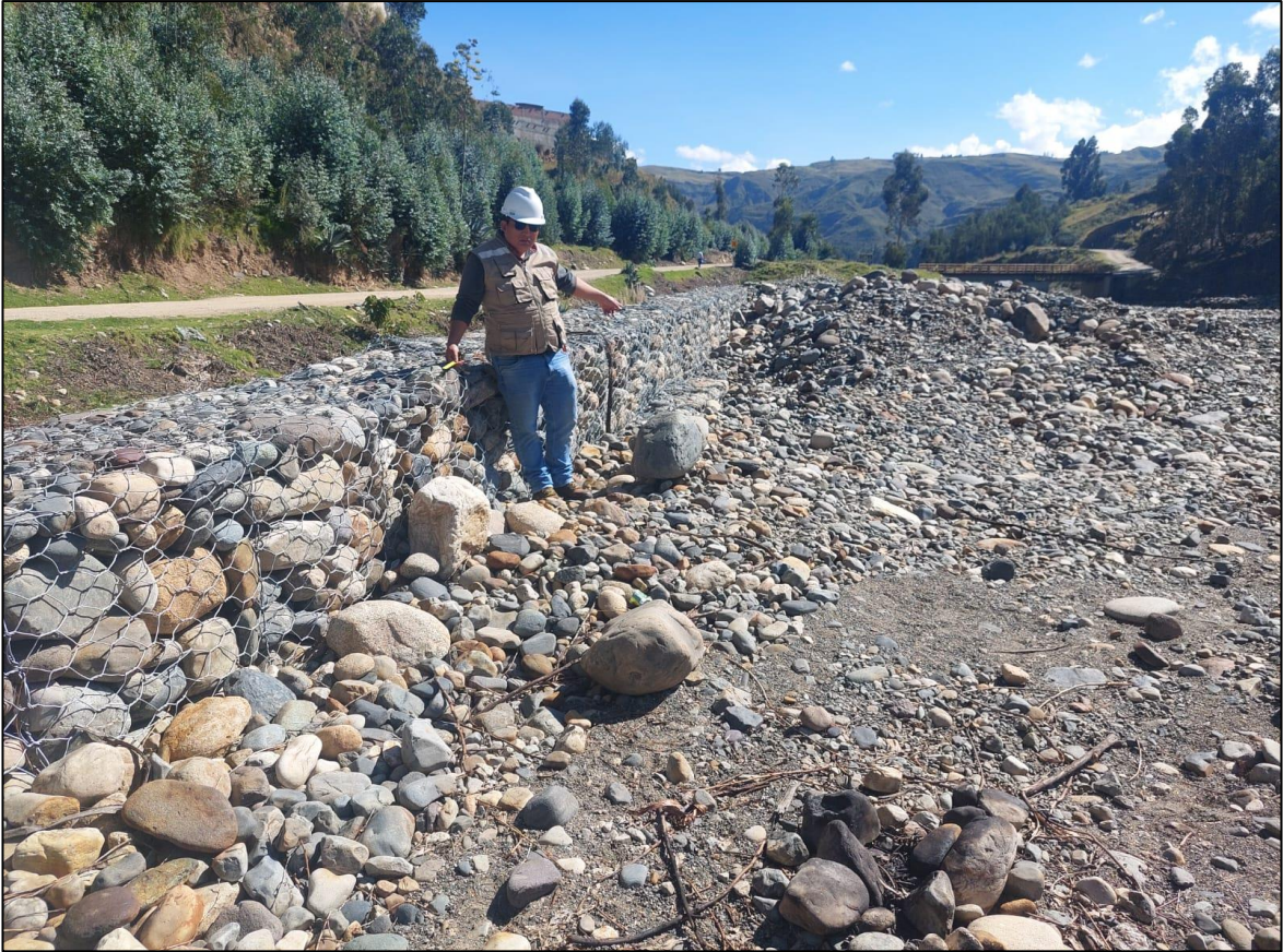
Descripción: Acumulación de sedimentos resultado de la descolmatación del río, entre las progresivas 0+120 y 0+140.
