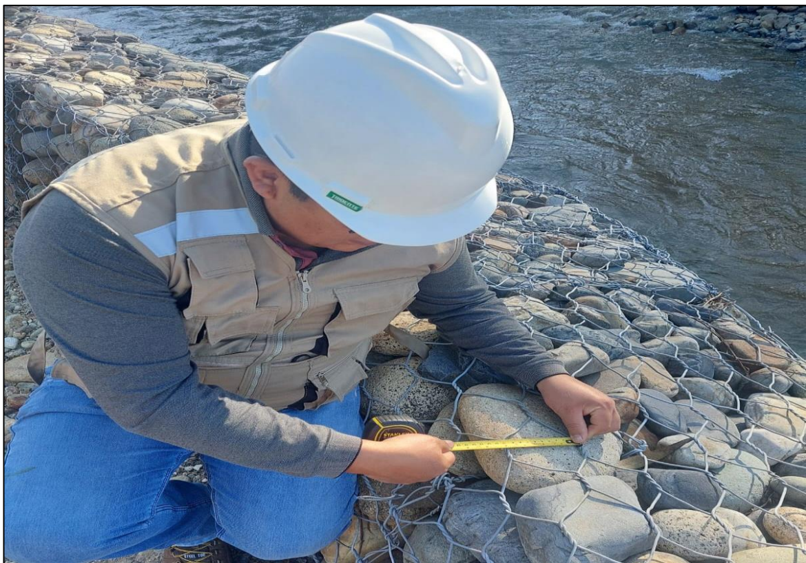
Descripción: Medición del material de relleno, entre las progresivas 0+020 y 0+040.
