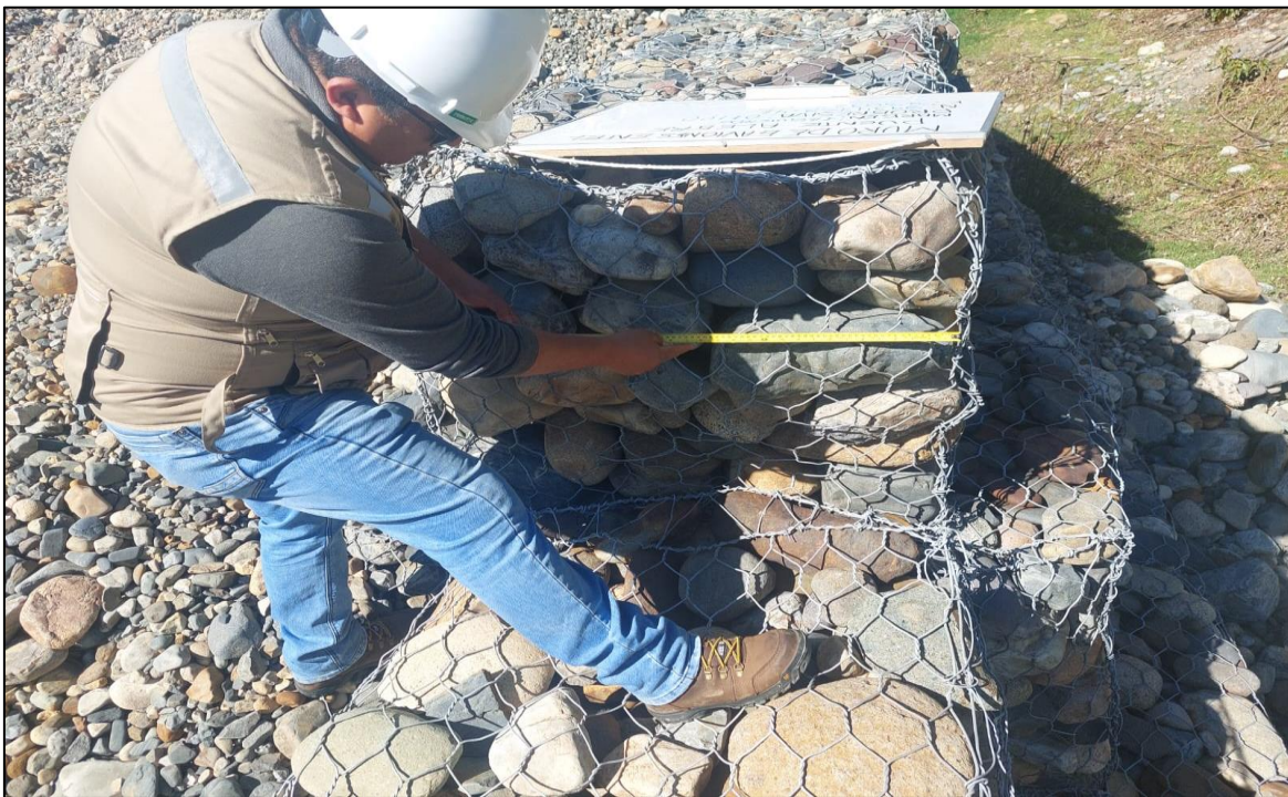
Descripción: Medición del gavión tipo caja entre las progresivas 0+100 y 0+120.
