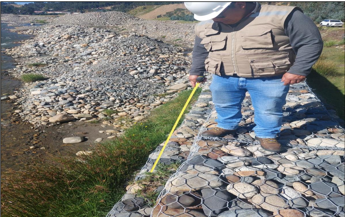
Descripción: Vegetación en el tercer nivel del muro de gaviones, entre las progresivas 0+060 y 0+080.
