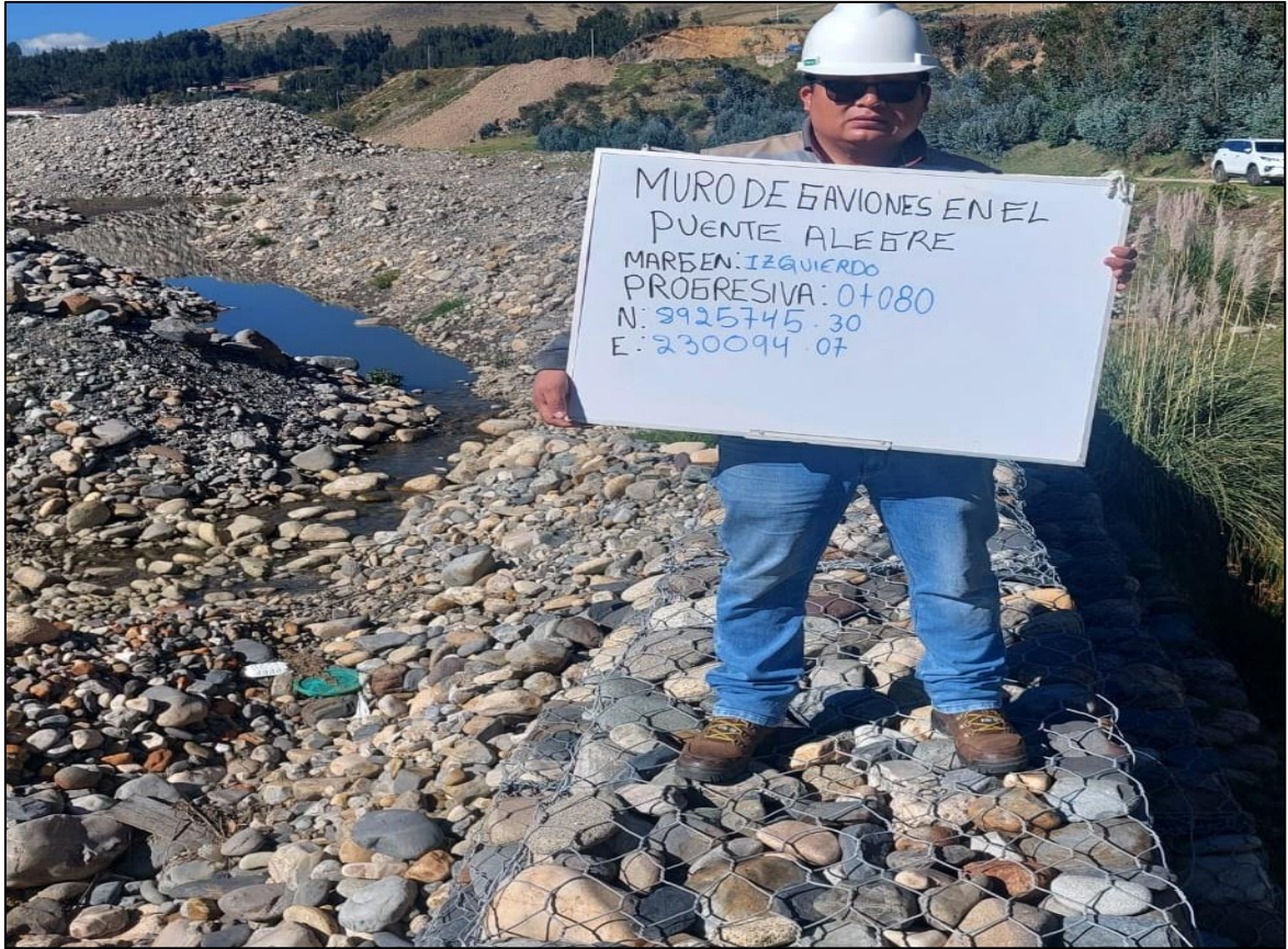
Descripción: Progresiva 0+080 del muro de gaviones del río Santa en el puente Alegre.
