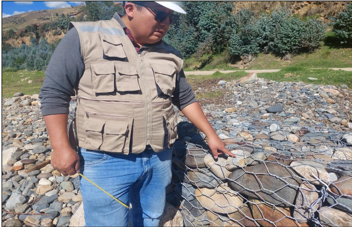
Descripción: Medición y roturas del material de relleno, entre las progresivas 0+120 y 0+140.
