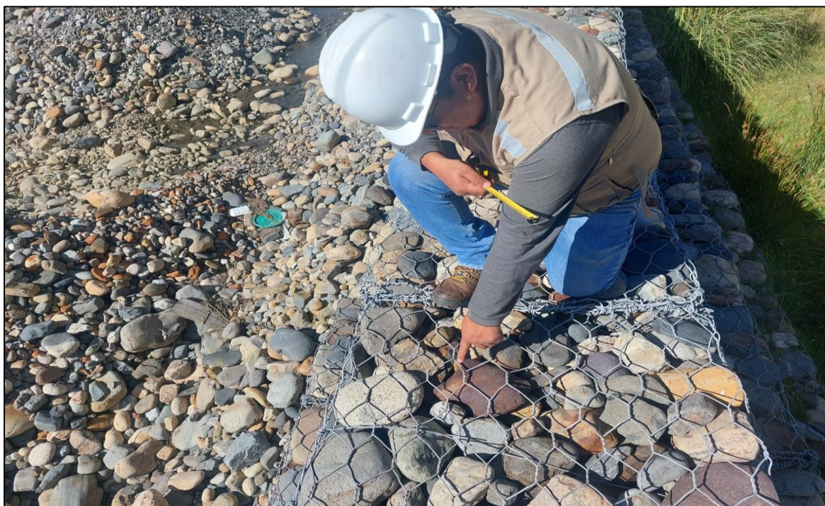
Descripción: Medición y roturas del material de relleno, entre las progresivas 0+080 y 0+100.
