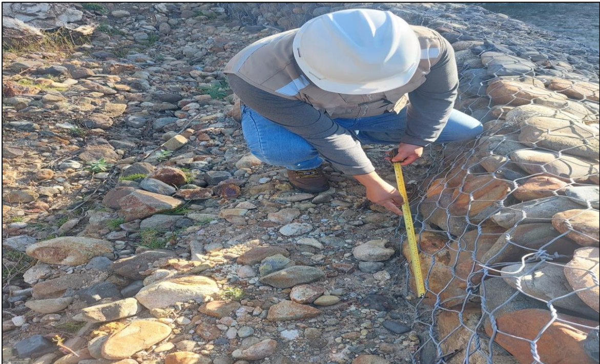
Descripción: Medición del material de relleno, entre las progresivas 0+000 y 0+020.
