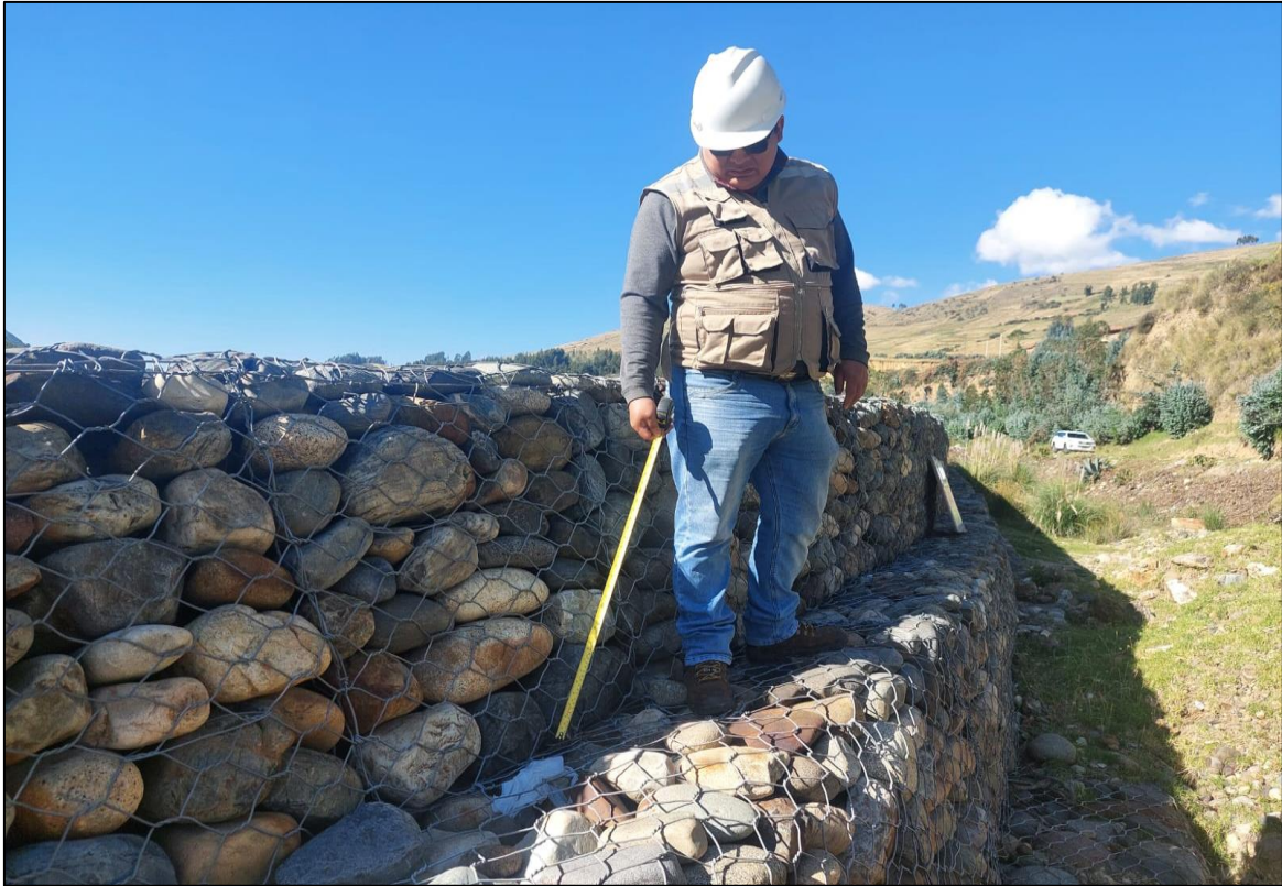
Descripción: Presencia de residuos sólidos entre las progresivas 0+040 y 0+060.
