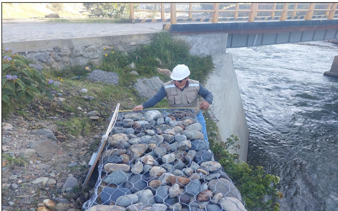
Descripción: Medición del gavión tipo caja.
