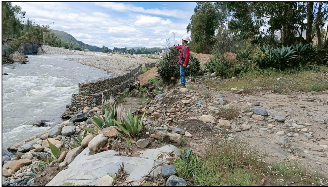
Fotografía N° 08: Se aprecia la vista panorámica del muro de gaviones de la margen izquierda.
