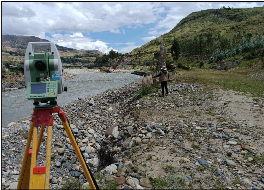
Fotografía N° 16: Realizando levantamiento topográfico del muro de gaviones tanto de la margen izquierda y derecha del río Santa.
