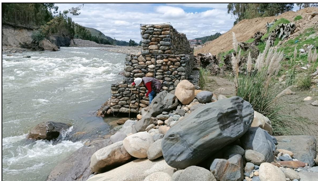
Fotografía N° 11: Tomando medidas de socavación en el muro de gaviones de la margen izquierda.
