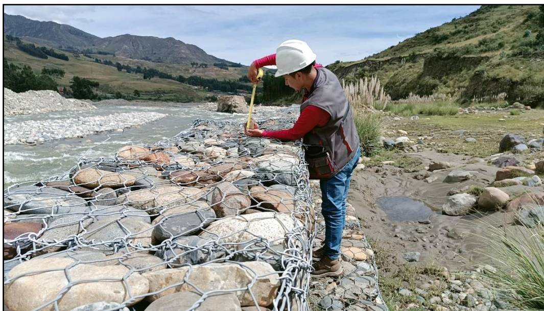
Fotografía N° 05: Tomando medidas de relleno de piedras de canto rodado que sobresalen del muro de gaviones en la margen derecha.
