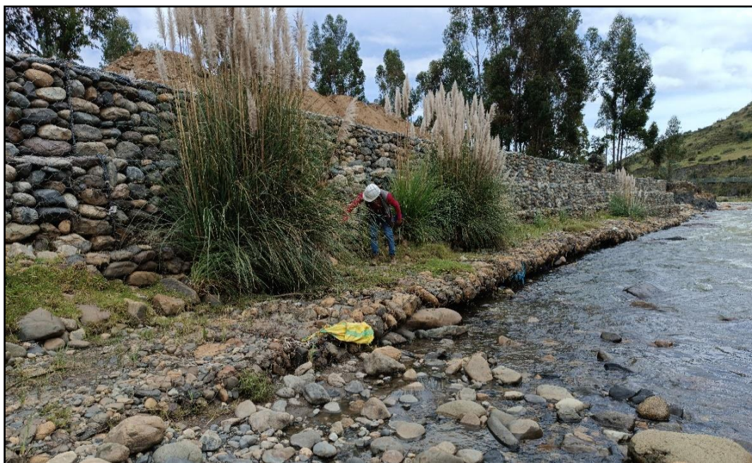
Fotografía N° 14: Tomando medidas en el muro de gaviones de tipo colchón de la margen izquierda.
