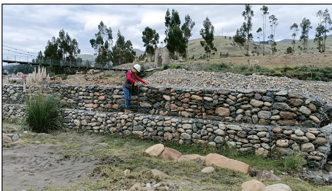
Fotografía N° 04: Tomando medidas de anchura del muro de gaviones en la margen derecha (3 niveles).
