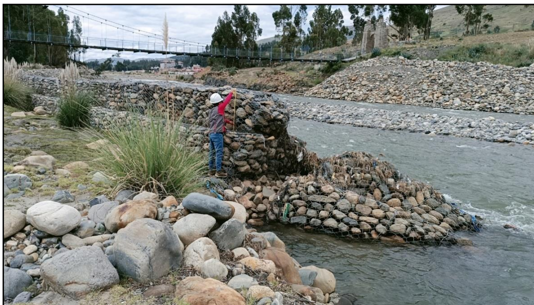
Fotografía N° 03: Tomando medidas de altura del muro de gaviones en la margen derecha (3 niveles).
