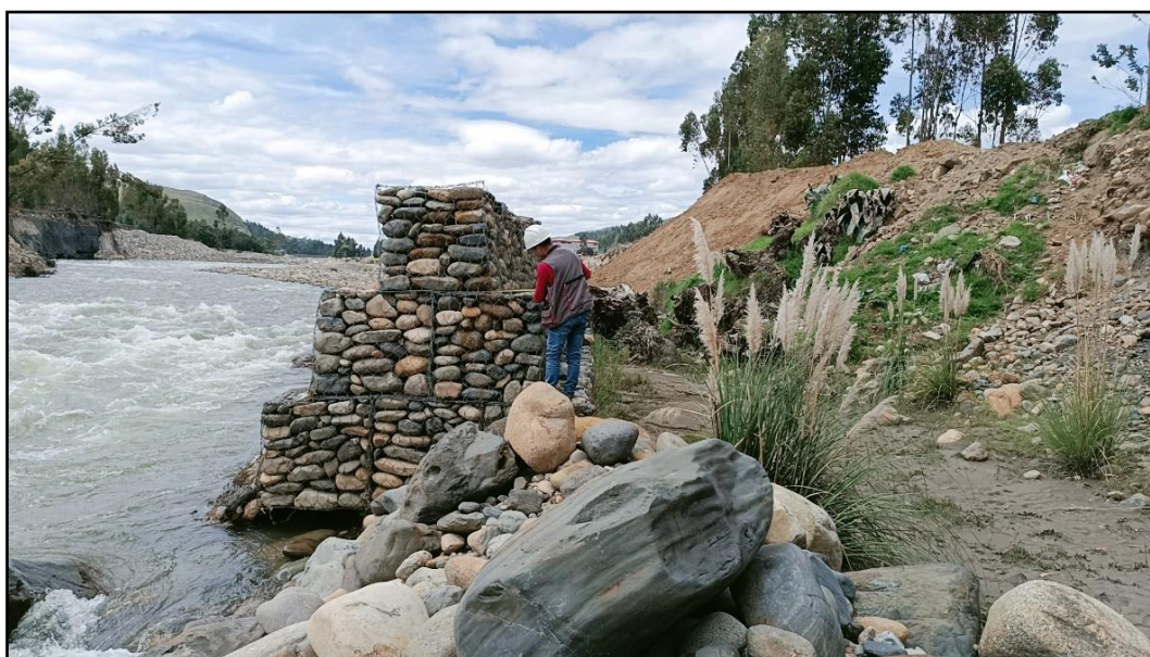
Fotografía N° 12: Tomando medidas de altura y anchura en el muro de gaviones de la margen izquierda (3 niveles).
