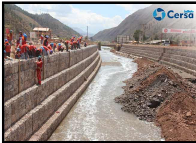
Figura 1 Evaluación del muro de gavión
