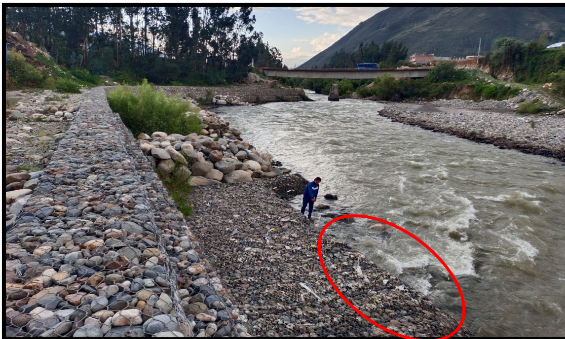
Figura 11 Colchón reno – antisocavante, viene siendo afectado por la infiltración de la acumulación de aguas que son vertidas de la PTAR
