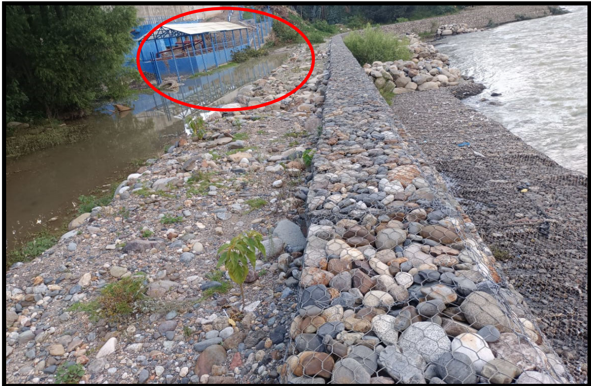
Figura 9 Acumulación de agua procedente de la Tratamiento de agua residuales
