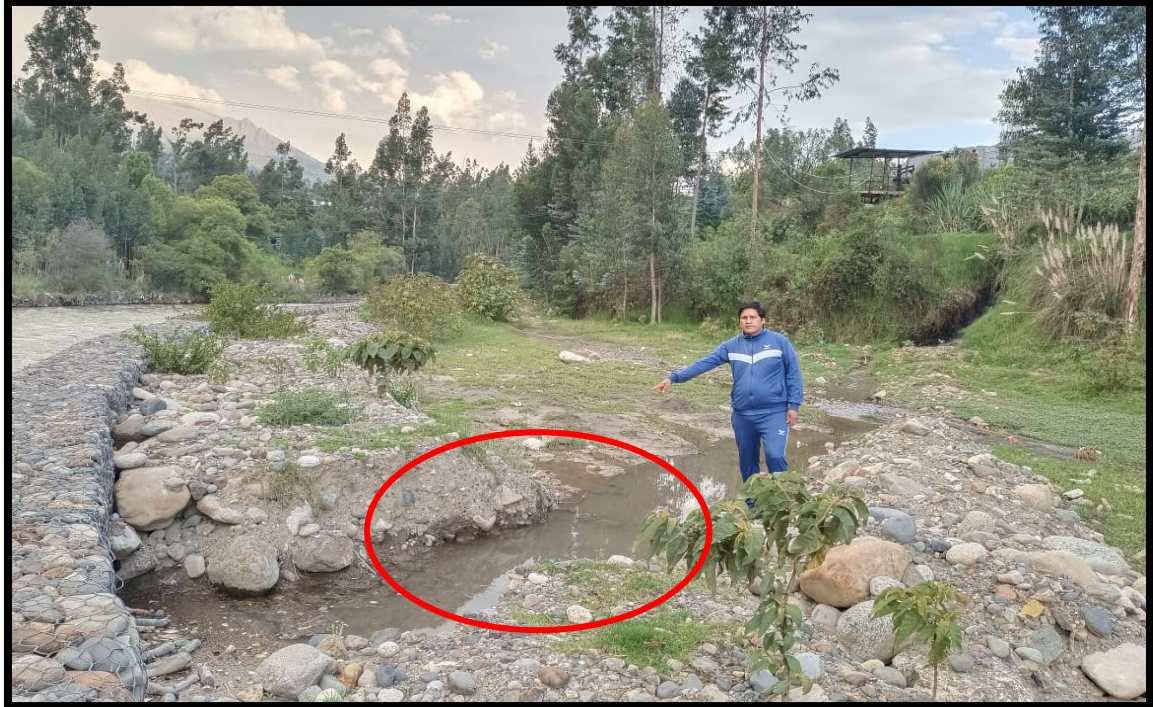
Figura 8 Acumulación de agua que proceden de la acumulación de la zona urbana del distrito de Jangas, así como la descolmatación del agua que conduce el canal de Chancarmayo
