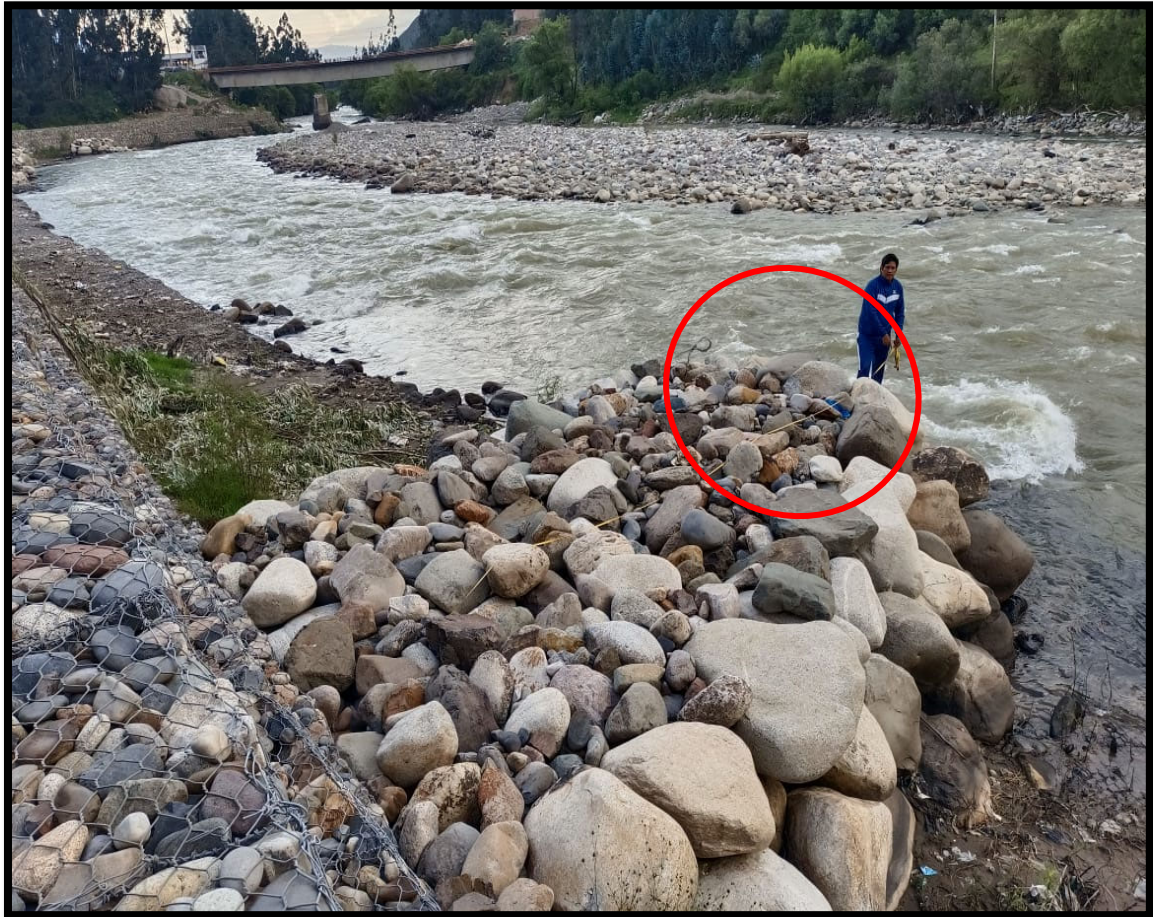
Figura 13 Espigones de protección
