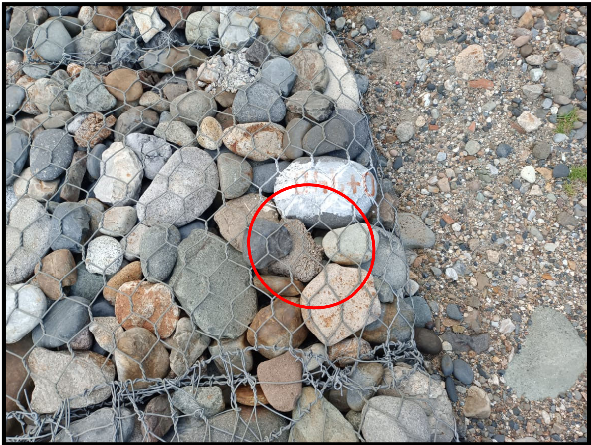
Figura 15 Acolchonamiento del muro de Gavión
