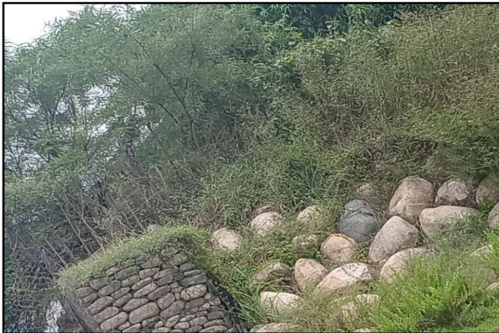
Figura 19: Evaluación Del Muro Con Gaviones Fuente: Elaboración propia (2024)
