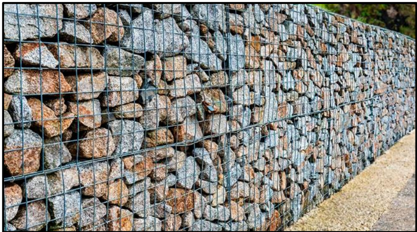
Figura 10: Muros De Contención Por Gaviones.
