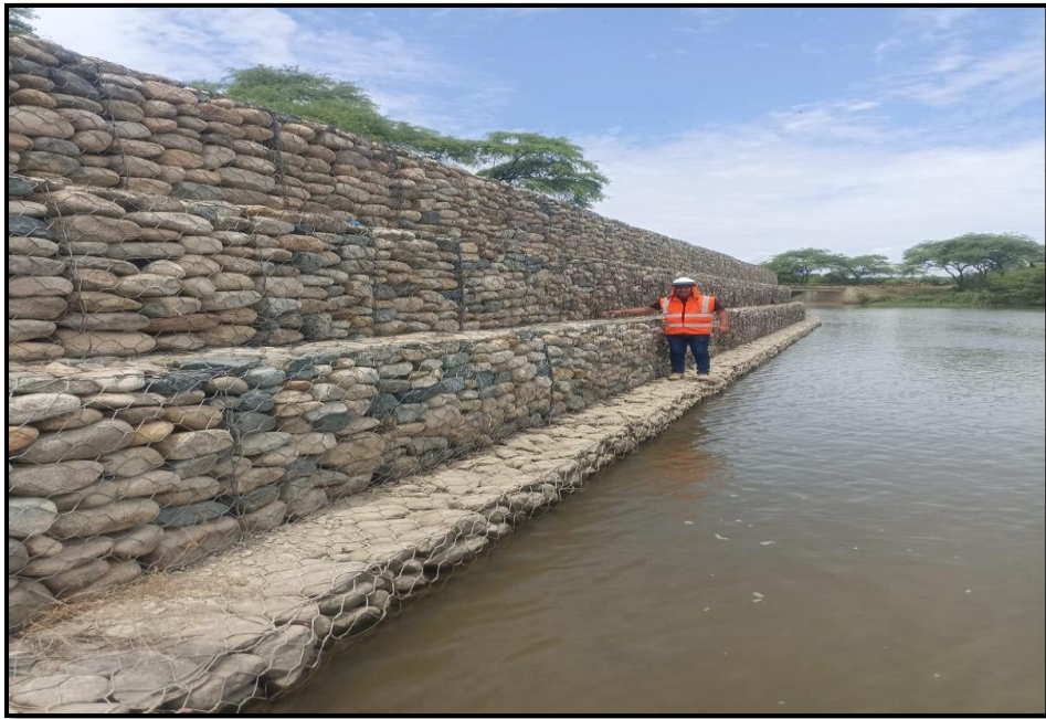
Figura 16: Evaluación Del Muro Con Gaviones Fuente: Elaboración propia (2024)
