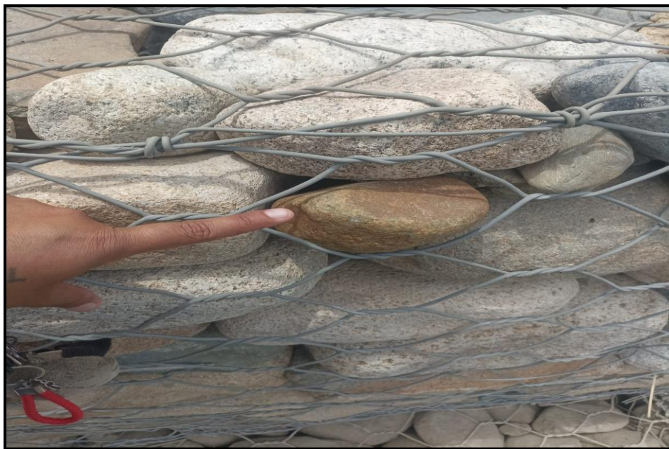
Figura 17: Evaluación Del Muro Con Gaviones Fuente: Elaboración propia (2024)
