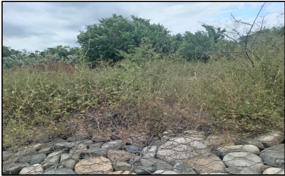
Figura 20: Evaluación Del Muro Con Gaviones Fuente: Elaboración propia (2024)
