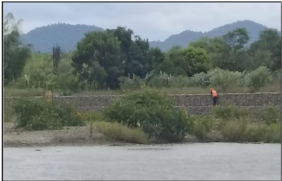
Figura 15: Evaluación Del Muro Con Gaviones Fuente: Elaboración propia (2024)
