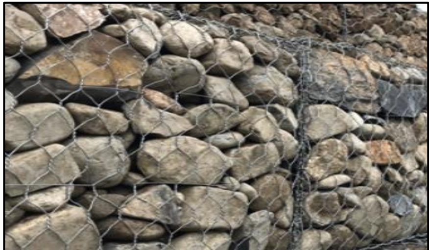
Figura 9: Rocas Para Llenados De Gavión.
