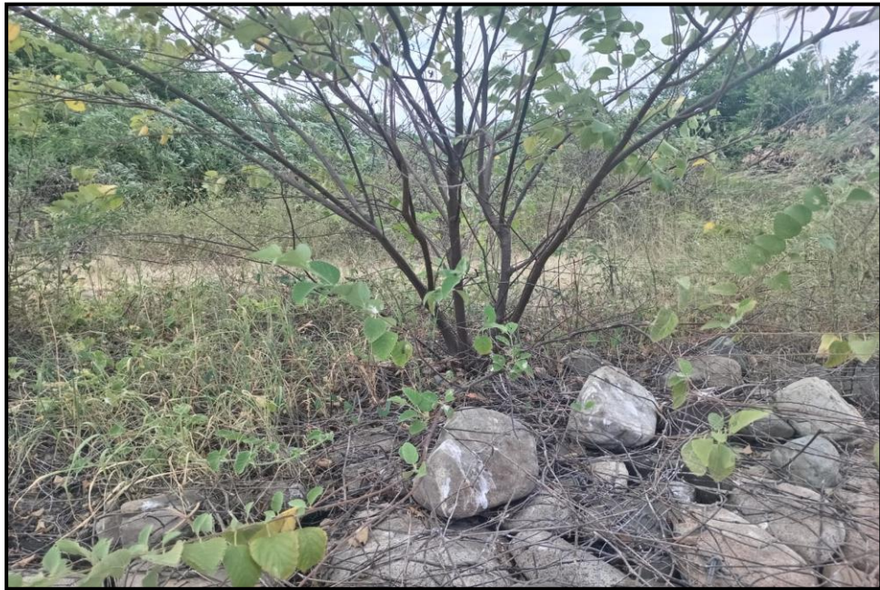
Figura 21: Evaluación Del Muro Con Gaviones Fuente: Elaboración propia (2024)
