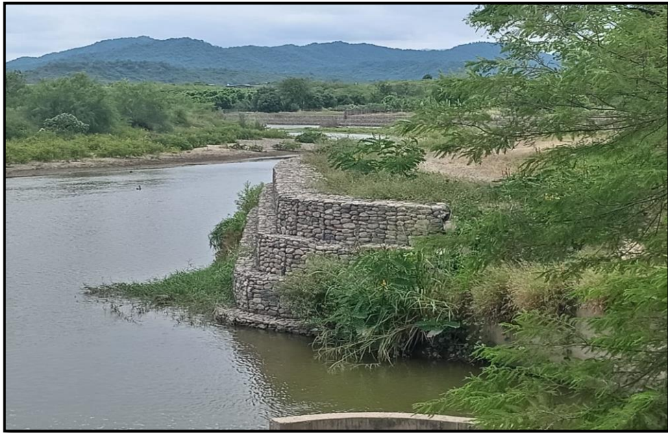
Figura 18: Evaluación Del Muro Con Gaviones Fuente: Elaboración propia (2024)
