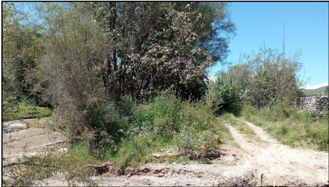
Figura 16: Vista del rio Pongora y el muro de gaviones
