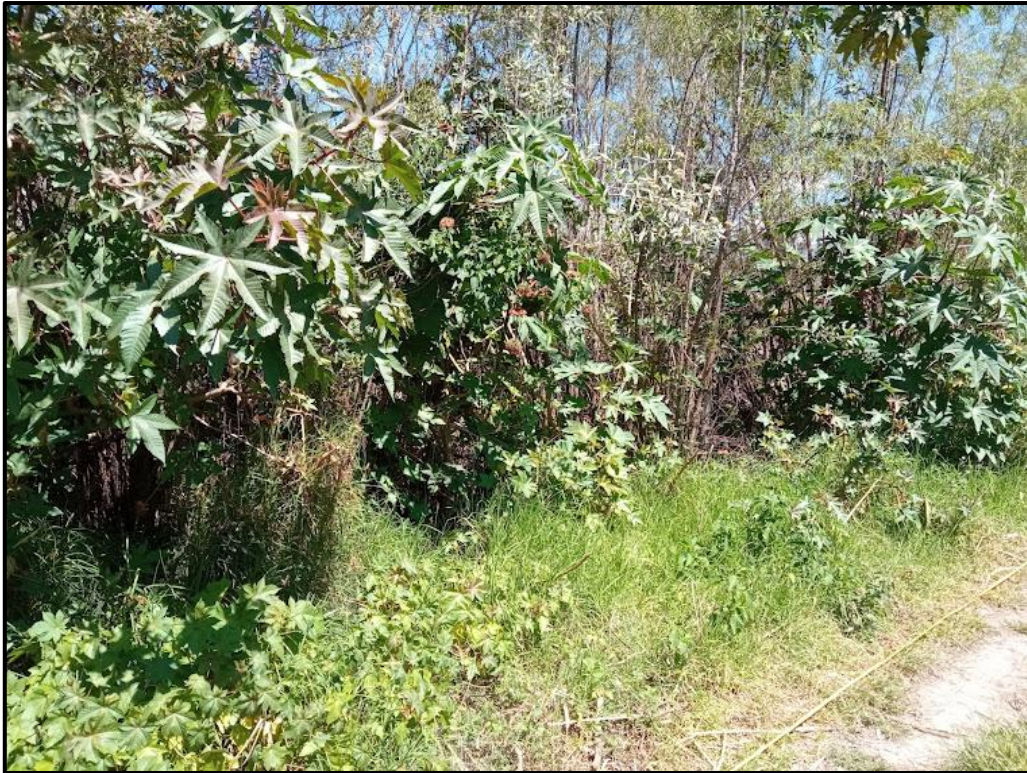
Figura 23: Vegetación frondosa en el muro de gavión
