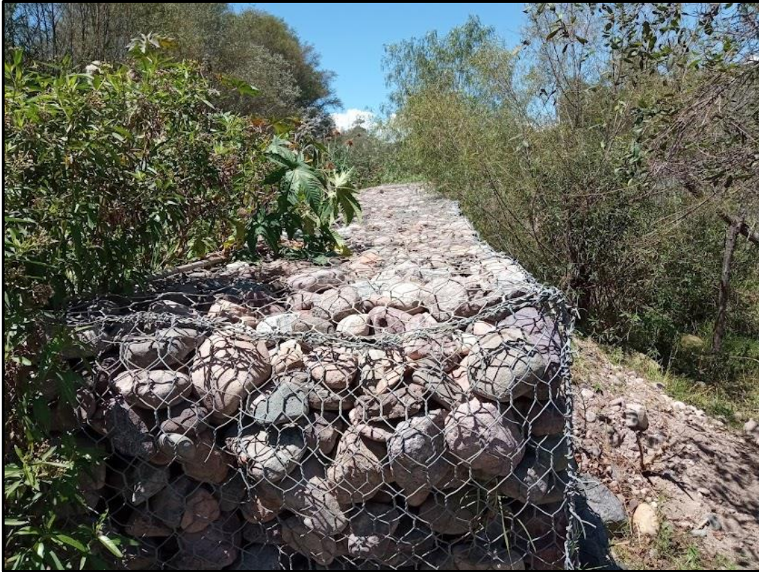
Figura 15: Vista del longitudinal del muro de gaviones
