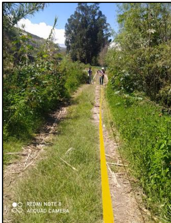
Figura 18: Medición de la longitud del muro de gaviones
