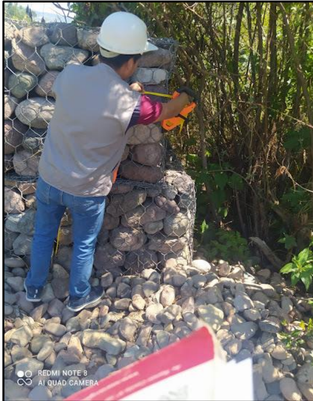
Figura 17: Medición del muro de gaviones
