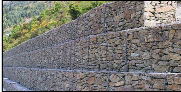
Figura 9: Muro de gaviones
