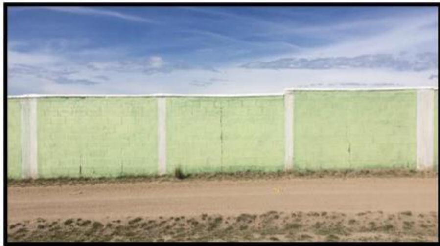
Figura 09. Imagen de Cerco Perimétrico
