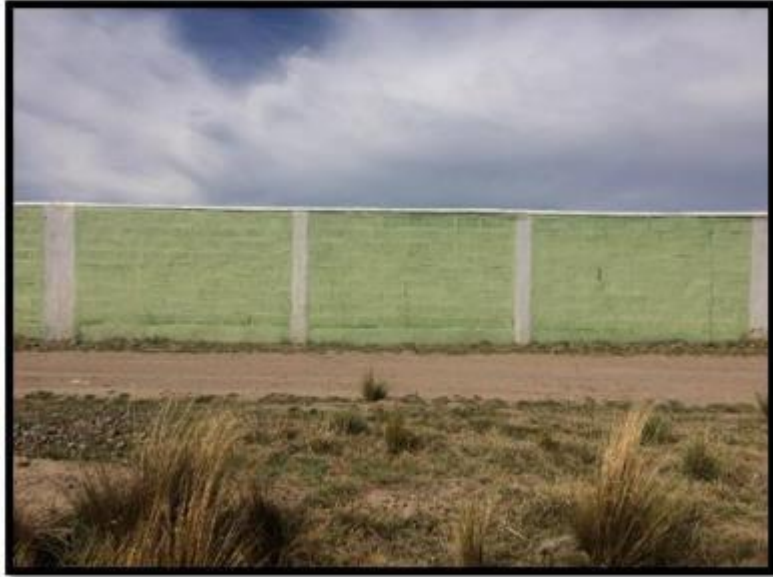
Figura 06. Imagen de Muro Fuente: Elaboración Propia (2017)
