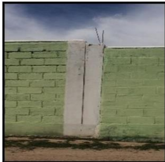
Figura 03. Imagen de Columna
