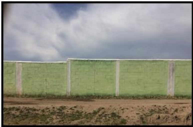
Figura 07. Imagen de Albañilería confinada Fuente: Elaboración Propia (2017)
