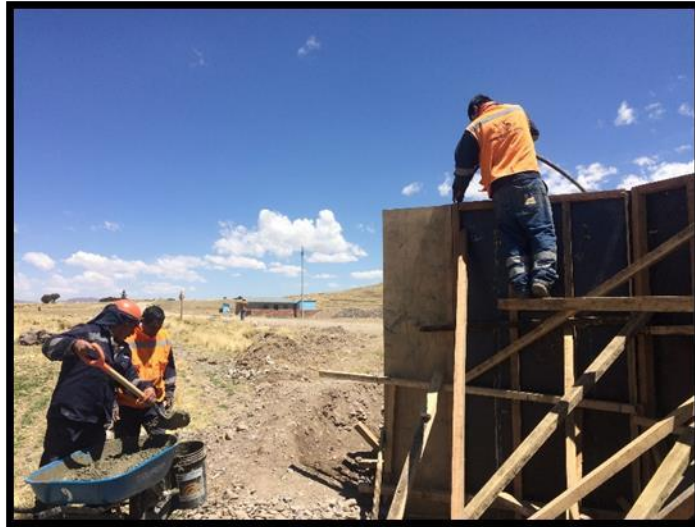
Figura 01. Imagen de Concreto Armado
