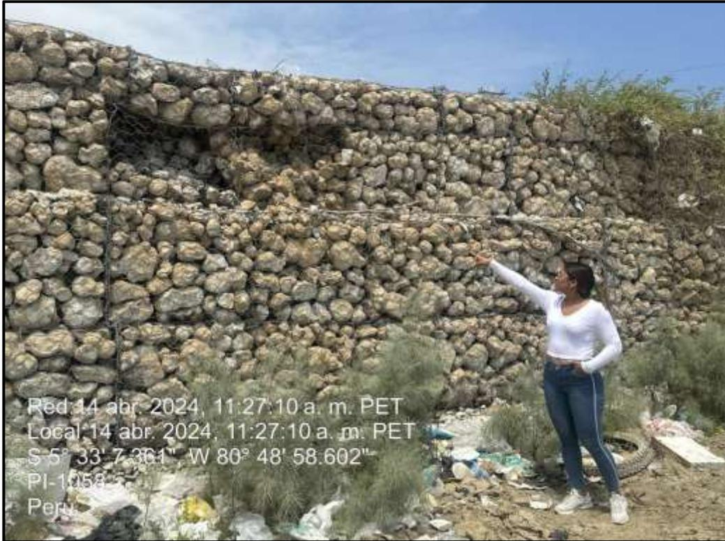
Figura 7: Evaluando el muro de gaviones
