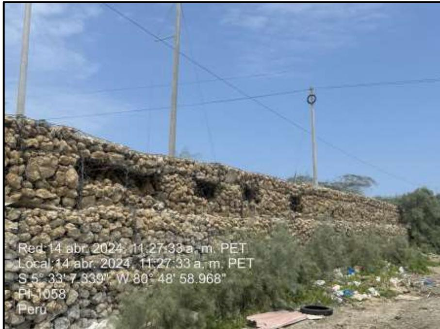
Figura 3: Falta de mantenimiento y limpieza del muro de gaviones
