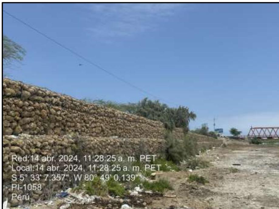
Figura 2: Muro de gaviones existente a evaluar
