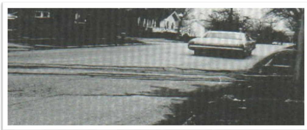
Figura 2.17 cruce de vía férrea de alta severidad.
