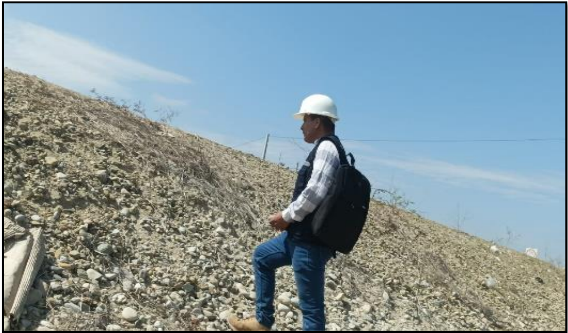
Figura 19: talud del dique.
