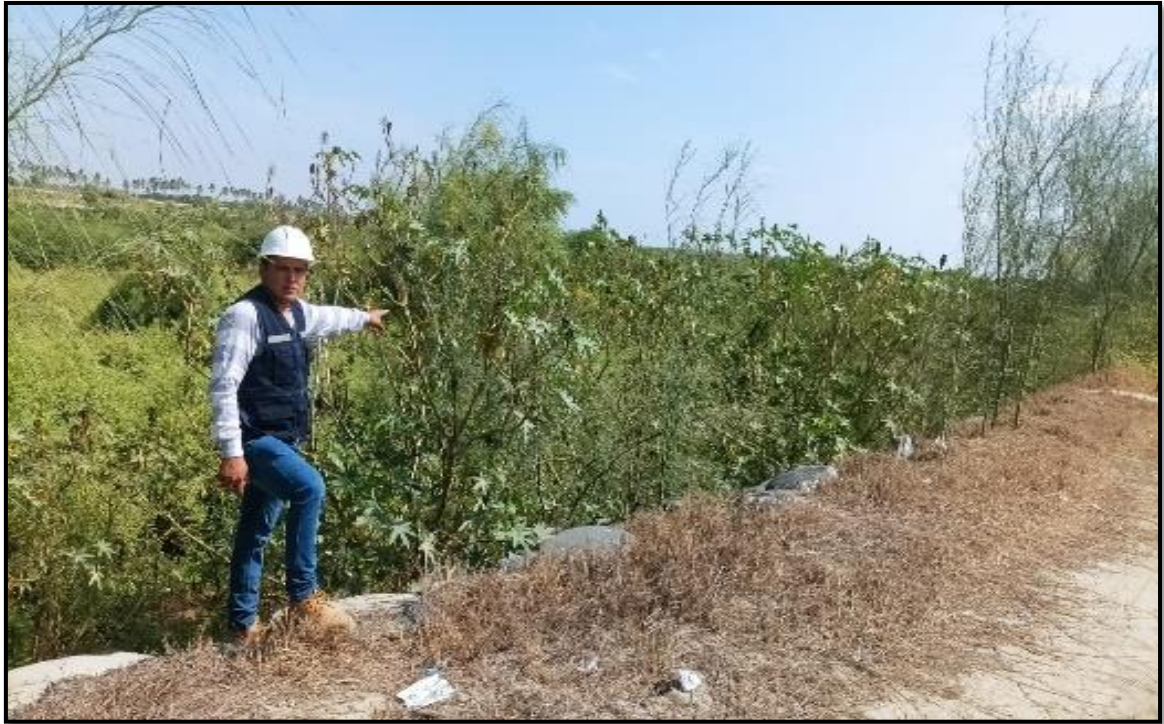
Figura 1: Presencia de vegetación en la parte superior del talud.
