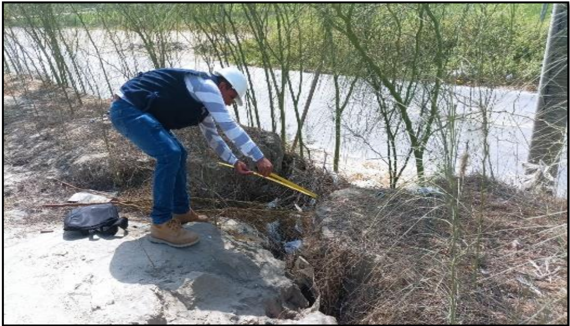
Figura 11: identificación de roturas del dique.
