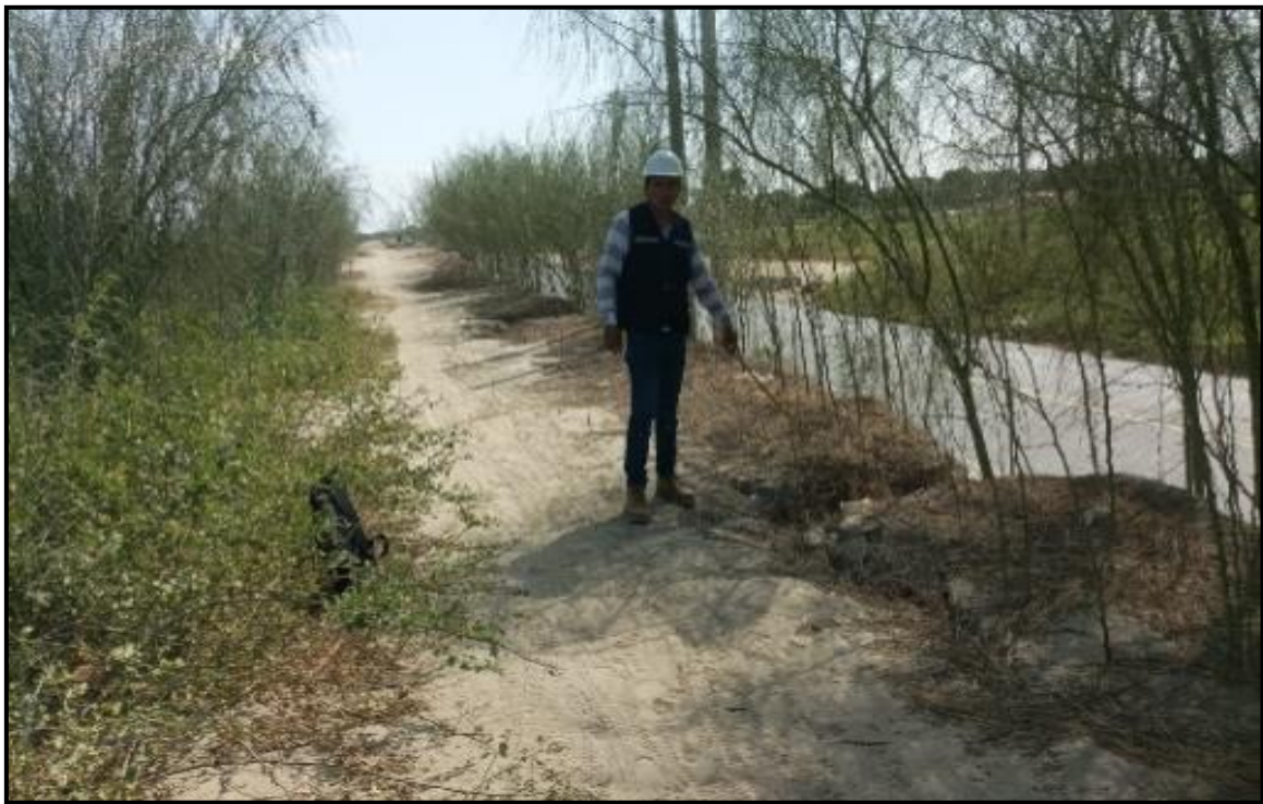
Figura 4: Se observa vegetación en la corona y plantas en el talud exterior al río.
