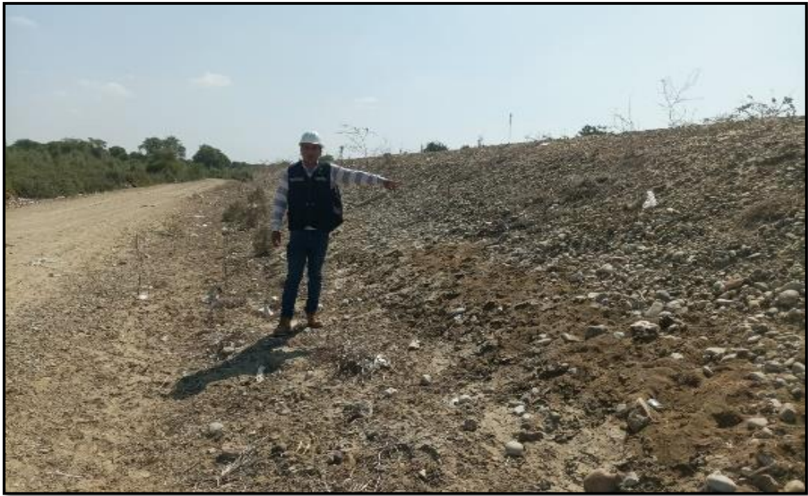
Figura 13: observación del material granular.
