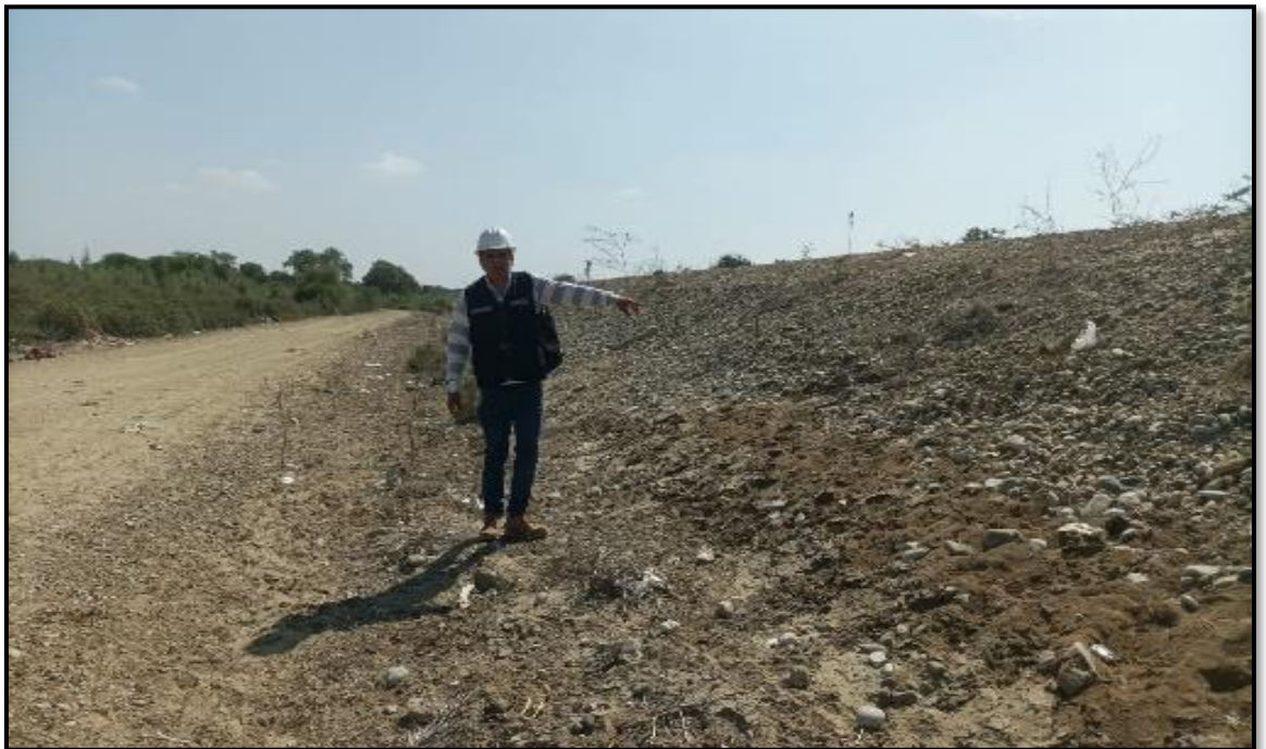
Figura 12: evaluación del material que está conformado el dique.
