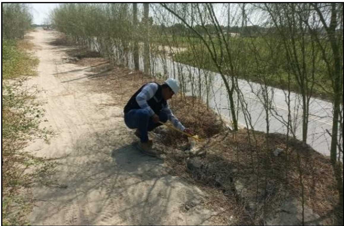
Figura 6: identificación de grietas.
