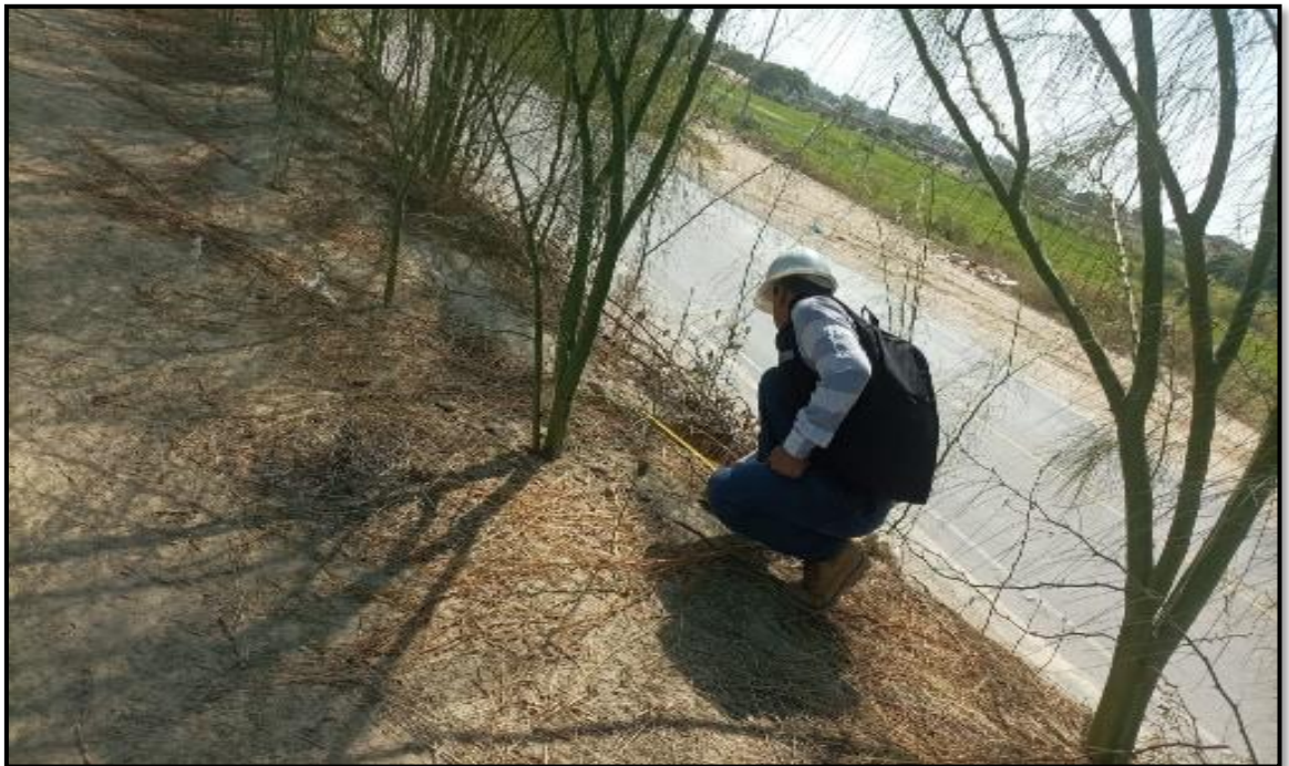
Figura 8: presencia de ramas y tallos, que cubren el dique.
