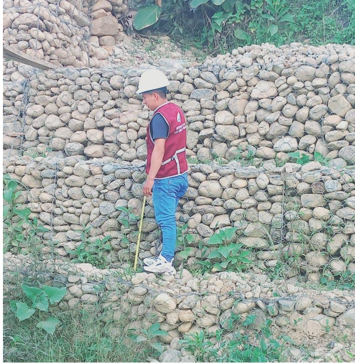
Figura 3: Verificando la altura de cada hilada del gavión
