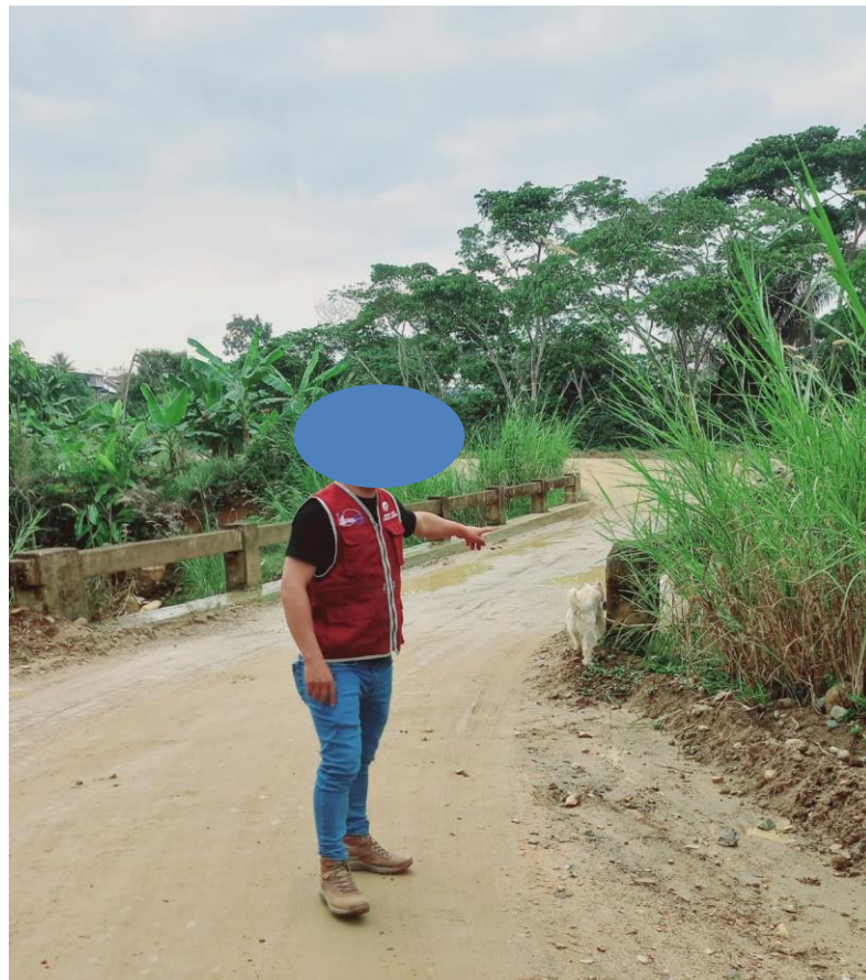
Figura 8: Pontón existente a unos 15 metros del muro de gaviones
