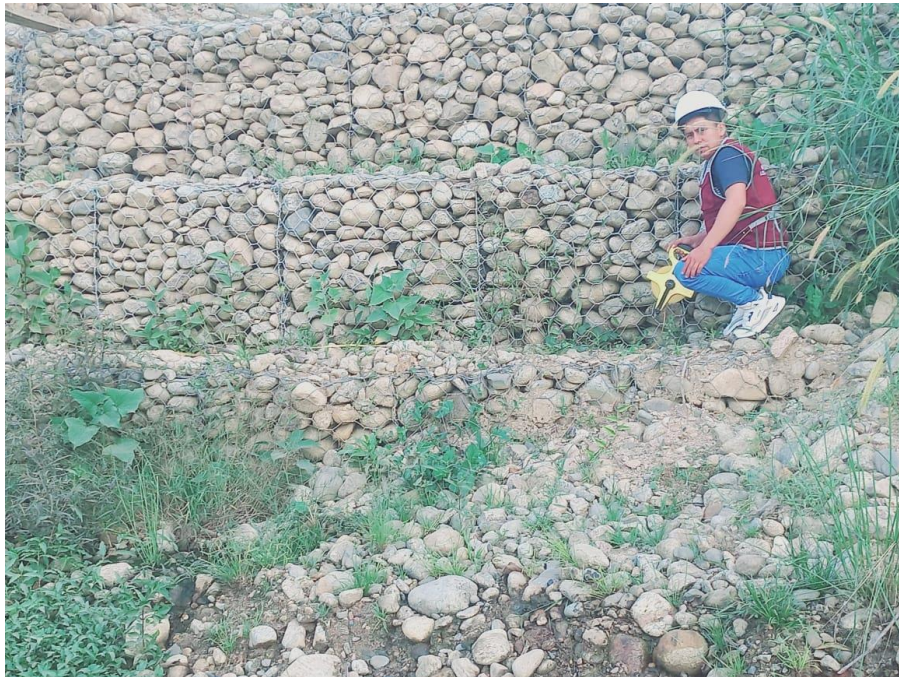
Figura 2: Realizando medición de la longitud del muro de gaviones
