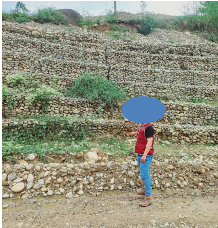
Figura 10: Vista general donde se está evaluando el muro de gaviones
