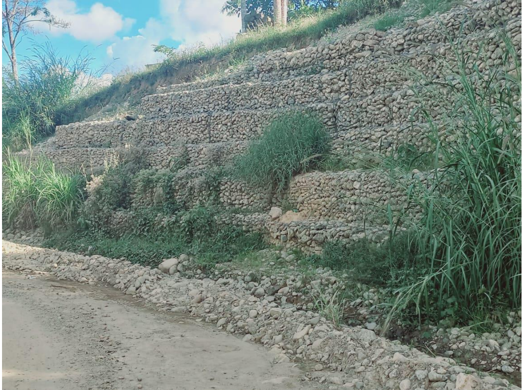
Figura 5: Vista de todas la hiladas del muro de gaviones
