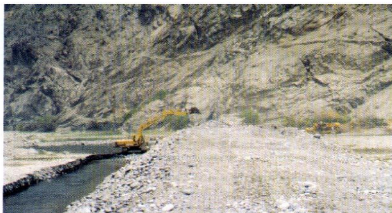
Foto N°4. Tractor iniciando armado de terraplén
