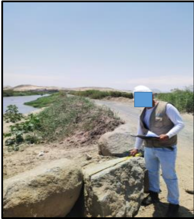
Imagen 2 Medición de las Dimensiones del Enrocado Tramo 6+200 Al 6+300 km
