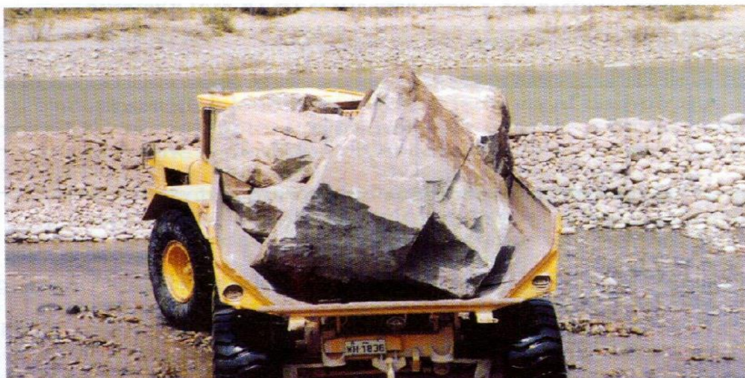
Foto N°7- Volquete especial trasportando roca
