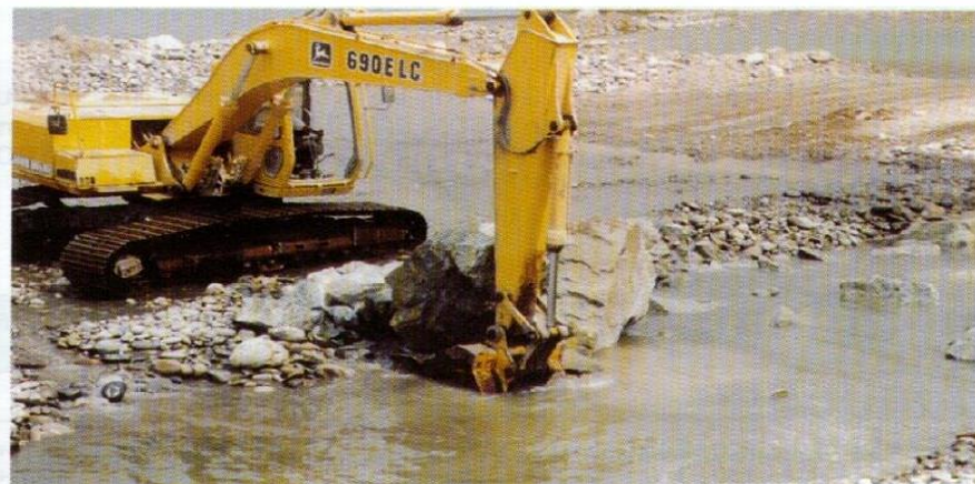
FOTO N°8. EXCAVADORA COLOCANDO ROCA EN LA UÑA NOTESE LA PROFUNDIDAD DE ESTAS
