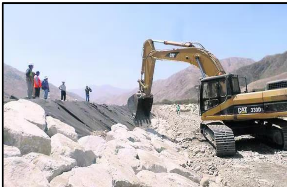
Figura 1 Construcción De Enrocado Fuente: Diario Correo
