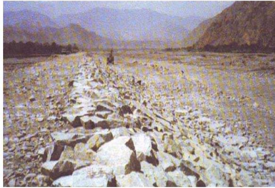
Figura 6.3. Fotografía de un enrocado con roca colocada al volteo
