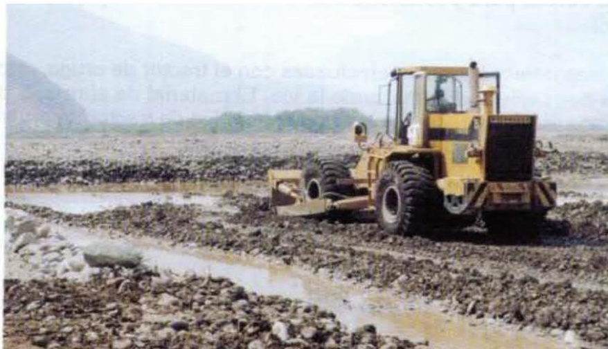
Foto N°3- Preparación de vía de acceso
