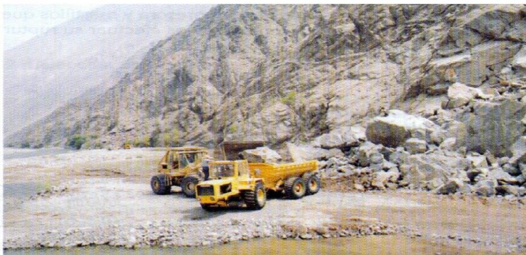
Foto N°6-Carguío de roca con equipo
