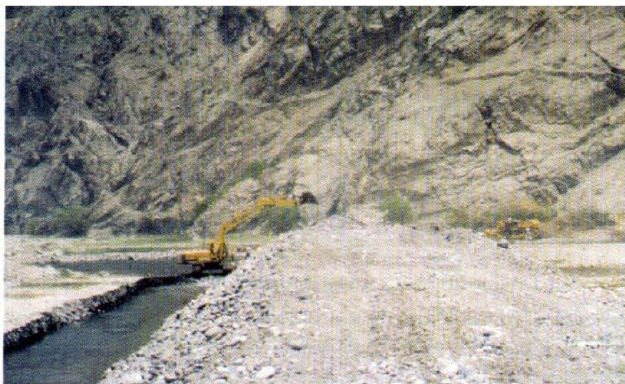
Foto N°5. Excavadora culminando la apertura de la uña de estabilidad
