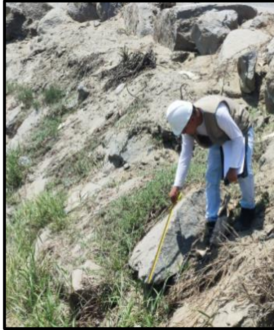
Fotografía 5 Medición del Dimensionamiento del Enrocado de la Defensa Ribereña del Tramo 6+100 a 6+200 km
