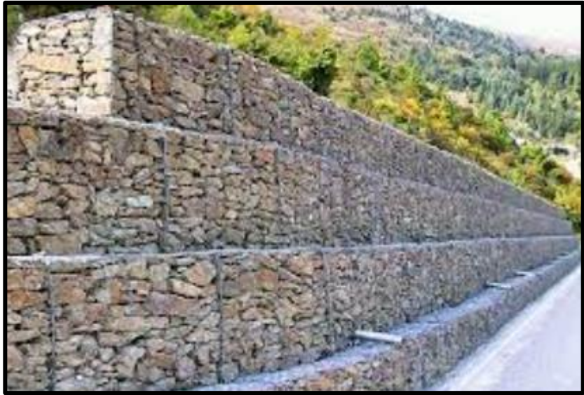
Figura 11 Gaviones tipo Caja Fuente: CYPE Ingenieros S.A.
