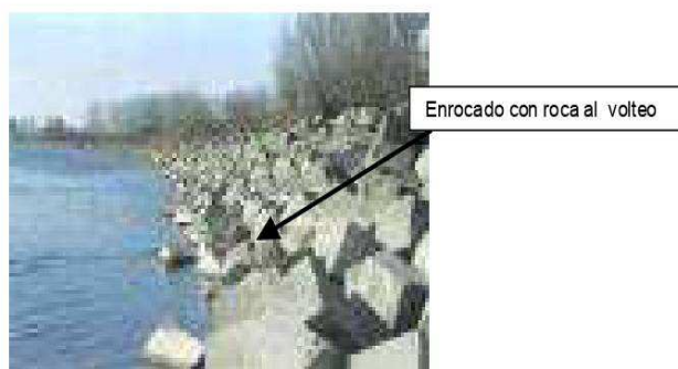
Figura 6.2. Fotografía de un enrocado con roca al volteo
