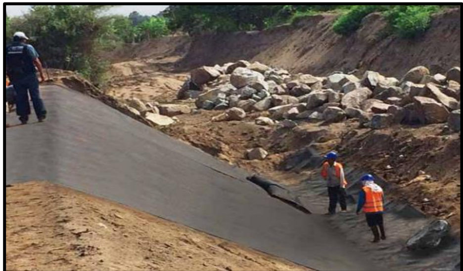
Figura 4 Geotextil de protección para enrocado de dique Fuente: Cidelsa "GEOSINTÉTICOS", Pág. 10
