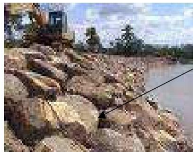
Figura 6.5 Fotografía de un enrocado con roca colocada
