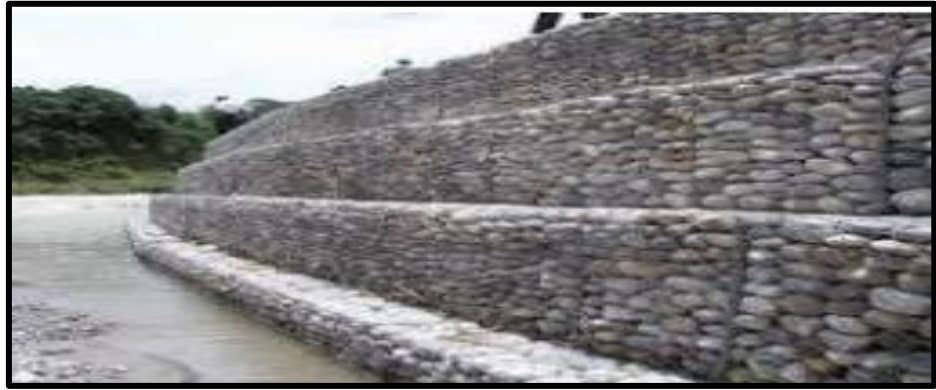
Figura 3 Muro enrocado Fuente: Ministerio de Economía y Finanzas
