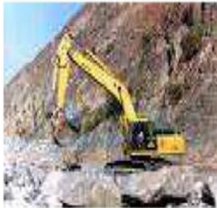
Figura 6.7. Volcado del enrocado con maquinaria
