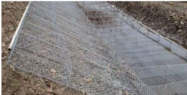
Figura N° 1: Gavión de tipo colchón
