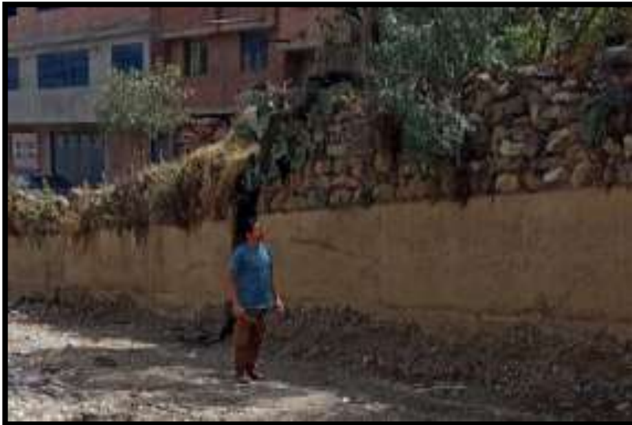
Figura N°20: Muro provisional de 354ml
