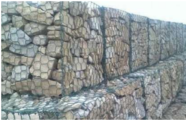
Figura N° 5: Gaviones de alambre
