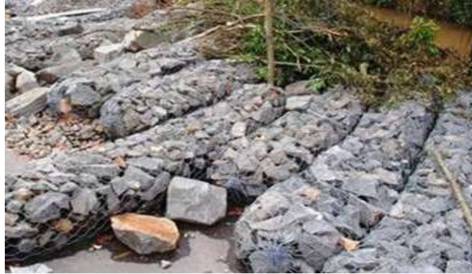
Figura N° 2: Gavión tipo saco
