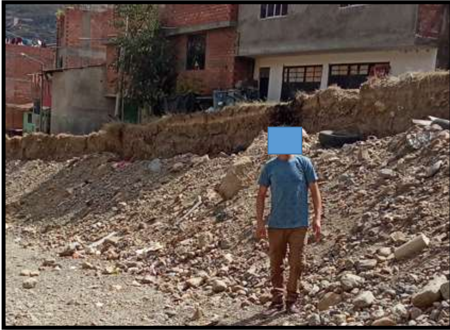
Figura N°19: No existe muro de gaviones
