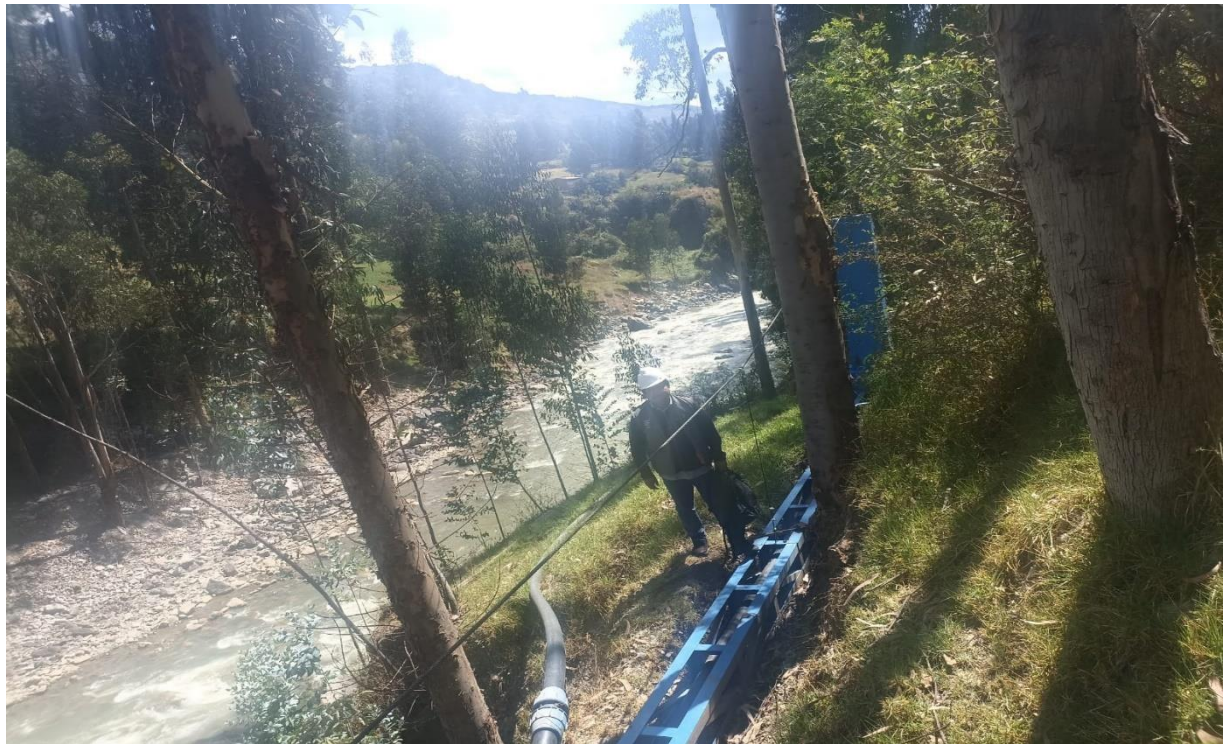
Fotografía 08. Se evidencia la progresiva 0+100 km, en donde se plantea la ubicación del muro de contención.
