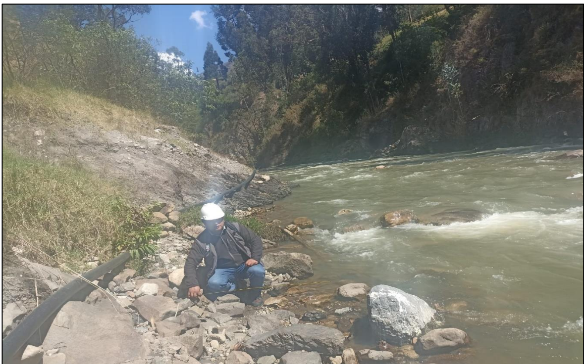
Fotografía 06. Se evidencia la topografía del cauce del Ríos mosna, la cual presente márgenes irregulares en su recorrido.
