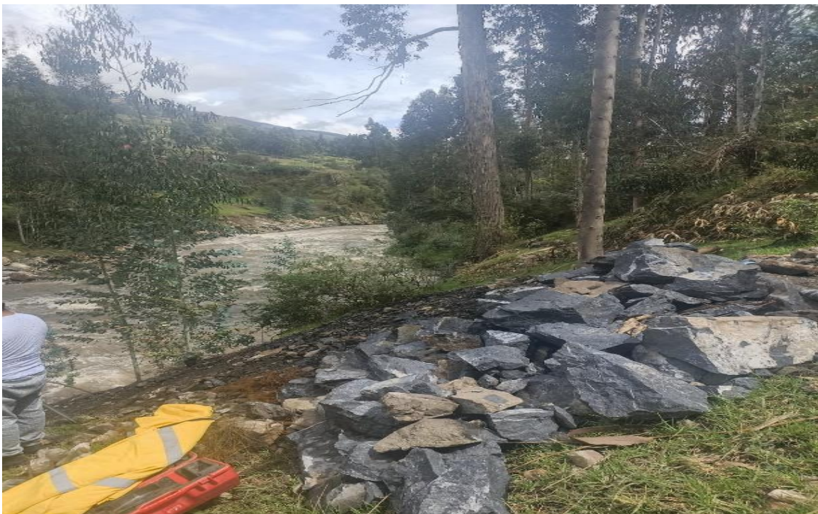
Fotografía 12: Visita la presencia de rocas en el trayecto de muro de contención proyectado
