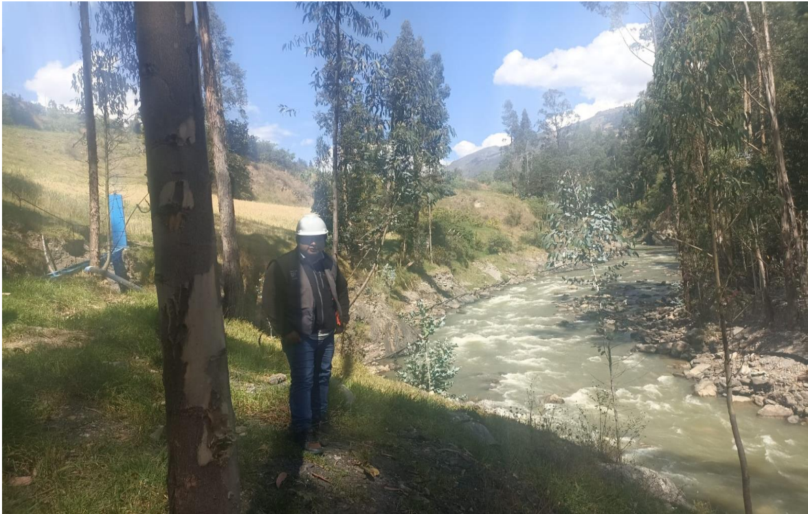
Fotografía 09. Se evidencia la progresiva 0+150 km, en donde se plantea la ubicación del muro de contención.
