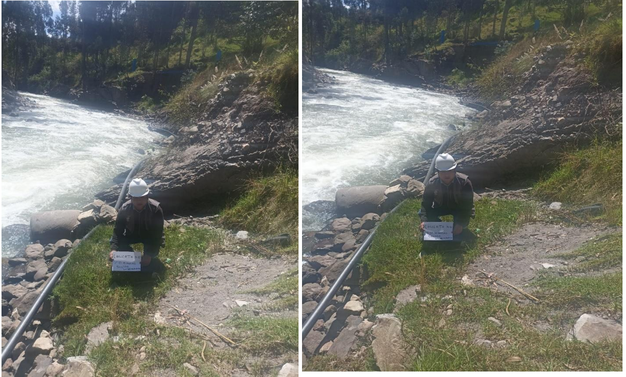
Fotografía 07. Se evidencia la ubicación de la calicata donde se planteó la excavación a 3.00m
