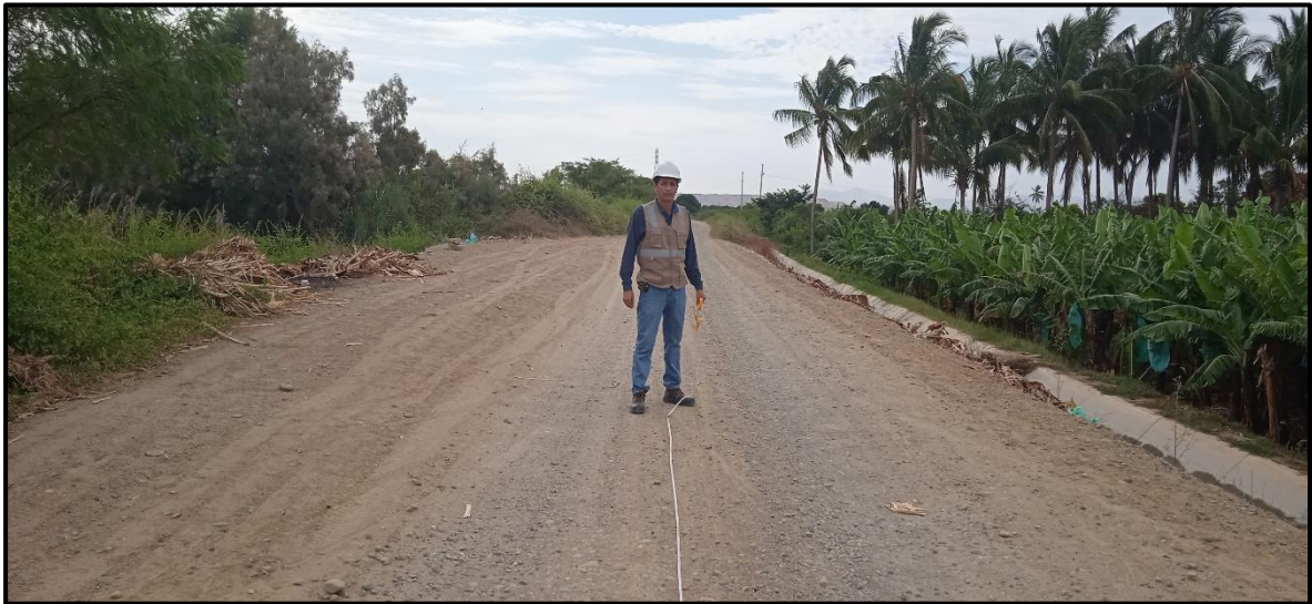
FOTOGRAFIA 05: Midiendo la longitud del dique progresiva final 10+500, (tomada el 13/04/2024).
