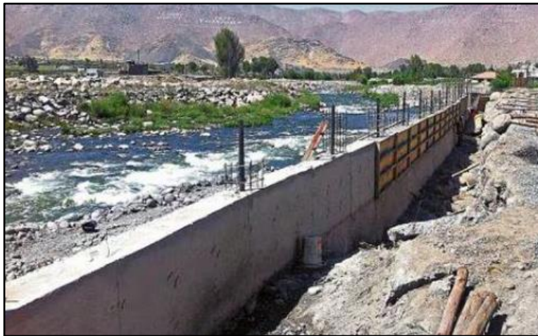
Figura 4. Muro de contención en ribera de río (24).
