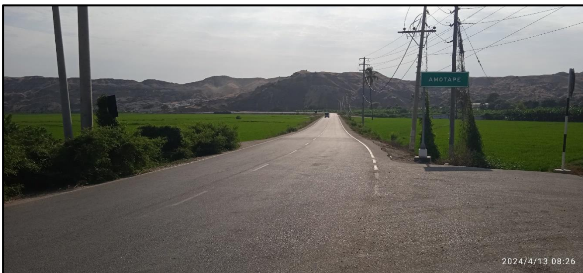
FOTOGRAFIA 18: Vista de carretera costanera junto al puente Simón Rodríguez. Punto donde termina el dique (tomada el 13/04/2024).
