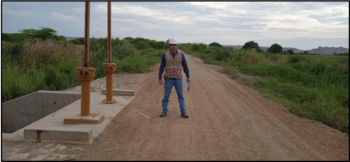
FOTOGRAFIA 12: Pase de agua y evaluación del dique progresiva 5+300, (tomada el 09/05/2024).
