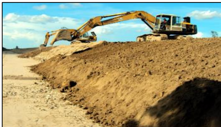
Figura 6. Conformación de terraplén, por medio de capas compactadas (25).
