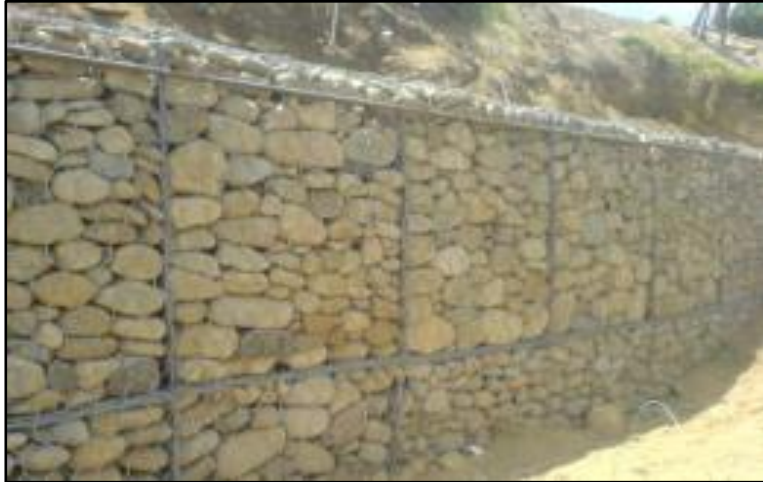
Figura 1. Apariencia final de los Muros de Gaviones (7).
