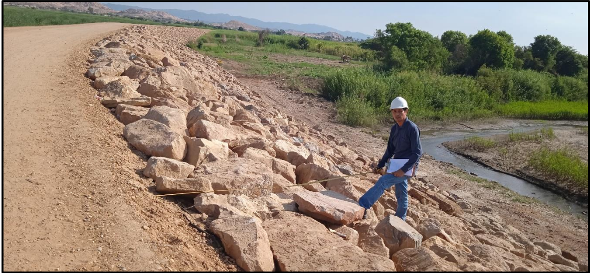
FOTOGRAFIA 04: Medición de enrocado en progresiva 4+400 a 4+800, (tomada el 30/03/2024).
