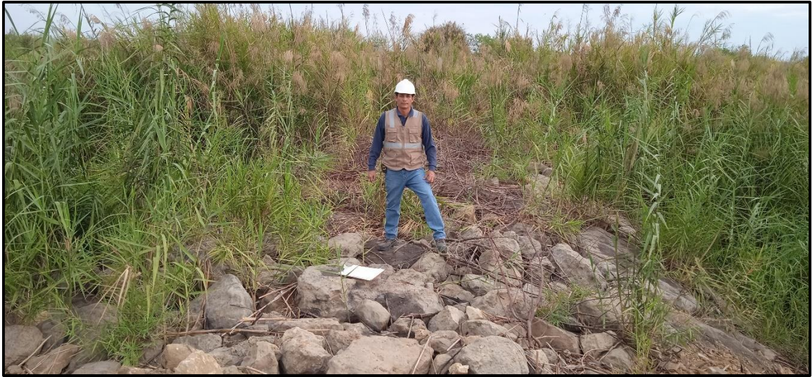
FOTOGRAFIA 10: Verificando condiciones de espigón de asta simple, (tomada 09/05/2024)
