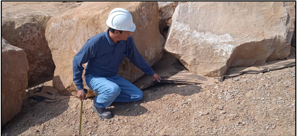
FOTOGRAFIA 03: Se evidencia geomembrana sobre el talud donde se asienta el enrocado, tramo 4+400 a 4+800 (tomada el 30/03/2024).
