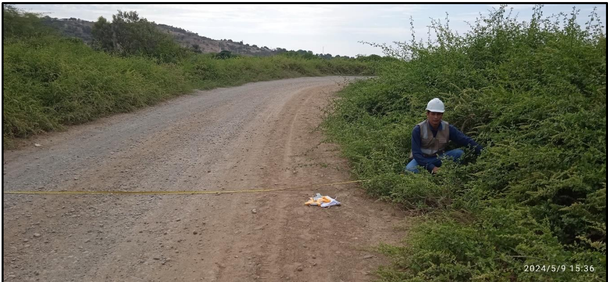
FOTOGRAFIA 13: Evaluación del dique progresiva 8+500, (tomada el 09/05/2024).
