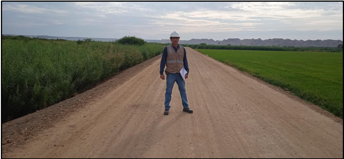
FOTOGRAFIA 15: tramo del dique que ha sido mejorado en la parte de corona y talud de ambos lados, progresiva 2+300 a 4+400, (tomada el 09/05/2024).
