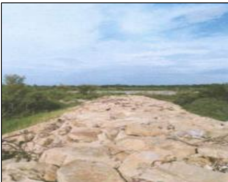
Figura 2. Dique de enrocado construido con rocas de areniscas grandes, margen derecha del río Chira, aguas debajo de la presa Poechos: fue elaborado por Hernández (35).
