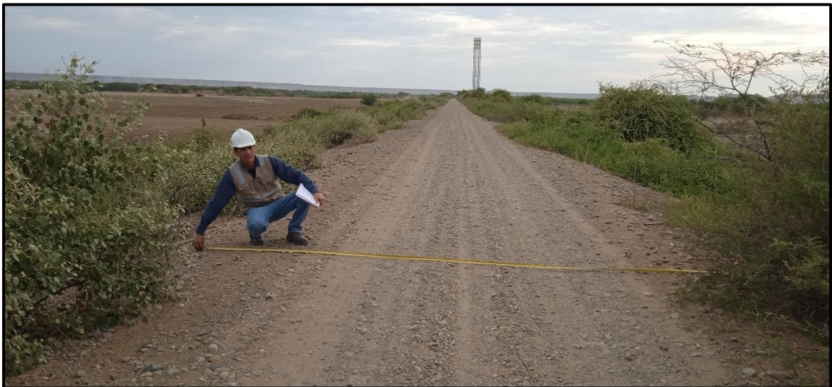
FOTOGRAFIA 07: Medición de altura del talud (tomada el 13/04/2024).
