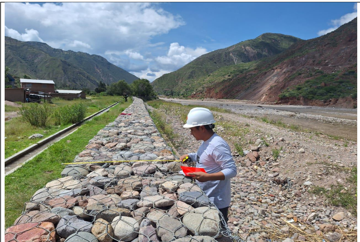
Foto N°4: se observa diferentes diámetros de los materiales empleados en el muro de gavión
