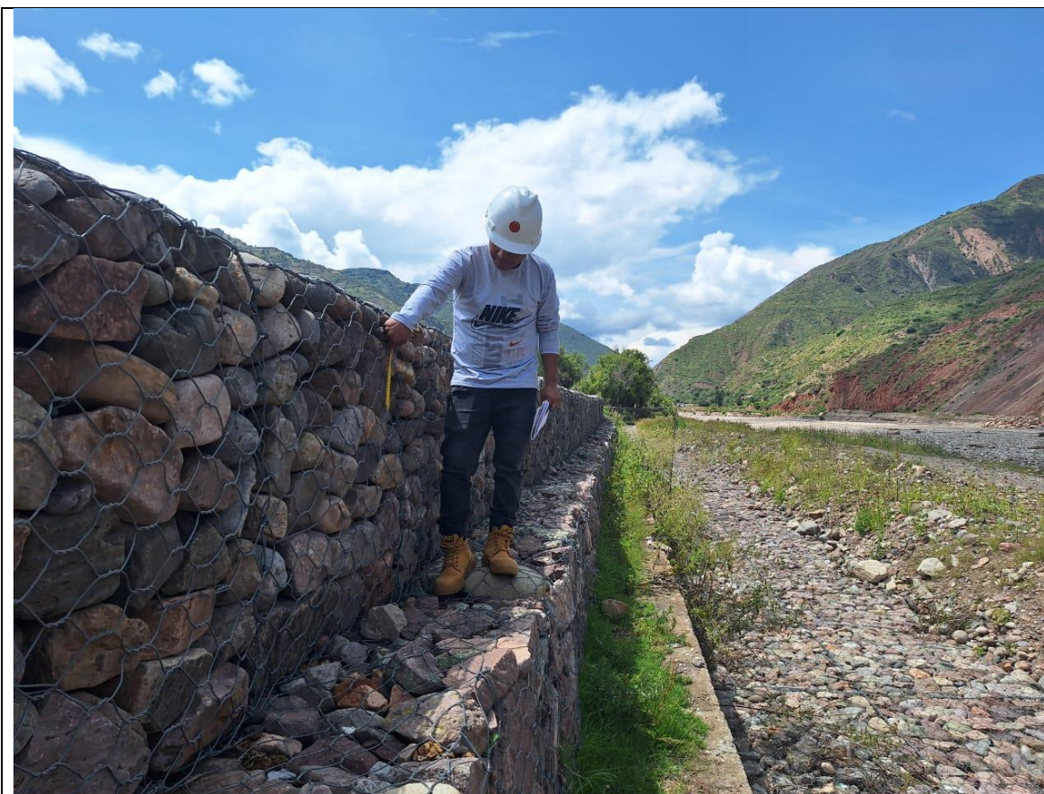
Foto N°5: se observa la medición de la estructura del muro de gavión
