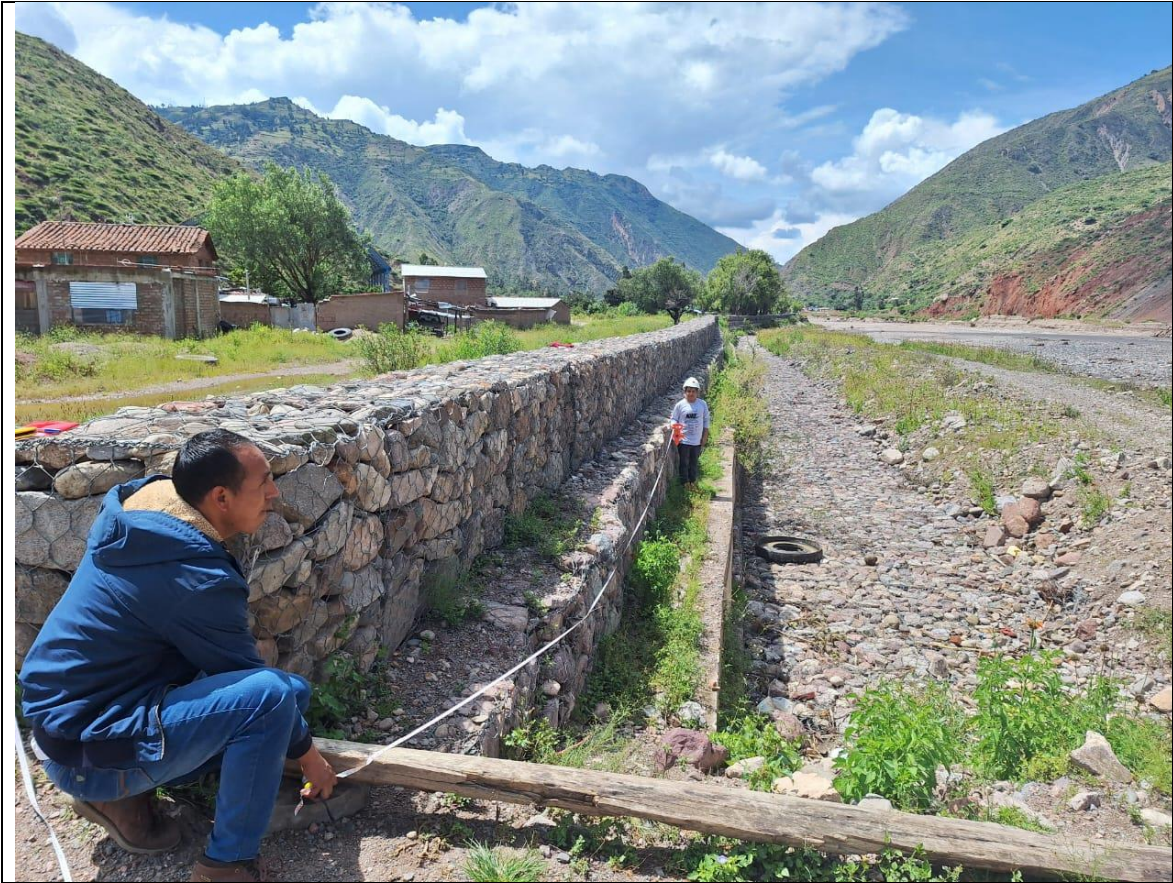
Foto N°3: se observa la medición de la estructura existente
