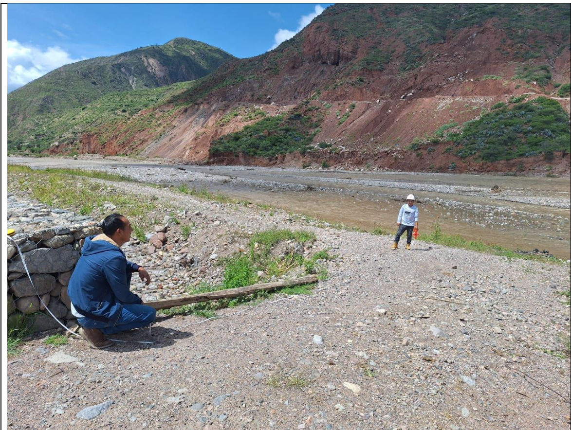
Foto N°2: se observa la medición del colchón
