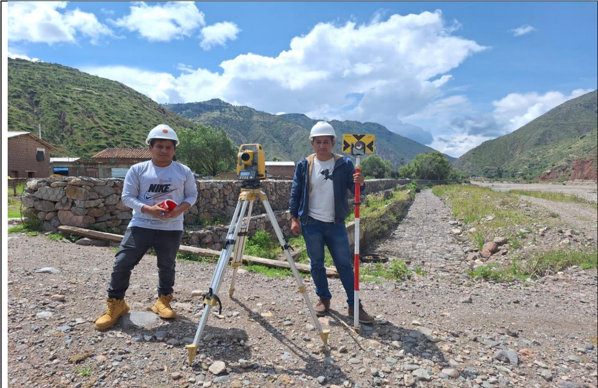
Foto N°1: se observa el lugar de la intervención
