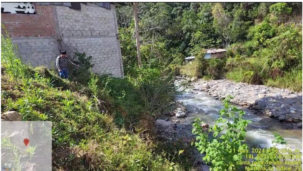
Figura 17: Fin de tramo de la defensa ribereña.
