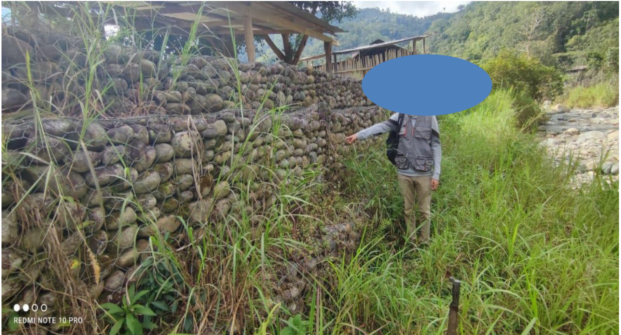
Figura 10: Vista panorámica de la defensa ribereña a evaluar
