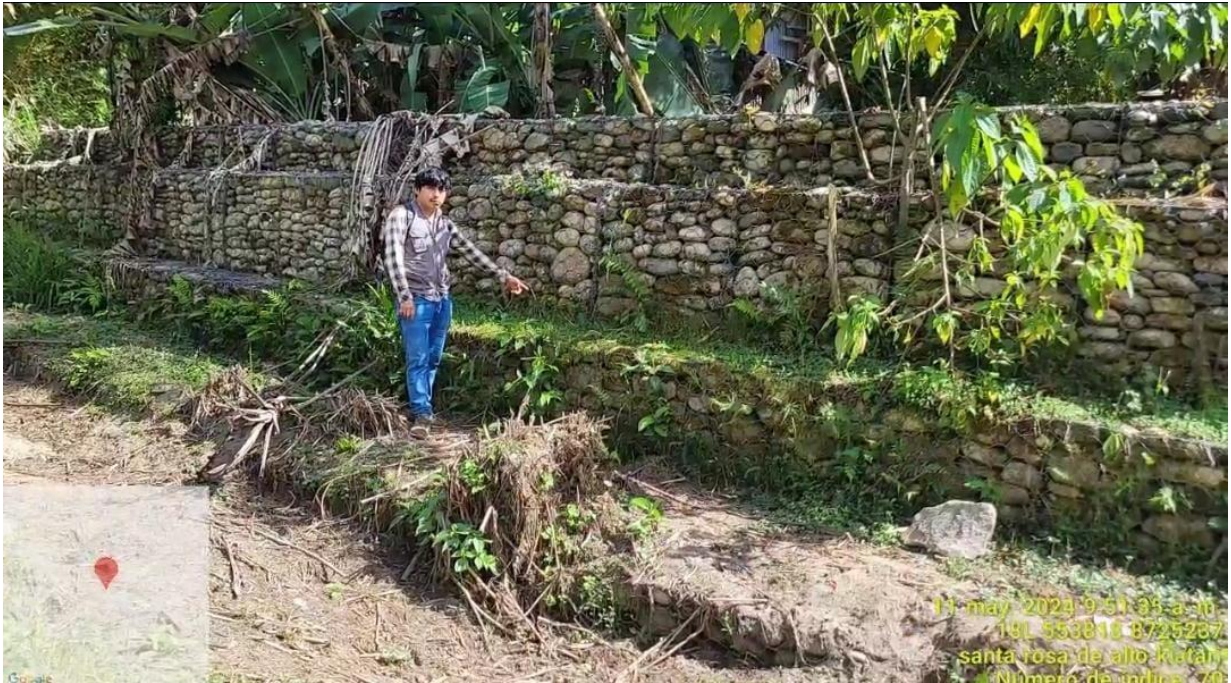
Figura 16: Muro de gavión tipo caja de 4 niveles.
