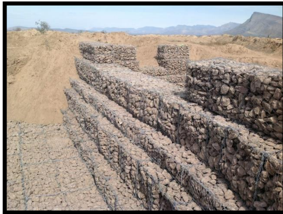
Figura 2: Evaluación del muro
