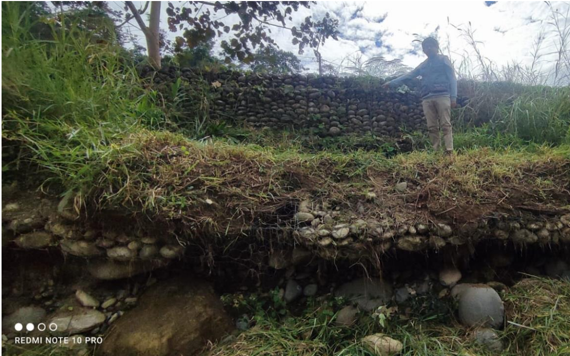
Figura 14: Muro de gavi3n tipo caja de 4 niveles.
