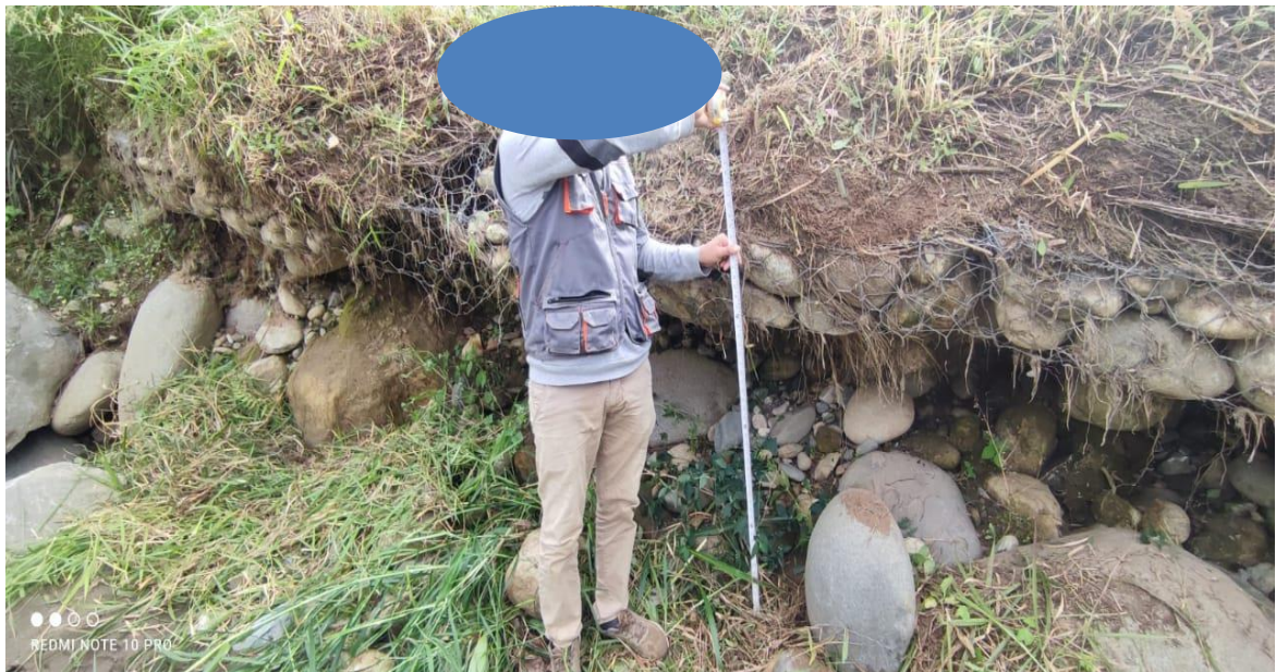
Figura 11: Tomando medida de la defensa ribereña tipo caja
