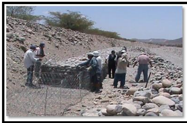
Figura 3: Gavión tipo Caja
