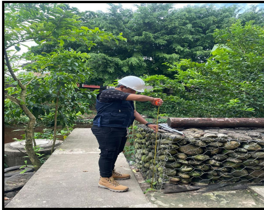
Figura 3: Evaluación de la progresiva 0+800 a 0+1100
