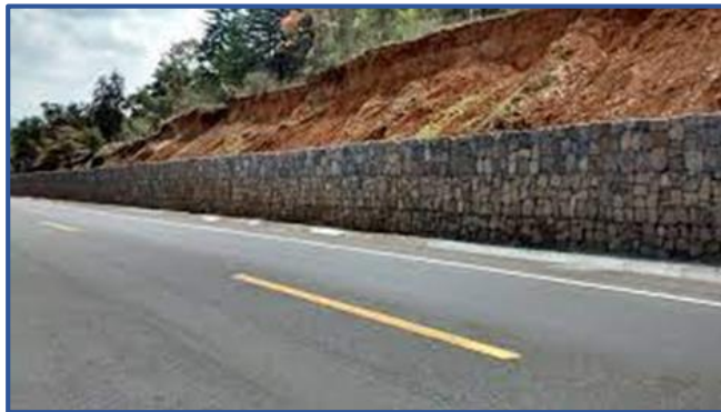
Figura 16: gaviones para protección vial. Obtenido del libro Vásquez et al (14).
