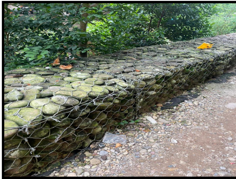
Figura 2: Evaluación de la progresiva 0+450 a 0+800
