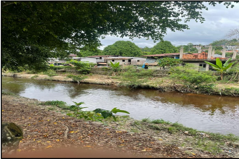
Figura 4: Frente del muro de gaviones existente
