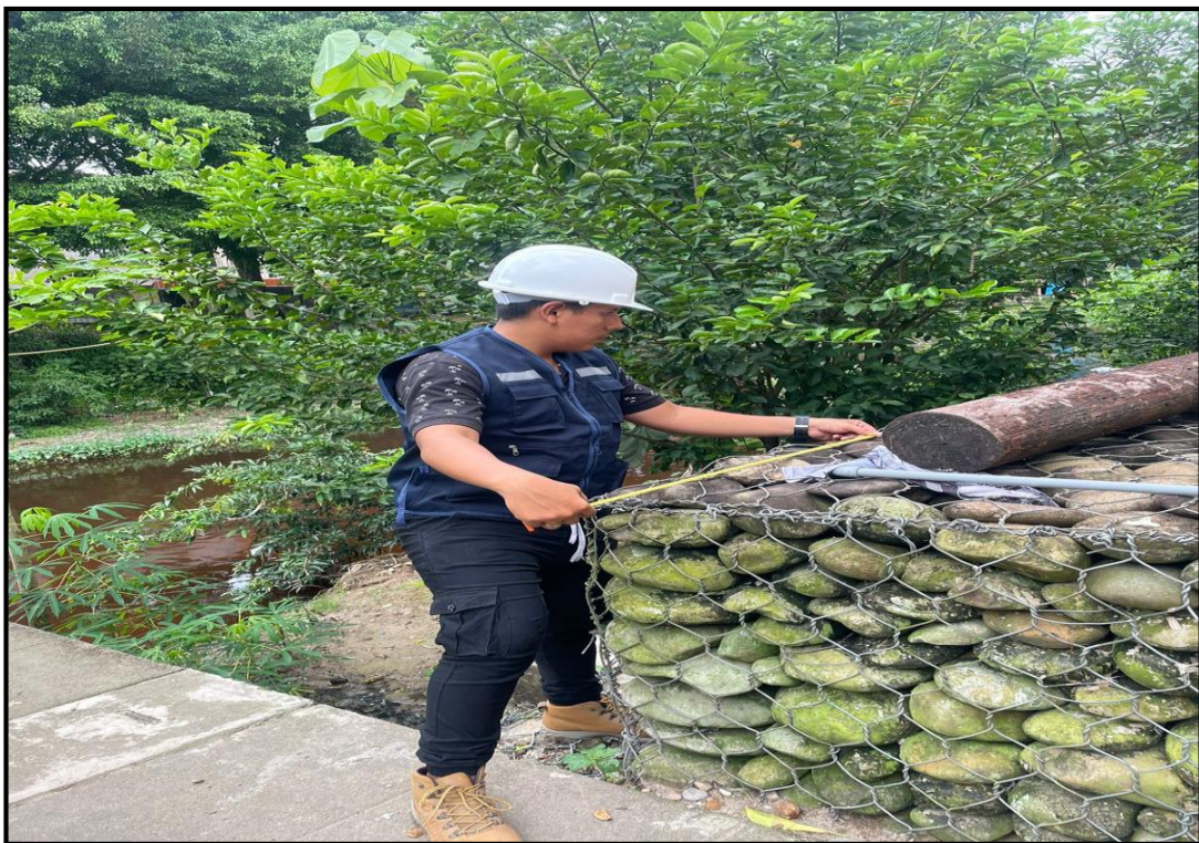
Figura 5: Medición de los gaviones
