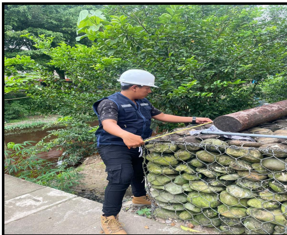
Figura 1: Evaluación de la progresiva 0+000 a 0+450
