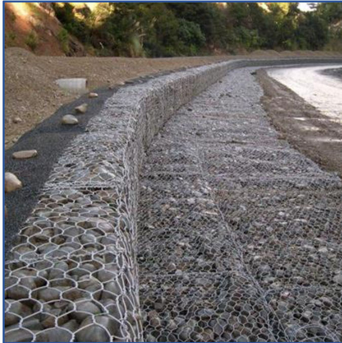
Figura 8: Gaviones tipo colchón. Obtenido del libro Vásquez et al (14).
