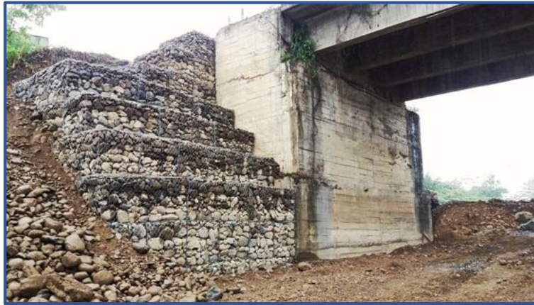
Figura 13: Gaviones para protección de puentes. Obtenido del libro Vásquez et al (14).
