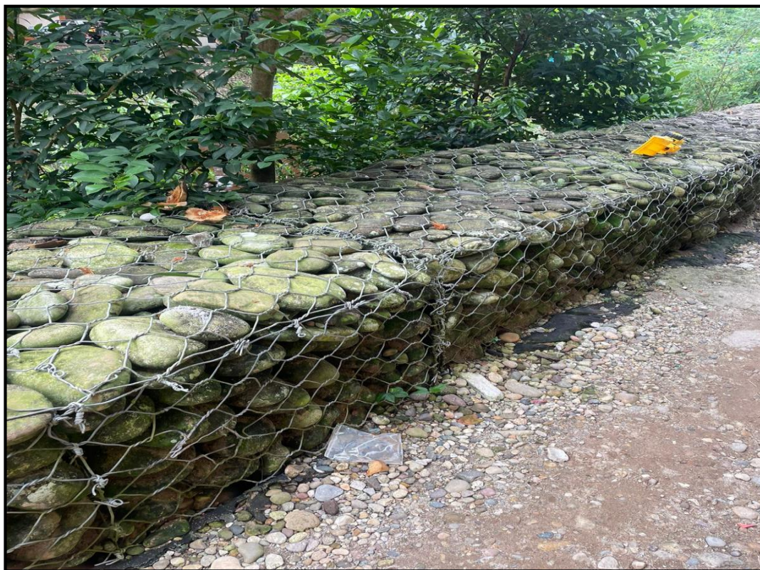
Figura 10: Muro de gaviones a evaluar
