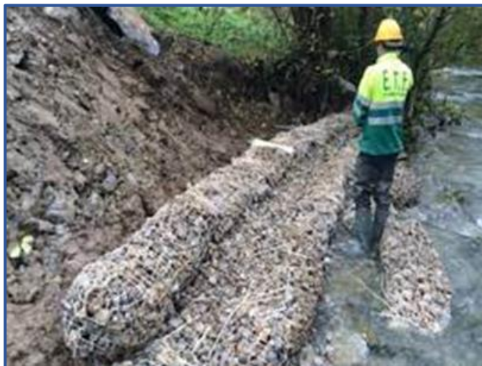
Figura 10: Gaviones tipo saco. Obtenido del libro Vásquez et al (14).
