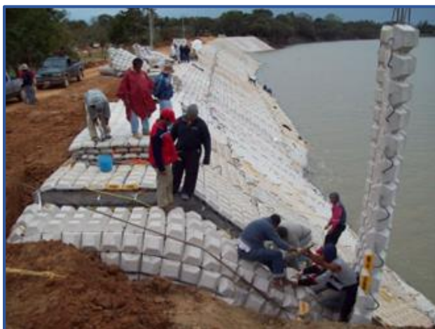
Figura 22: Concreto articulado. Obtenido del libro Almedia (15).
