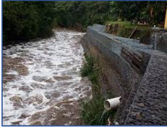
Figura 15: Gaviones para ríos y canales. Obtenido del libro Vásquez et al (14).
