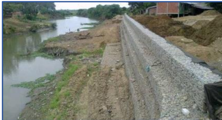
Figura 6: Muro de gaviones. Obtenido del libro Vásquez et al (14).
