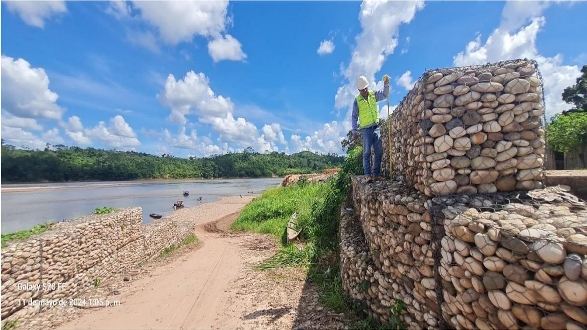
**Fotografía N°11:** Altura del 3 nivel del muro de gaviones
