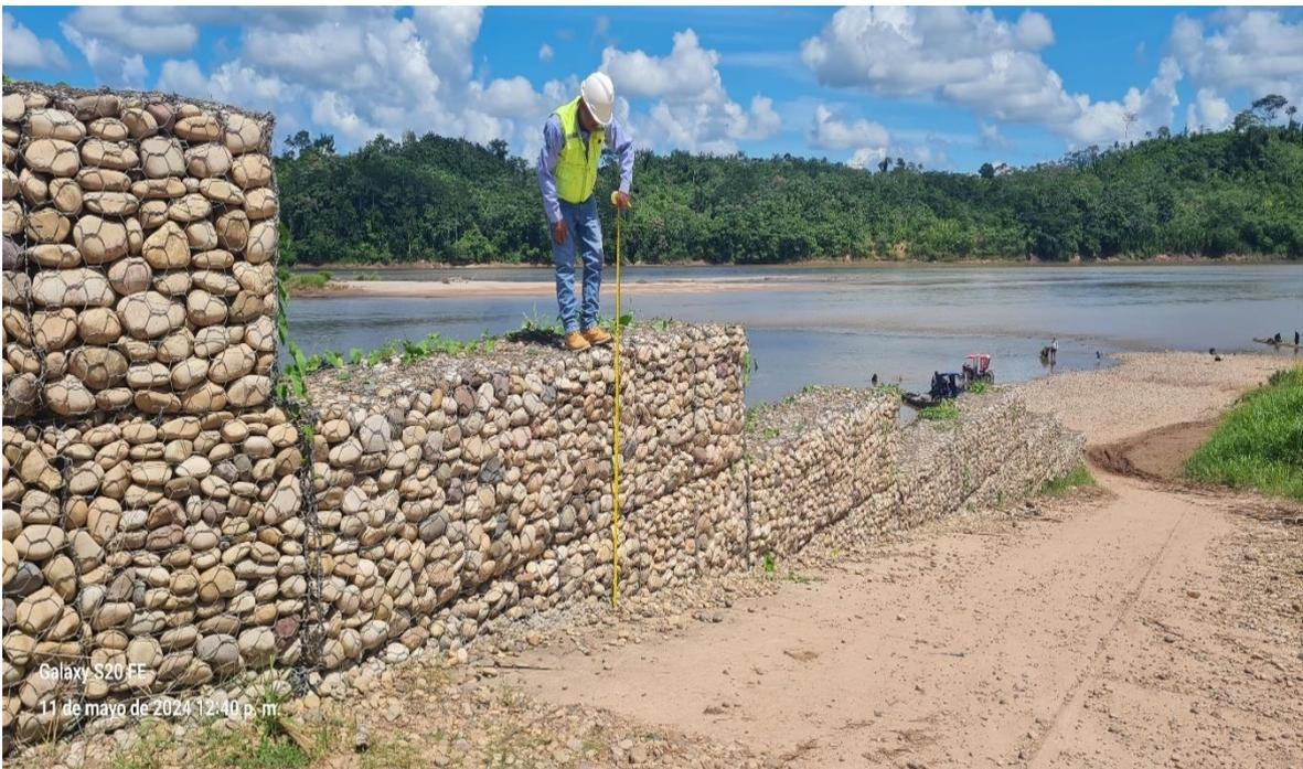
**Fotografía N°06: Altura del muro de gaviones**
