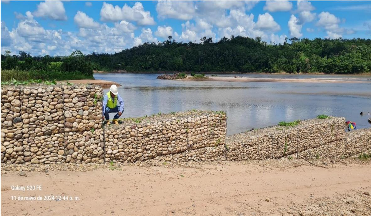
**Fotografía N°09:** hexagonales de las mallas de los gaviones
