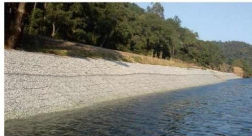
Figura 2. Gaviones para contención fluvial. Fuente:(A Bianchini, 2017).
