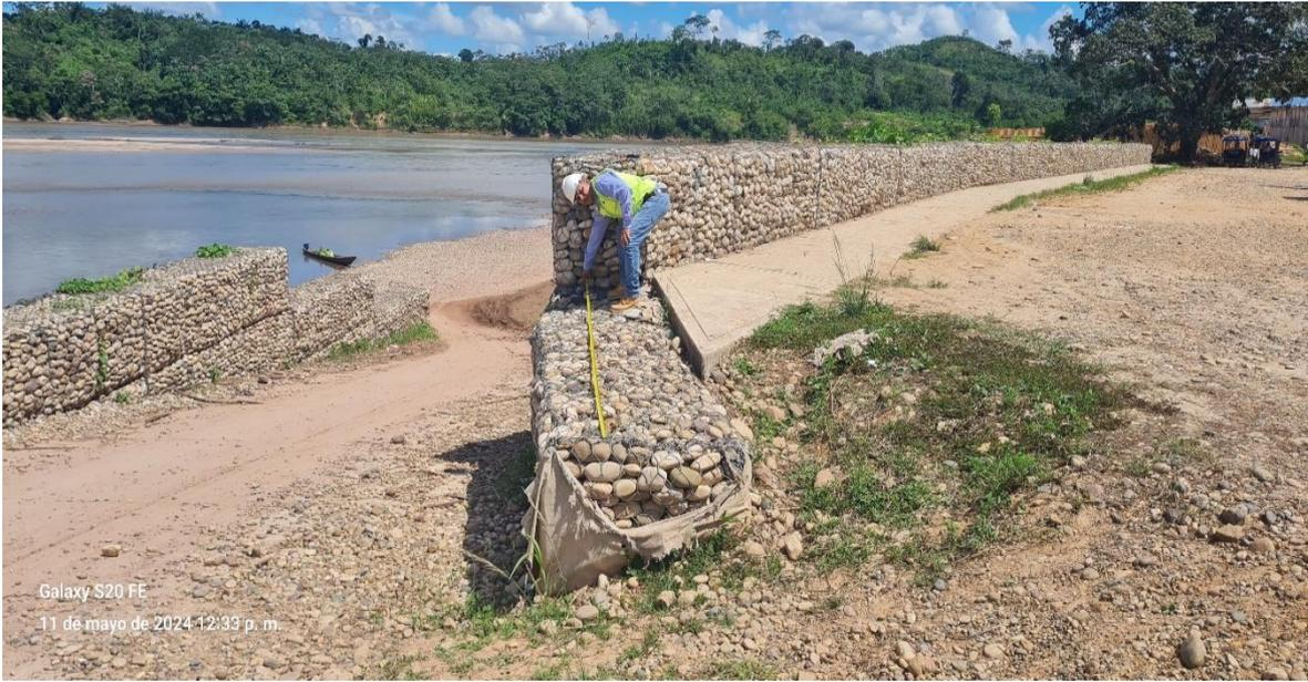
**Fotografía N°03:** Medición del largo del Gavión
