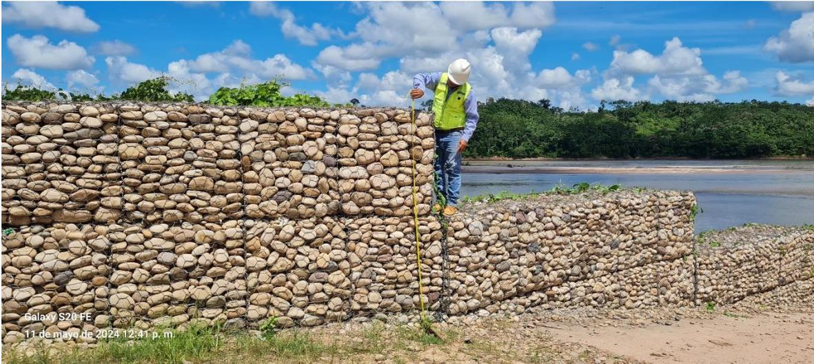
**Fotografía N°07:** Altura del muro de gaviones
