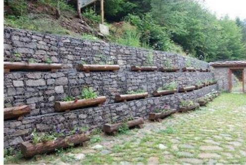
Figura 1. Estructura con gaviones. Fuente: <http://www.solucionesespeciales.net/MedioAmbiente/Gaviones/Gaviones.aspx>
