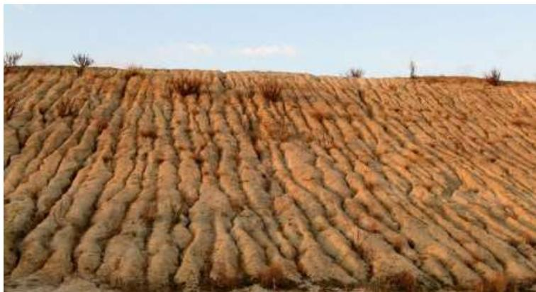
Figura 4 Erosión de Taludes
