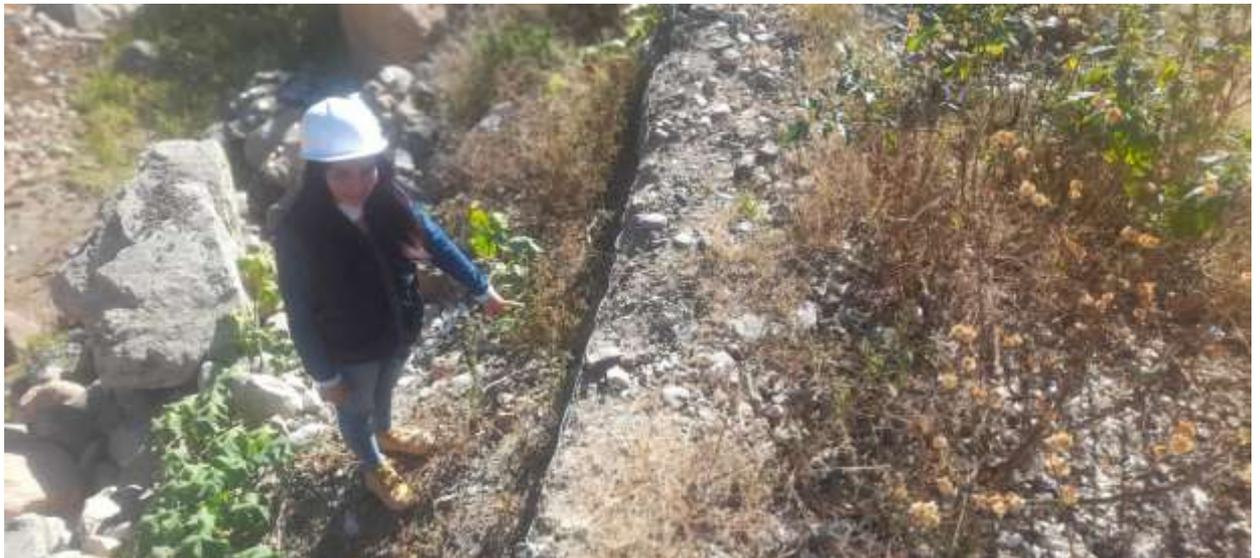
Fotografía 02: muro erosionado margen derecho sector Alizar
