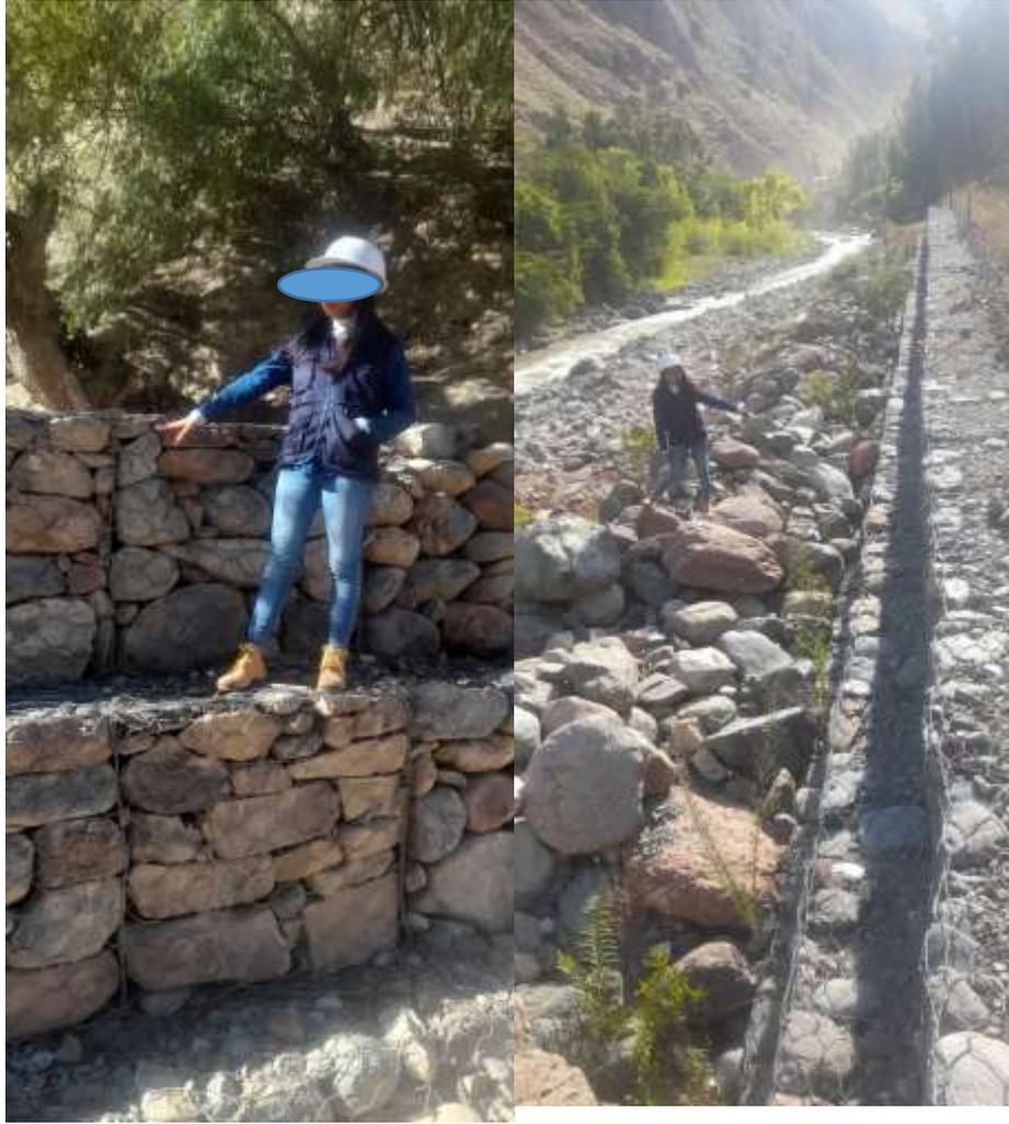
Fotografía 05: muro de gaviones parte noroeste del sector Alizar
