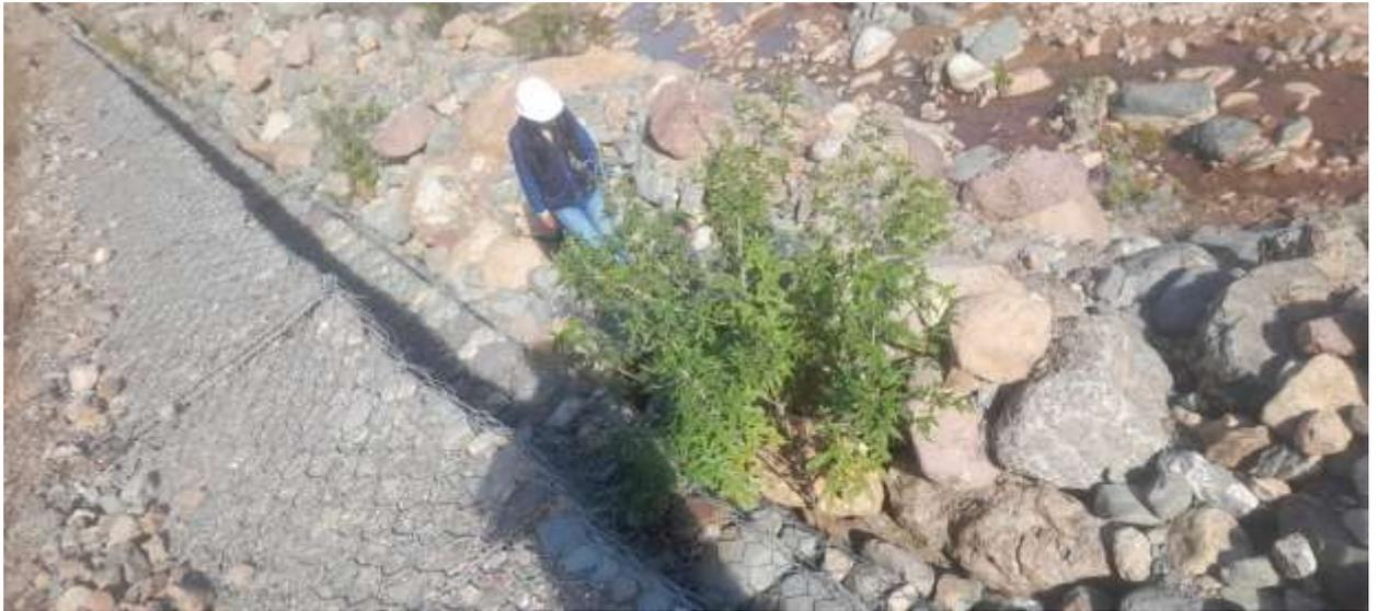
Fotografía 03: muro de gaviones diámetro de roca de 0.30 a 0.50
