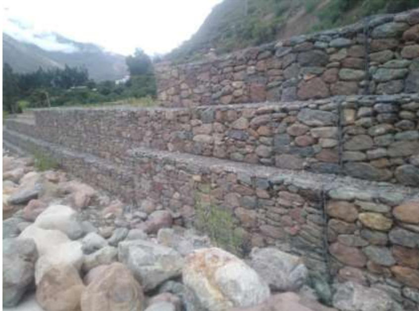
Fotografía 01: muro de gaviones parte noroeste del sector Alizar
