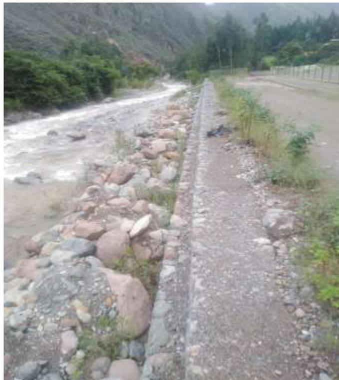
Fotografía 04: muro de gaviones margen derecho
