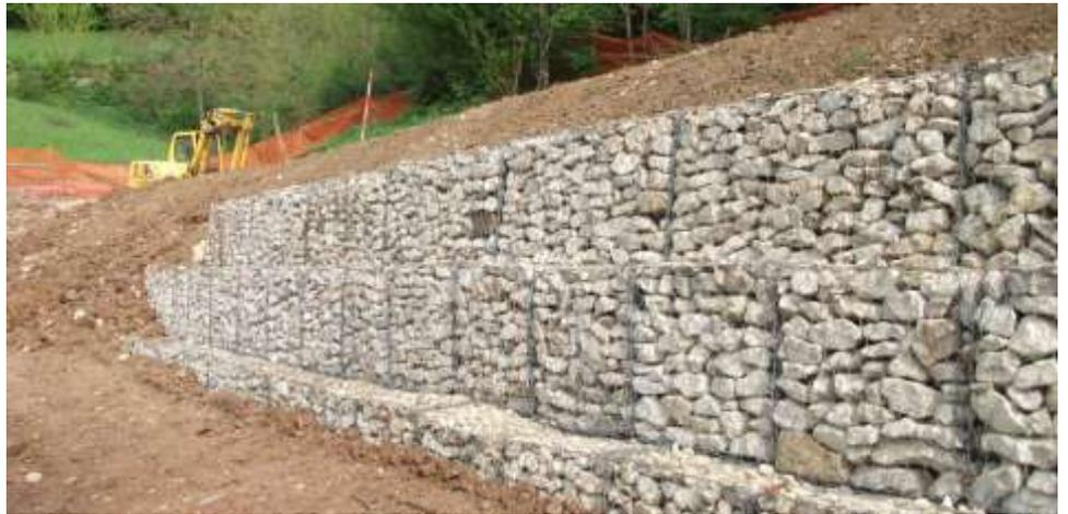
Figura 5 Muro de Gaviones
